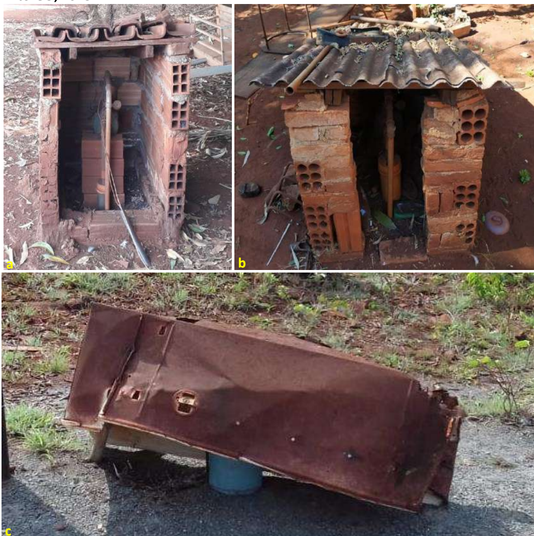
Foto 6.4 – Estrutura para abrigo de poço tubular raso, em alvenaria e telhado cerâmico (a), alvenaria e telhado de fibrocimento (b), e caixa metálica reutilizada (c), na Comunidade Santa Fé da Laguna, Barro Alto-GO, 2018.
