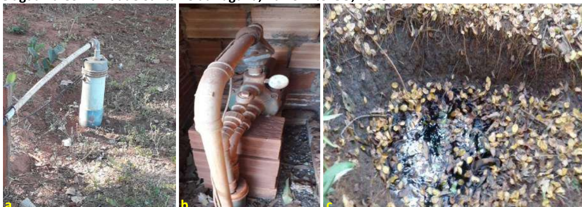
Foto 6.2 – Poço tubular profundo (a), poço tubular raso (b) e nascente (c) utilizados para obtenção de água na Comunidade Santa Fé da Laguna, Barro Alto-GO, 2018.
