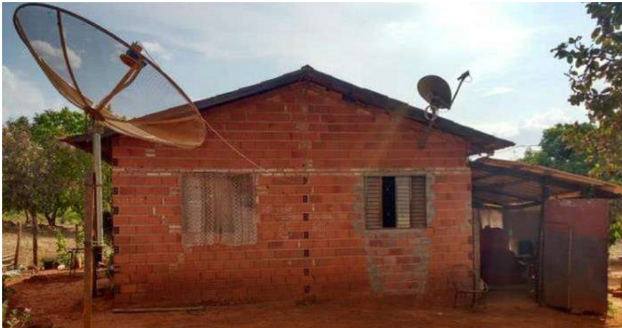
Foto 4.4 – Habitação construída de alvenaria sem reboco, identificada na Comunidade Santa Fé da Laguna-GO, 2018.
