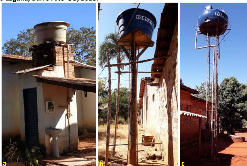
Foto 6.7 – Reservatório domiciliar em fibrocimento instalado sobre estrutura de alvenaria (a), de polietileno instalado sobre estrutura de madeira (b) e sobre estrutura metálica (c), na Comunidade Santa Fé da Laguna, Barro Alto-GO, 2018.
