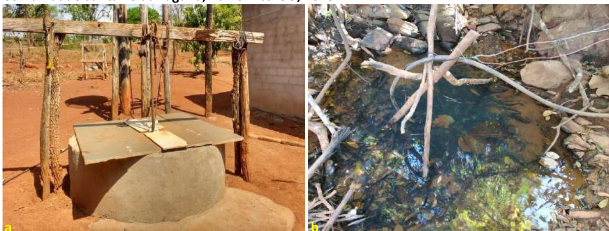
Foto 6.1 – Poço raso escavado (a) e manancial superficial (b) utilizados para obtenção de água na Comunidade Santa Fé da Laguna, Barro Alto-GO, 2018.
