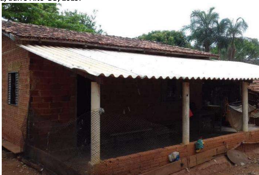
Foto 4.10 – Cobertura de telha de fibrocimento e telha de barro, identificada na Comunidade Santa Fé da Laguna, Barro Alto-GO, 2019.
