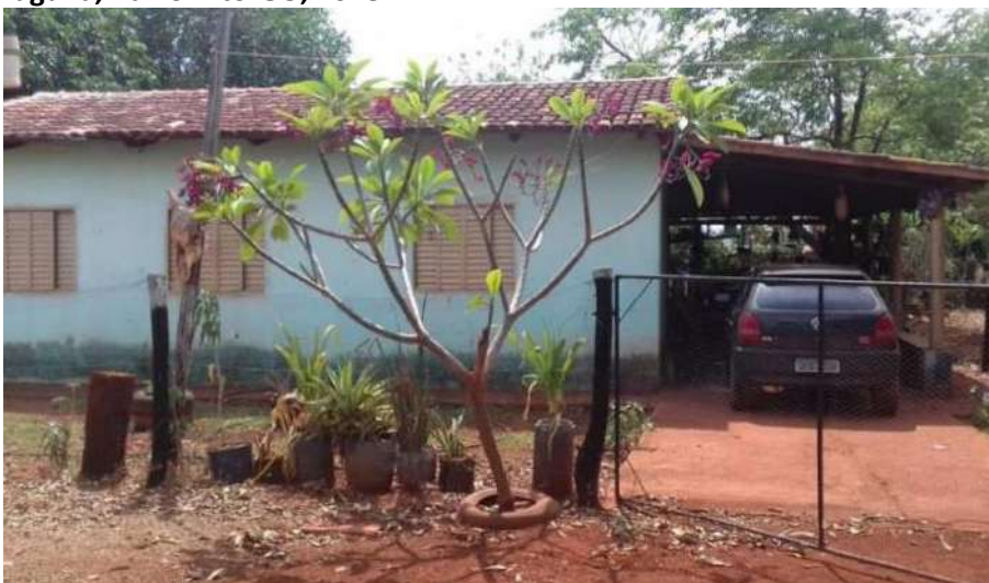
Foto 4.6 – Habitação construída de alvenaria com reboco e pintura, identificada na Comunidade Santa Fé da Laguna, Barro Alto-GO, 2018.
