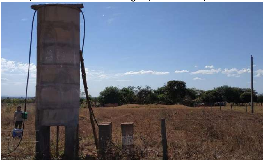
Foto 6.6 – Reservatório domiciliar construído com anéis de concreto e apoiado sobre pilares diretamente no solo, Comunidade Santa Fé da Laguna, Barro Alto-GO, 2018.
