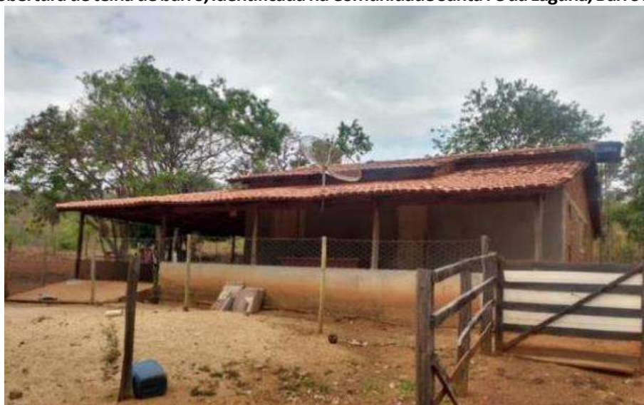
Foto 4.9 – Cobertura de telha de barro, identificada na Comunidade Santa Fé da Laguna, Barro Alto-GO, 2018.
