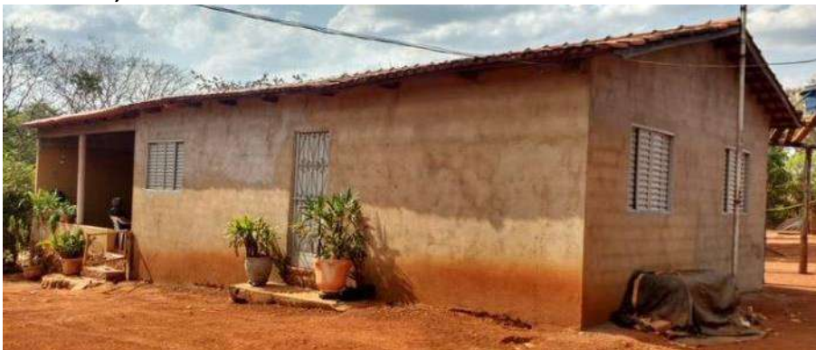
Foto 4.5 – Habitação construída de alvenaria com reboco, identificada na Comunidade Santa Fé da Laguna, Barro Alto-GO, 2018.
