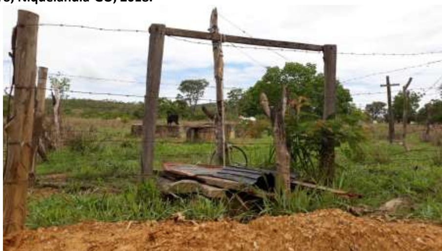
Foto 6.4 – Poço raso escavado cercado e tampado com material improvisado, na Comunidade Salto para o Futuro, Niquelândia-GO, 2018.
