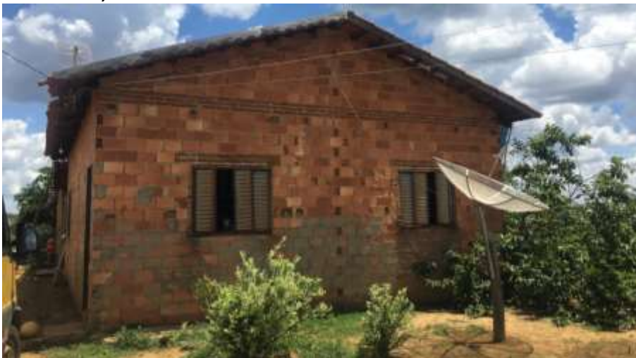
Foto 4.5 – Habitação construída de alvenaria sem reboco, identificada na Comunidade Salto para o Futuro, Niquelândia-GO, 2018.
