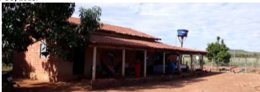
Foto 4.11 – Cobertura de telha de barro, identificada na Comunidade Salto para o Futuro, Niquelândia-GO, 2018.
