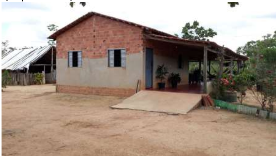
Foto 4.10 – Piso de residência constituído de cimento queimado, identificado na Comunidade Salto para o Futuro, Niquelândia-GO, 2018.
