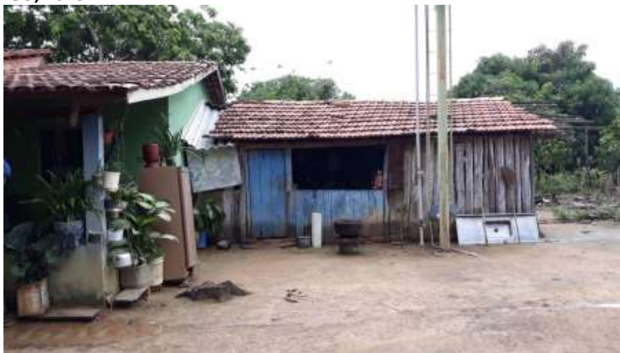
Foto 4.7 – Habitação construída de pau a pique, identificada na Comunidade Salto para o Futuro, Niquelândia-GO, 2018.
