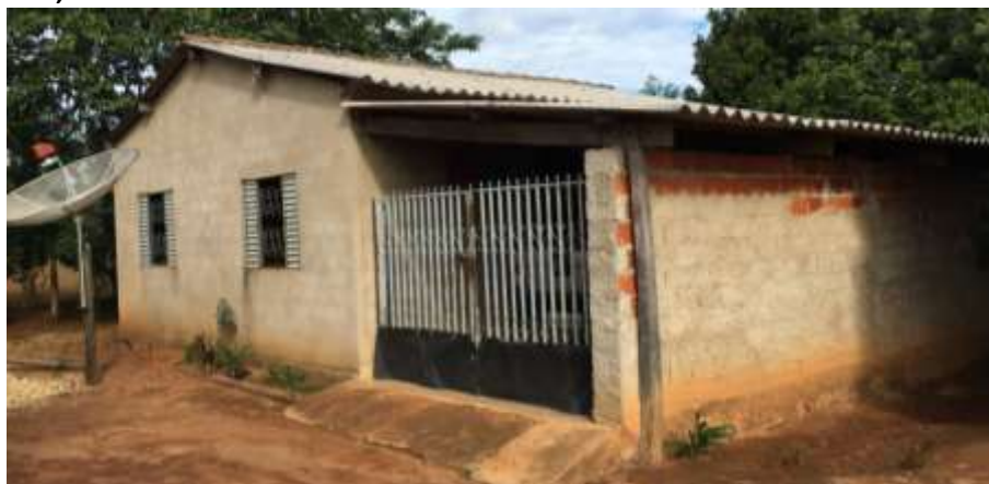
Foto 4.12 – Cobertura de fibrocimento, identificada na Comunidade Salto para o Futuro, Niquelândia-GO, 2018.
