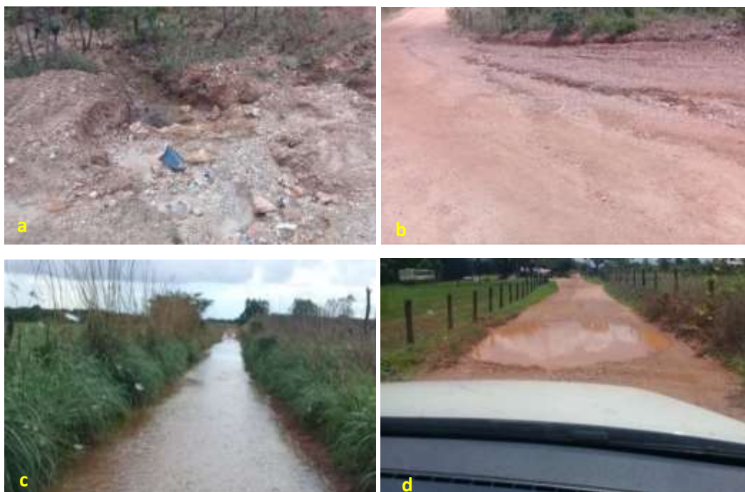
Foto 6.17 – Processos erosivos na margem da via (a) e na via de acesso (b) e pontos de alagamento (c), (d) na vida de acesso à Comunidade Salto para o Futuro, Niquelândia-GO, 2018.
