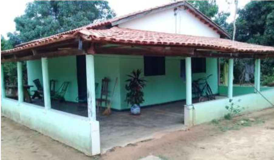
Foto 4.3 – Habitação construída de alvenaria com reboco e pintura, identificada na Comunidade Salto para o Futuro, Niquelândia-GO, 2018.
