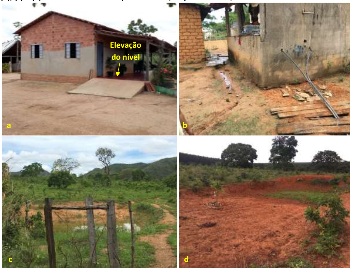
Foto 6.20 – Dispositivos de prevenção dos danos provocados pelas águas em residência (a) e lotes (b), (c) e (d) da Comunidade Salto para o Futuro, Niquelândia-GO, 2018.
