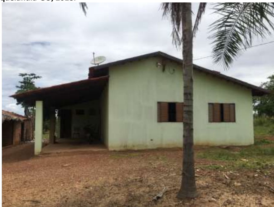
Foto 4.8 – Piso de residência constituído de concreto bruto, identificado na Comunidade Salto para o Futuro, Niquelândia-GO, 2018.
