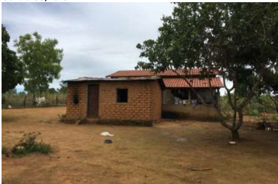
Foto 4.6 – Extensão habitacional construída de adobe, identificada na Comunidade Salto para o Futuro, Niquelândia-GO, 2018.
