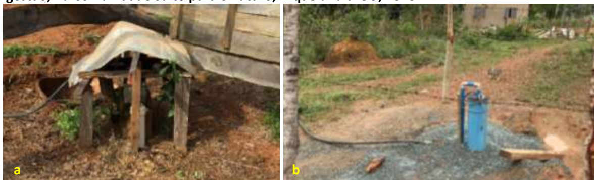
Foto 6.1 – Poço tubular raso (a) e poço tubular profundo (b) utilizados para a obtenção de água para ingestão, na Comunidade Salto para o Futuro, Niquelândia-GO, 2018.
