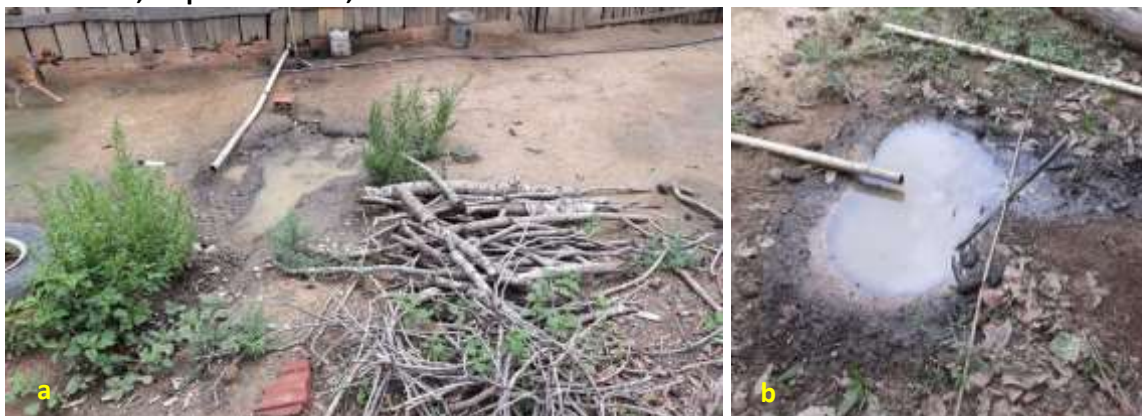
Foto 6.8 – Lançamento e acúmulo de água cinza proveniente da pia da cozinha e/ou do tanque de lavar roupas, diretamente no solo do quintal próximo aos domicílios (a) e (b), na Comunidade Salto para o Futuro, Niquelândia-GO, 2018.
