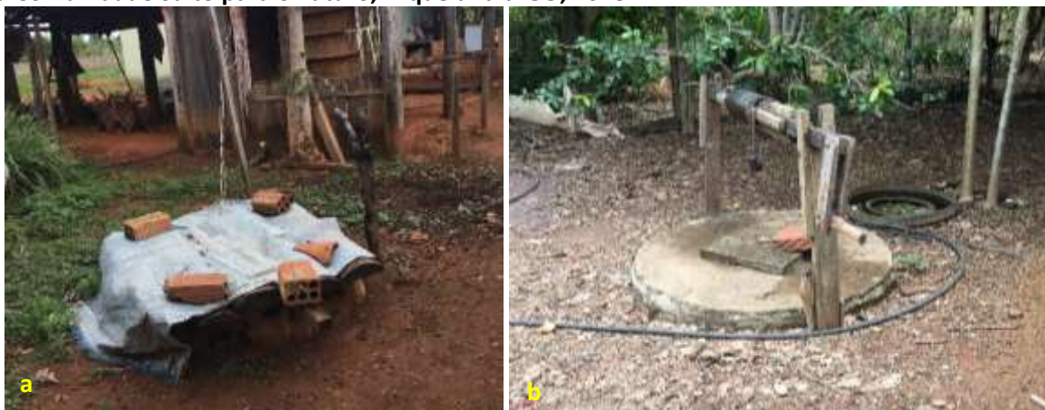
Foto 6.5 – Poço raso escavado tampado com material improvisado (a) e com tampa de concreto (b), na Comunidade Salto para o Futuro, Niquelândia-GO, 2018.
