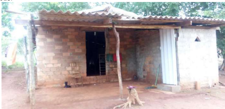
Foto 4.6 – Telha de fibrocimento, identificada nas habitações da Comunidade Rosa Luxemburgo, Faina-GO, 2018.
