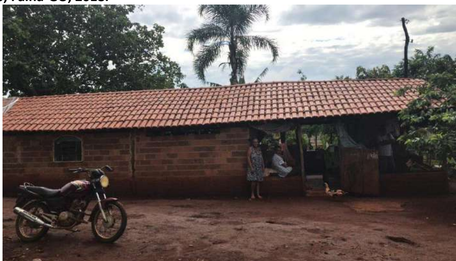
Foto 4.2 – Habitação construída de alvenaria sem reboco, identificada na Comunidade Rosa Luxemburgo, Faina-GO, 2018.
