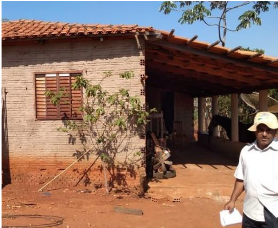
Foto 4.4 – Piso de residências no concreto bruto, identificado na Comunidade Rochedo, Professor Jamil-GO, 2018.
