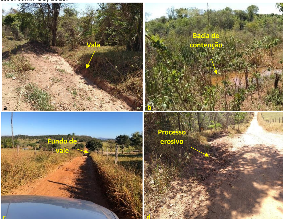
Foto 6.19 – Situação da drenagem pluvial na via de acesso: vala de infiltração (a), bacia de contenção (b), fundo de vale (c) e processo erosivo na margem da via de acesso (d) na Comunidade Rochedo, Professor Jamil-GO, 2018.
