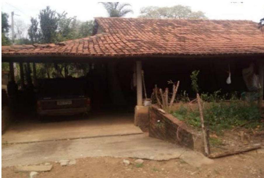
Foto 4.8 – Cobertura de telha de barro, identificada na Comunidade Rochedo, Professor Jamil-GO, 2019.
