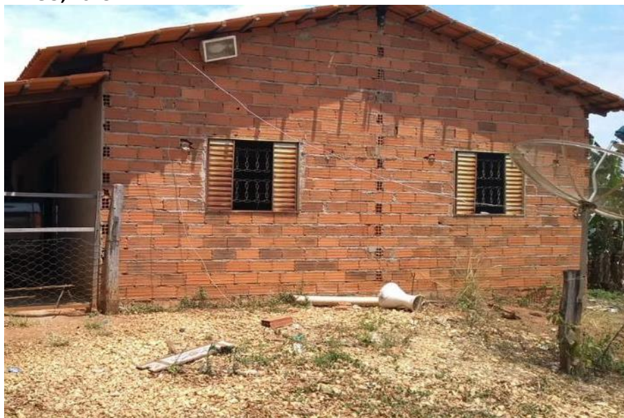
Foto 4.1 – Habitação construída de alvenaria sem reboco, identificada na Comunidade Rochedo, Professor Jamil-GO, 2018.
