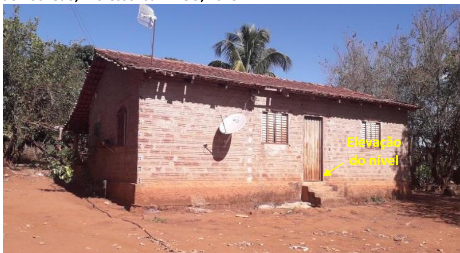
Foto 6.22 – Dispositivo de prevenção dos danos provocados pelas águas em residência da Comunidade Rochedo, Professor Jamil-GO, 2018.
