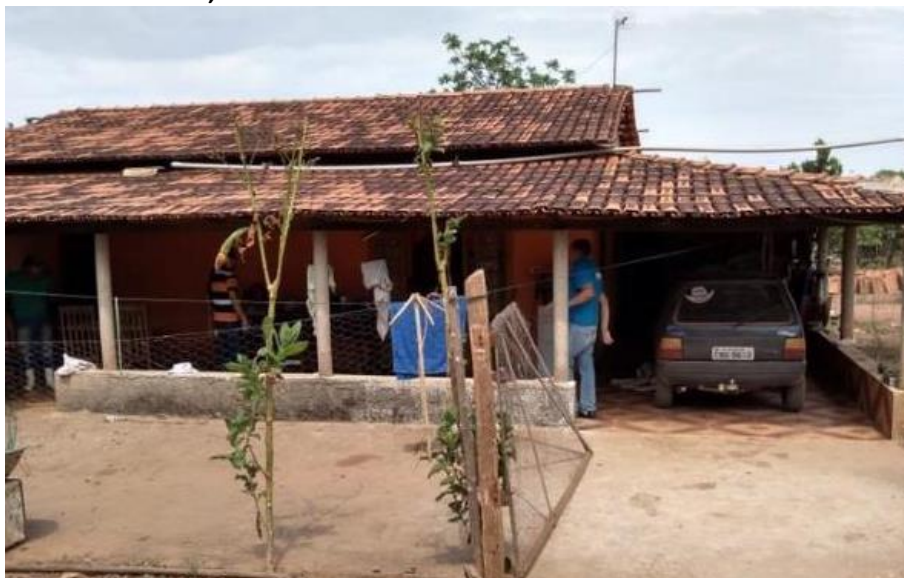
Foto 4.3 – Habitação construída de alvenaria com reboco e pintura, identificada na Comunidade Rochedo, Professor Jamil-GO, 2018.
