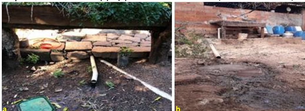
Foto 6.9 – Lançamento e acúmulo de água cinza proveniente da pia da cozinha diretamente no solo do quintal próximo aos domicílios (a) e (b) na Comunidade Rochedo, Professor Jamil-GO, 2018.
