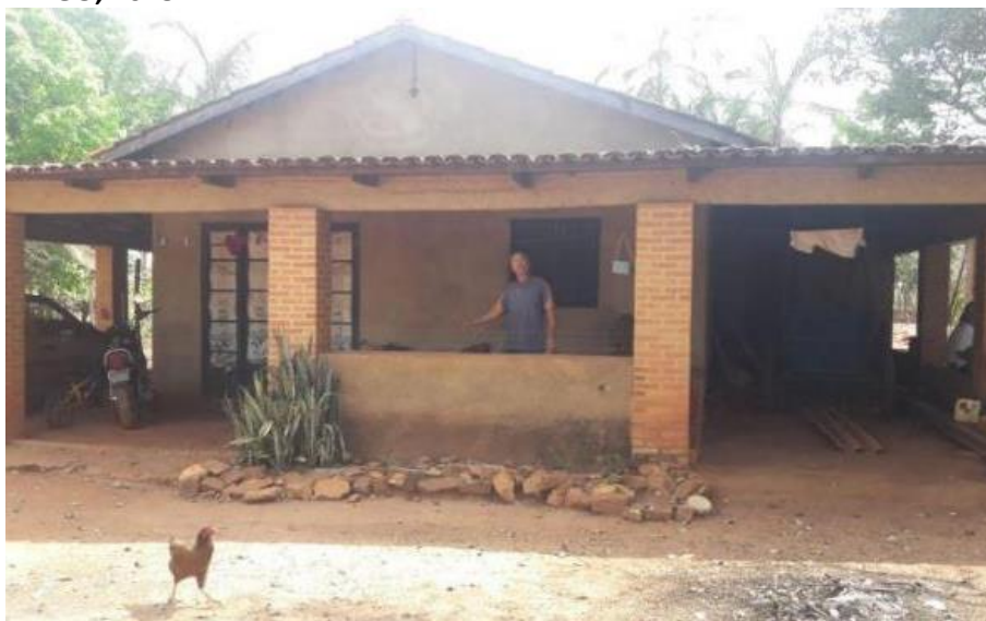
Foto 4.2 – Habitação construída de alvenaria com reboco, identificada na Comunidade Rochedo, Professor Jamil-GO, 2018.
