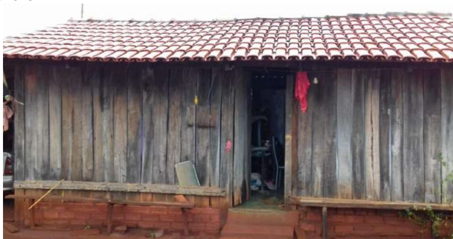
Foto 4.14 – Habitação construída de madeira, identificada na Comunidade Roberto Martins de Melo, Minaçu-GO, 2018.
