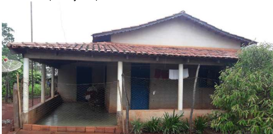
Foto 4.17 – Piso de residência constituído de cimento queimado, identificado na Comunidade Roberto Martins de Melo, Minaçu-GO, 2018.
