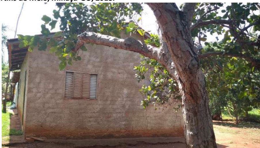
Foto 4.12 – Habitação construída de alvenaria com reboco sem pintura, identificada na Comunidade Roberto Martins de Melo, Minaçu-GO, 2018.
