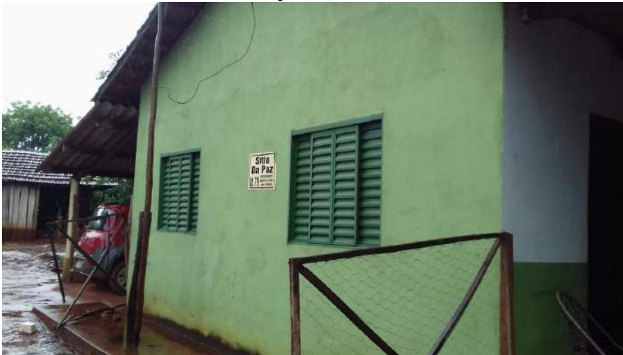
Foto 4.20 – Cobertura de fibrocimento em associação com telha de barro, identificada na Comunidade Roberto Martins de Melo, Minaçu-GO, 2018.
