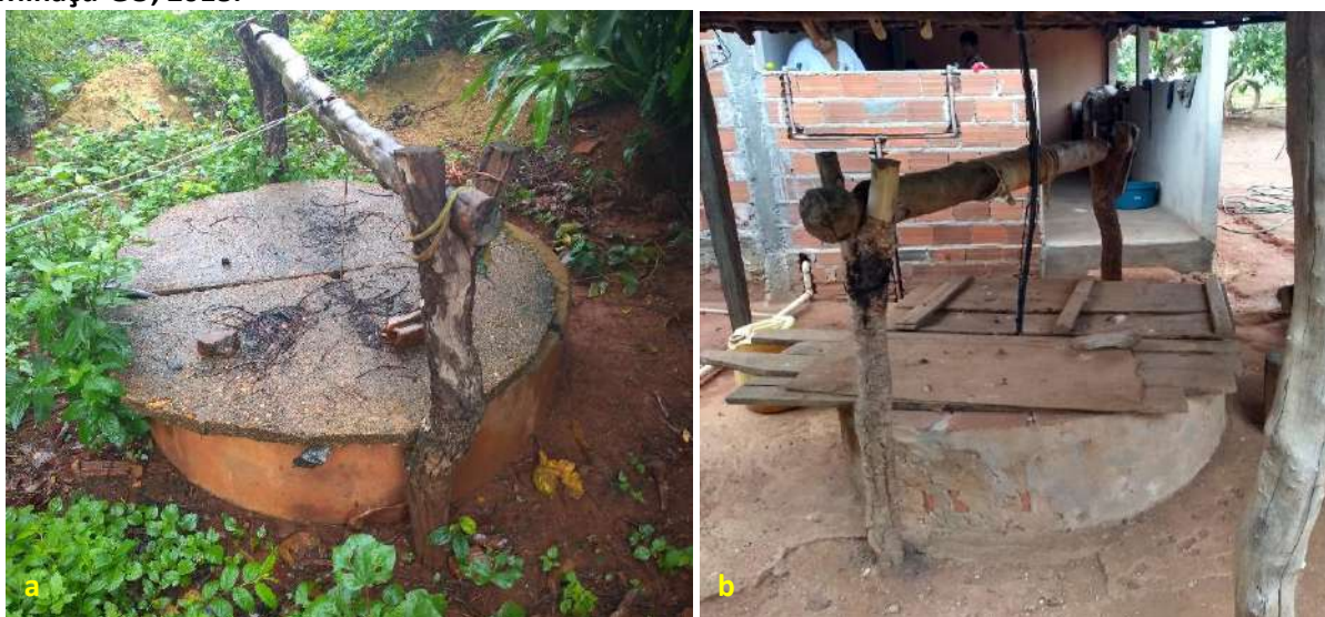
Foto 6.2 – Poços rasos escavados com mureta de proteção, tampado com tampa de concreto (a) e de forma improvisada, com tábuas e pedaços de madeira (b), na Comunidade Roberto Martins Melo, Minaçu-GO, 2018.
