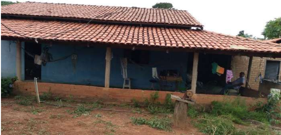
Foto 4.20 – Cobertura de fibrocimento em associação com telha de barro, identificada na Comunidade Roberto Martins de Melo, Minaçu-GO, 2018.
