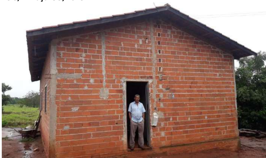
Foto 4.13 – Habitação construída de alvenaria sem reboco, identificada na Comunidade Roberto Martins de Melo, Minaçu-GO, 2018.
