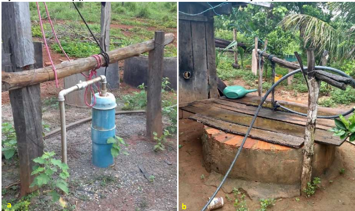
Foto 6.1 – Fontes de abastecimento de água utilizadas para ingestão: poço tubular profundo (a) e poço raso escavado (b), na Comunidade Roberto Martins Melo, Minaçu-GO, 2018.
