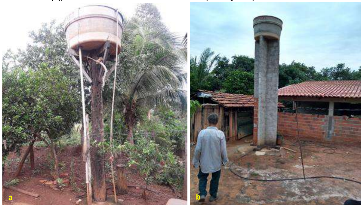
Foto 6.3 – Reservatórios domiciliares de fibrocimento sobre estrutura em madeira (a) e estrutura em alvenaria (b), na Comunidade Roberto Martins Melo, Minaçu-GO, 2018.
