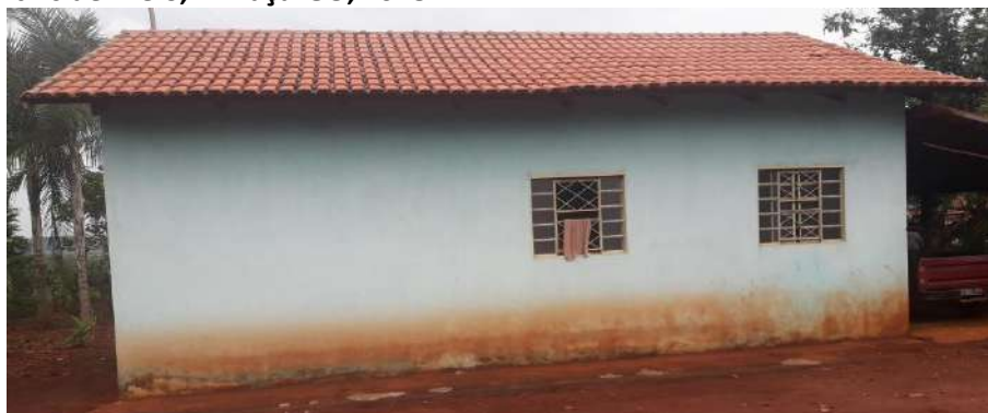
Foto 4.11 – Habitação construída de alvenaria com reboco e pintura, identificada na Comunidade Roberto Martins de Melo, Minaçu-GO, 2018.
