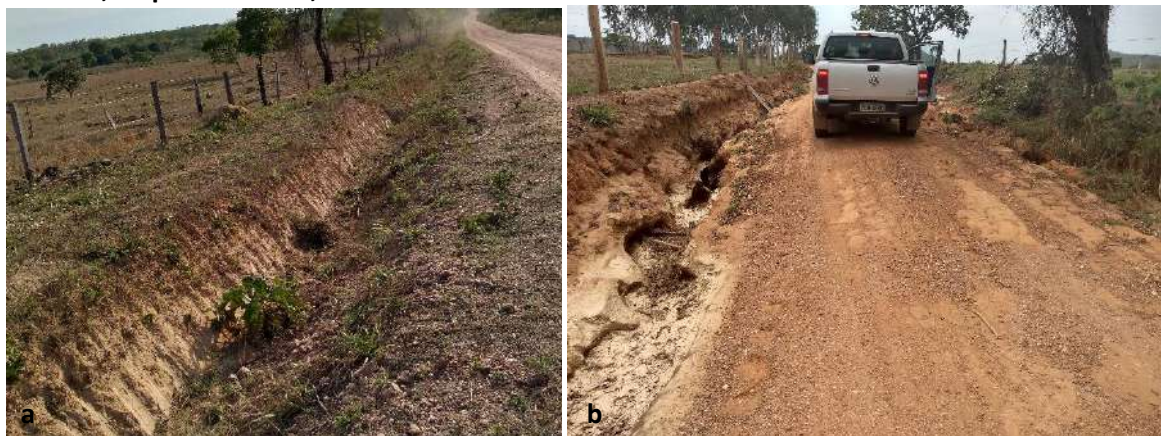
Foto 6.18 – Vala de infiltração (a) e processo erosivo (b) na via de acesso à Comunidade Rio Vermelho, Niquelândia-GO, 2018.
