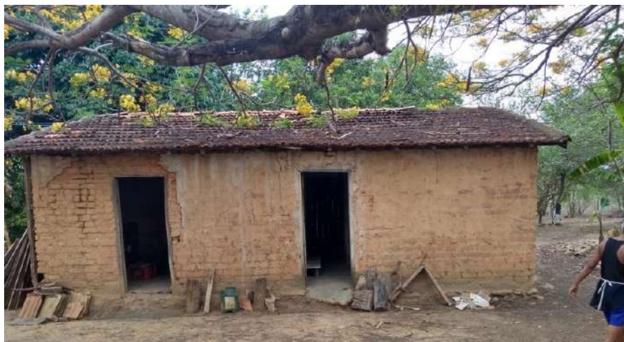
Foto 4.12 – Habitação construída de adobe, identificada na Comunidade Rio Vermelho, Niquelândia-GO, 2018.
