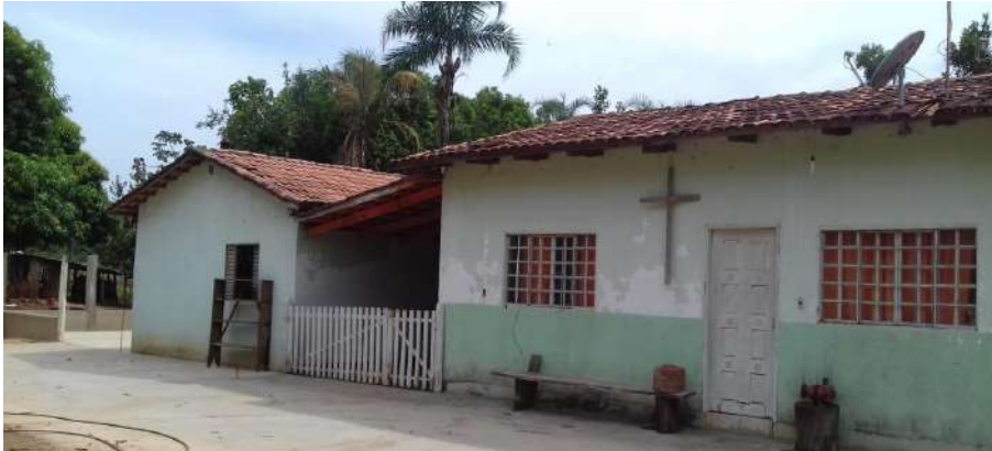
Foto 4.9 – Habitação construída de alvenaria com reboco e pintura, identificada na Comunidade Rio Vermelho, Niquelândia-GO, 2018.
