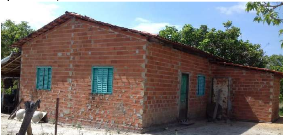
Foto 4.11 – Habitação construída de alvenaria sem reboco, identificada na Comunidade Rio Vermelho, Niquelândia-GO, 2018.
