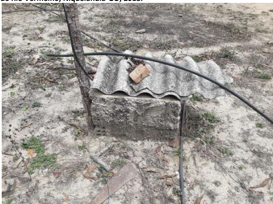
Foto 6.3 – Estrutura em alvenaria com telhado em fibrocimento do poço tubular raso, na Comunidade Rio Vermelho, Niquelândia-GO, 2018.
