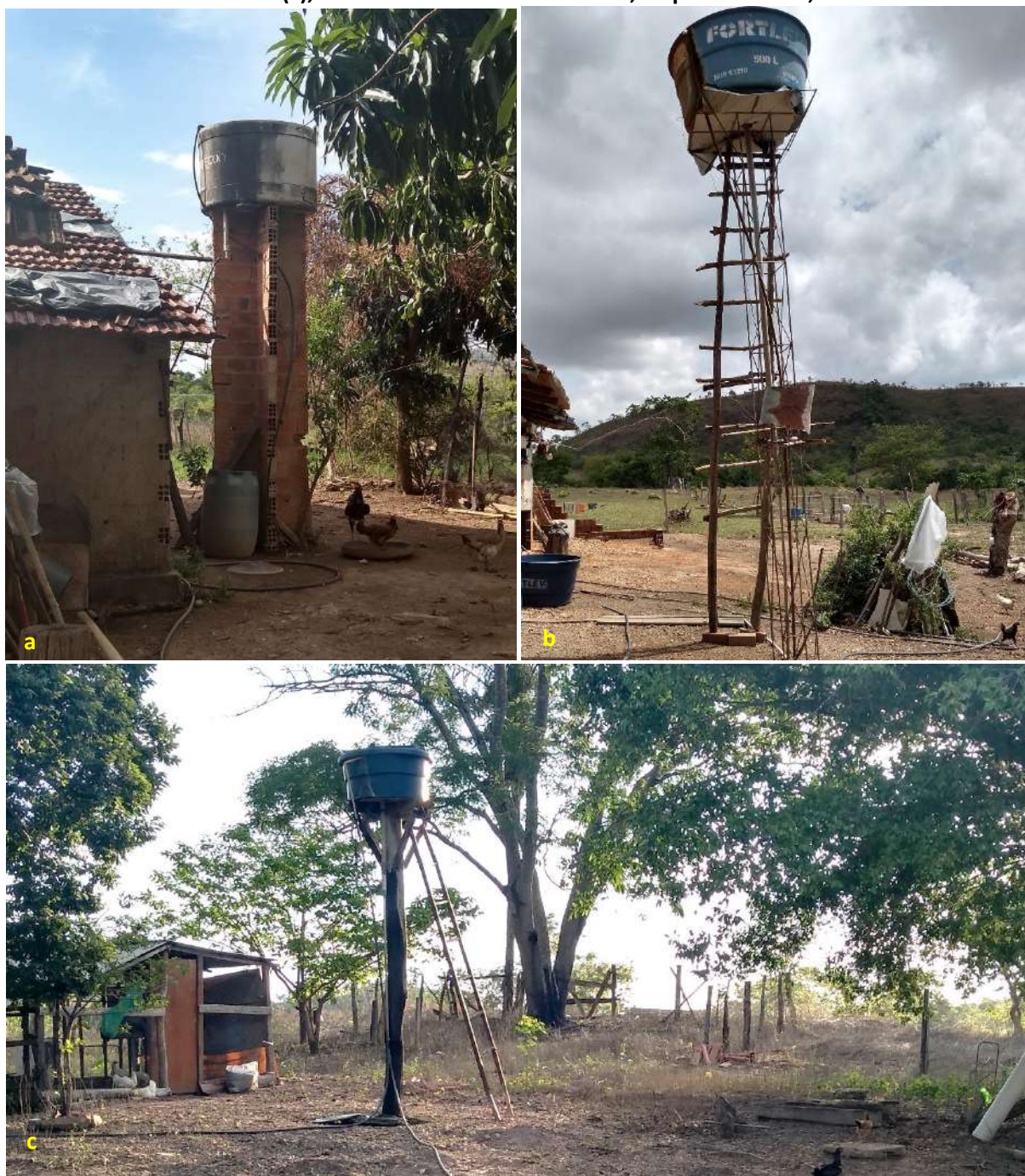
Foto 6.7 – Reservatório em fibrocimento, instalado sobre uma estrutura em alvenaria (a), reservatório em fibra de vidro sobre uma estrutura metálica (b) e reservatório em polietileno sobre uma estrutura de madeira (c), na Comunidade Rio Vermelho, Niquelândia-GO, 2018.
