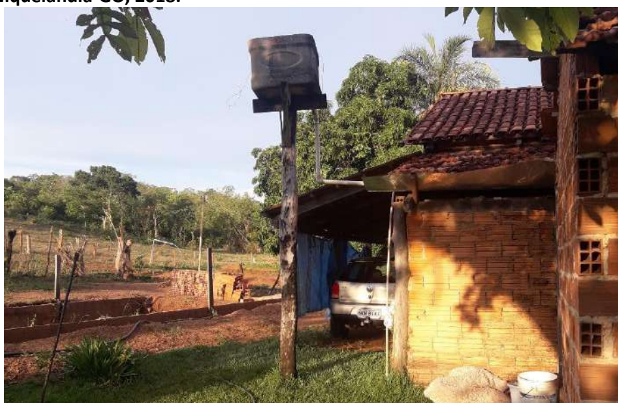
Foto 6.6 – Unidade familiar dotada de um único reservatório em fibrocimento, na Comunidade Rio Vermelho, Niquelândia-GO, 2018.
