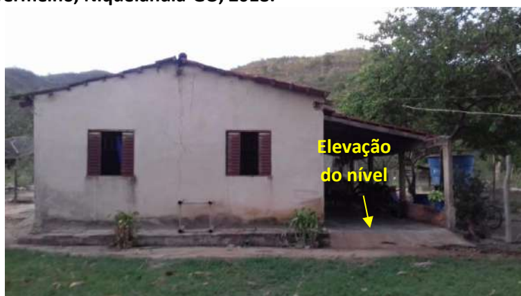
Foto 6.23 – Dispositivo de prevenção dos danos provocados pelas águas em residência da Comunidade Rio Vermelho, Niquelândia-GO, 2018.
