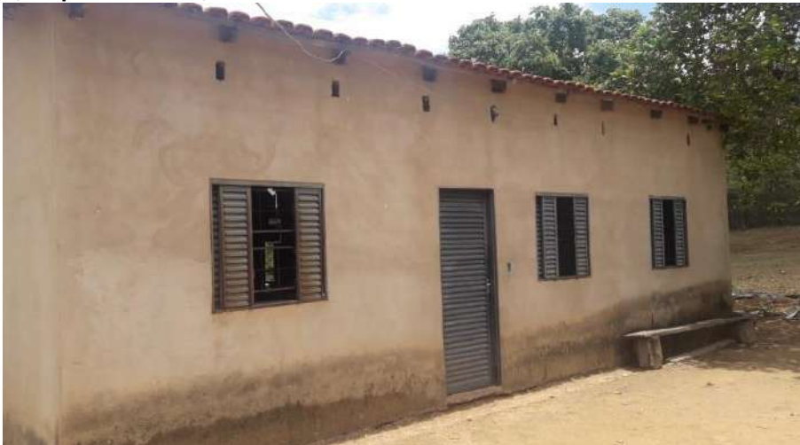
Foto 4.10 – Habitação construída de alvenaria com reboco sem pintura, identificada na Comunidade Rio Vermelho, Niquelândia-GO, 2018.
