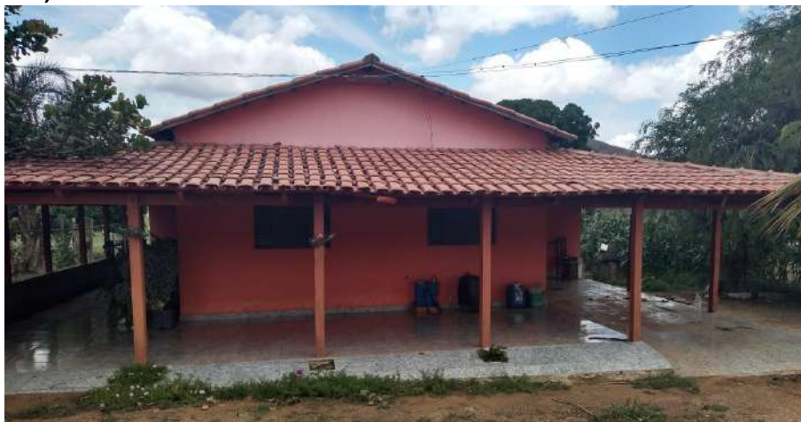
Foto 4.14 – Piso de residência constituído de cerâmica, identificado na Comunidade Rio Vermelho, Niquelândia-GO, 2018.
