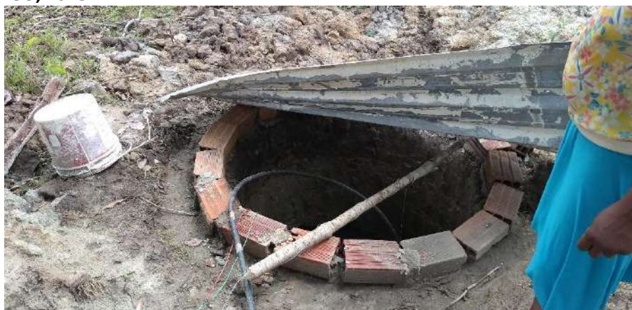
Foto 6.2 – Poço raso escavado tampado com telha de zinco, na Comunidade Rio Vermelho, Niquelândia-GO, 2018.
