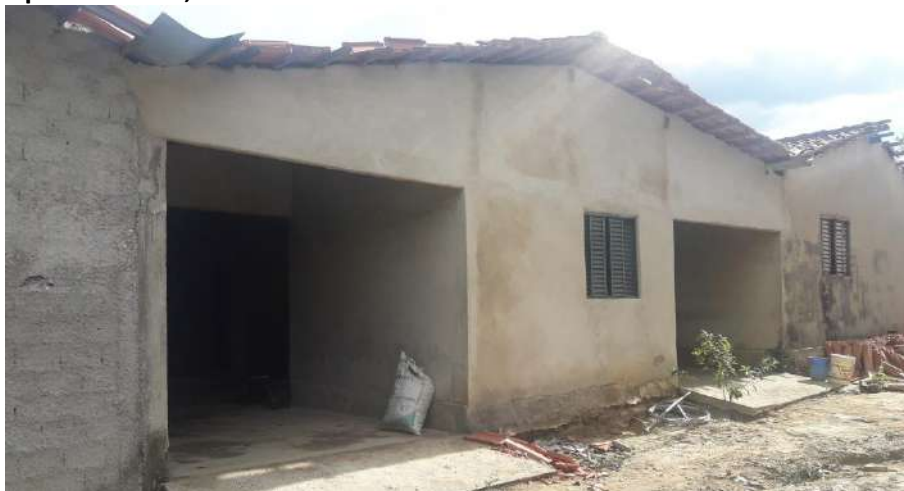
Foto 4.13 – Piso de residência constituído de concreto bruto, identificado na Comunidade Rio Vermelho, Niquelândia-GO, 2018.
