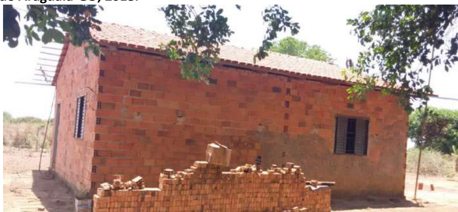
Foto 4.5 – Habitação construída de alvenaria sem reboco, identificada na Comunidade Rio Araguaia, São Miguel do Araguaia-GO, 2018.
