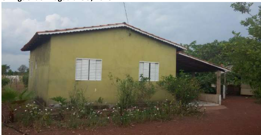
Foto 4.7 – Habitação construída de alvenaria com reboco e pintura, identificada na Comunidade Rio Araguaia, São Miguel do Araguaia-GO, 2018.
