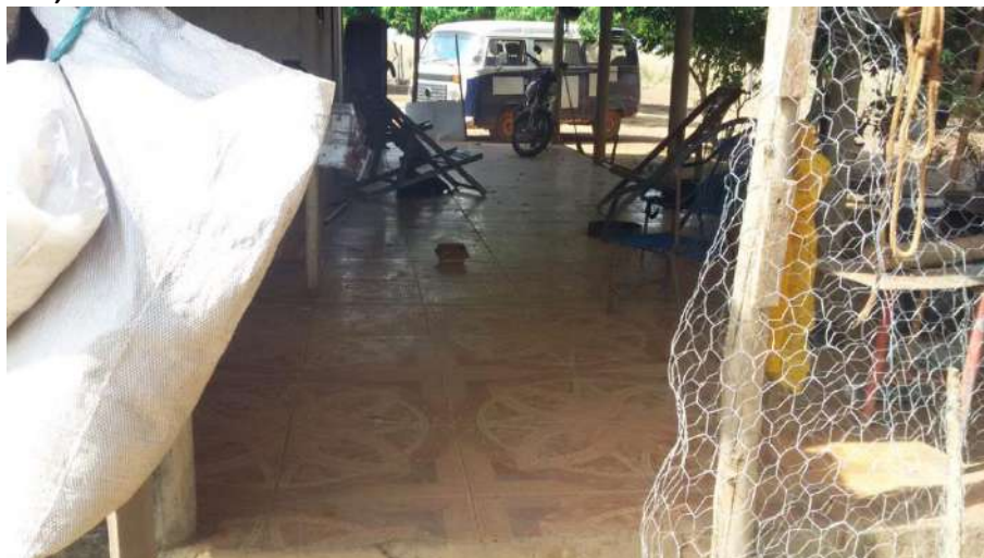
Foto 4.9 – Piso de cerâmica, identificado nas habitações da Comunidade Rio Araguaia, São Miguel do Araguaia-GO, 2018.
