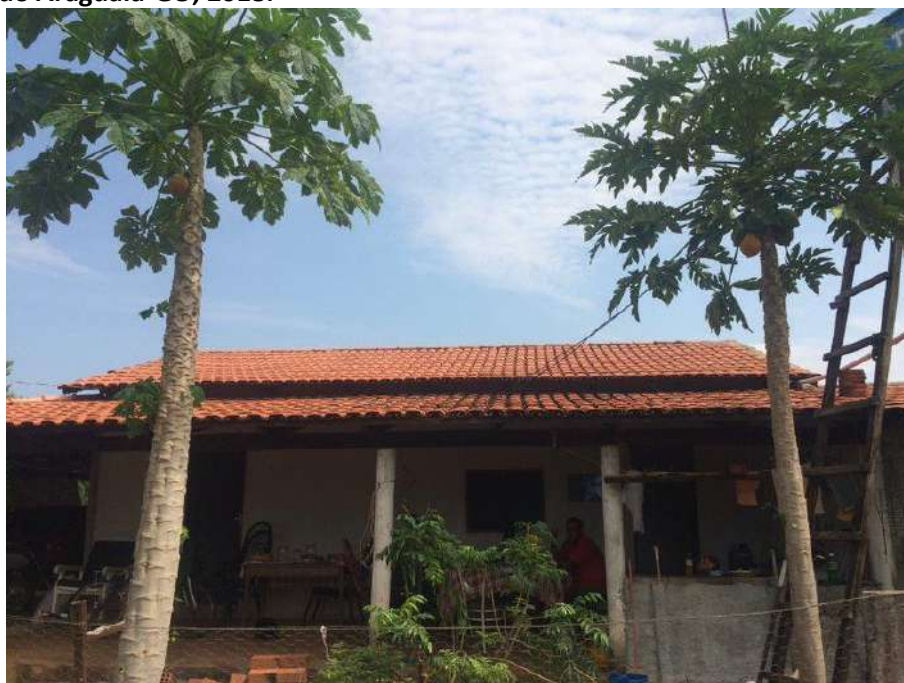
Foto 4.10 – Cobertura de telha de barro, identificada nas habitações da Comunidade Rio Araguaia, São Miguel do Araguaia-GO, 2018.
