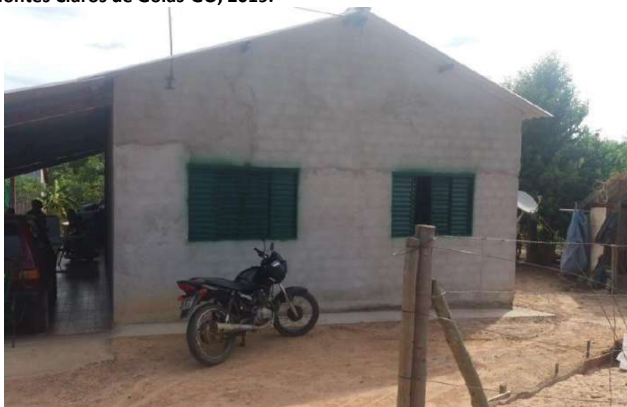
Foto 4.8 – Habitação construída de alvenaria com reboco, identificada na Comunidade Registro do Araguaia, Montes Claros de Goiás-GO, 2019.
