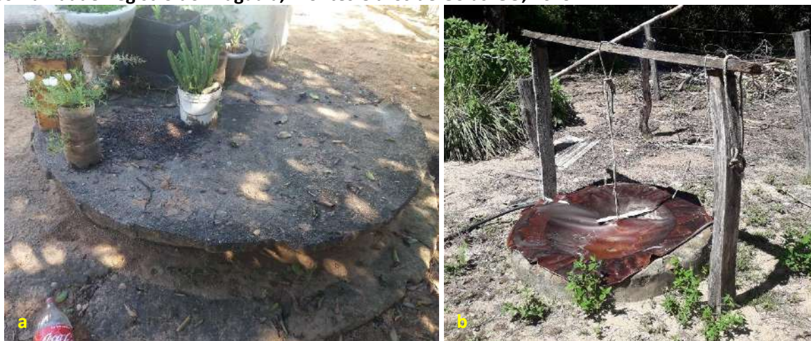
Foto 6.4 – Poços rasos escavados com muretas e tampa de concreto (a) e tampa de lona (b) na Comunidade Registro do Araguaia, Montes Claros de Goiás-GO, 2019.
