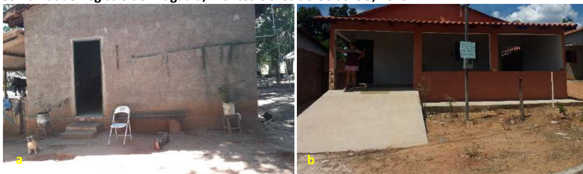
Foto 6.26 – Dispositivos de prevenção dos danos provocados pelas águas em residências da Comunidade Registro do Araguaia, Montes Claros de Goiás-GO, 2019.
