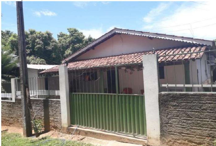
Foto 4.12 – Cobertura de telha de barro, identificada na Comunidade Registro do Araguaia, Montes Claros de Goiás-GO, 2019.
