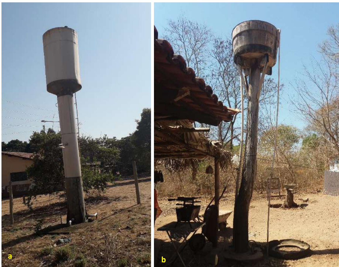
Foto 6.8 – Reservatório tipo taça construído em aço (a) e reservatório de fibrocimento instalado sobre estrutura de madeira (b) na Comunidade Registro do Araguaia, Montes Claros de Goiás-GO, 2019.
