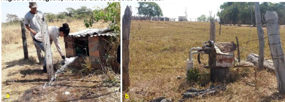
Foto 6.5 – Poços tubulares rasos cercados com abrigos construído em alvenaria e com cobertura de telhado de fibrocimento (a) e abrigo com estrutura improvisada de metal e lona (b) na Comunidade Registro do Araguaia, Montes Claros de Goiás-GO, 2019.
