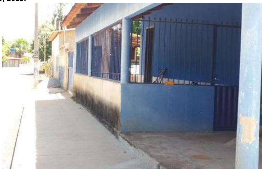
Foto 4.10 – Piso de concreto bruto, identificado na Comunidade Registro do Araguaia, Montes Claros de Goiás-GO, 2019.
