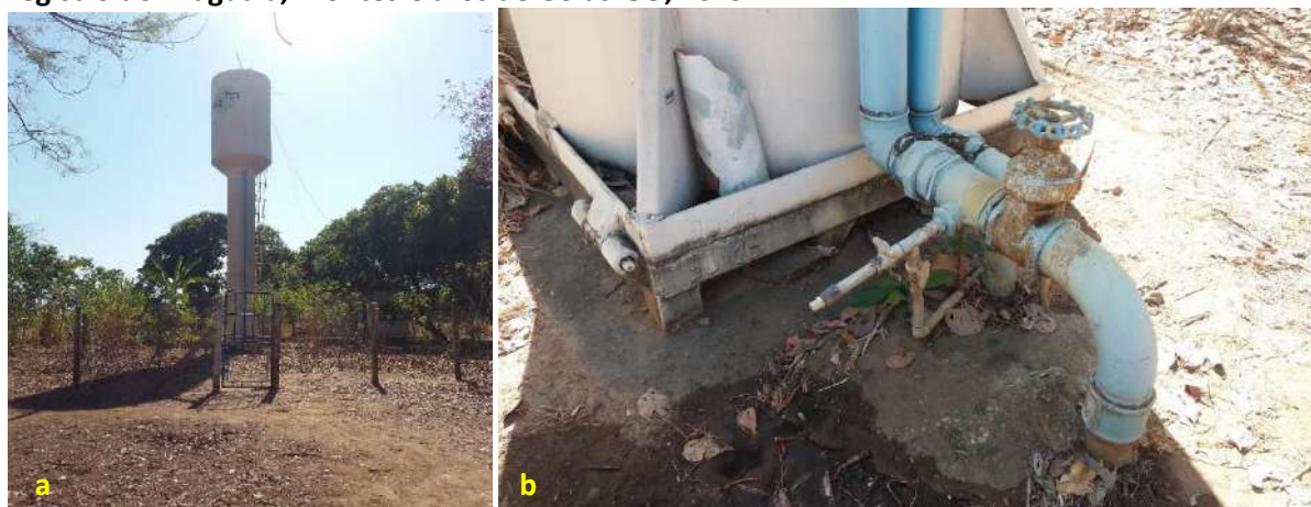
Foto 6.3 – Reservatório coletivo tipo taça construído em material metálico e devidamente cercado (a) e as tubulações de entrada e saída com algum desgaste nos dispositivos (b) na Comunidade Registro do Araguaia, Montes Claros de Goiás-GO, 2019.
