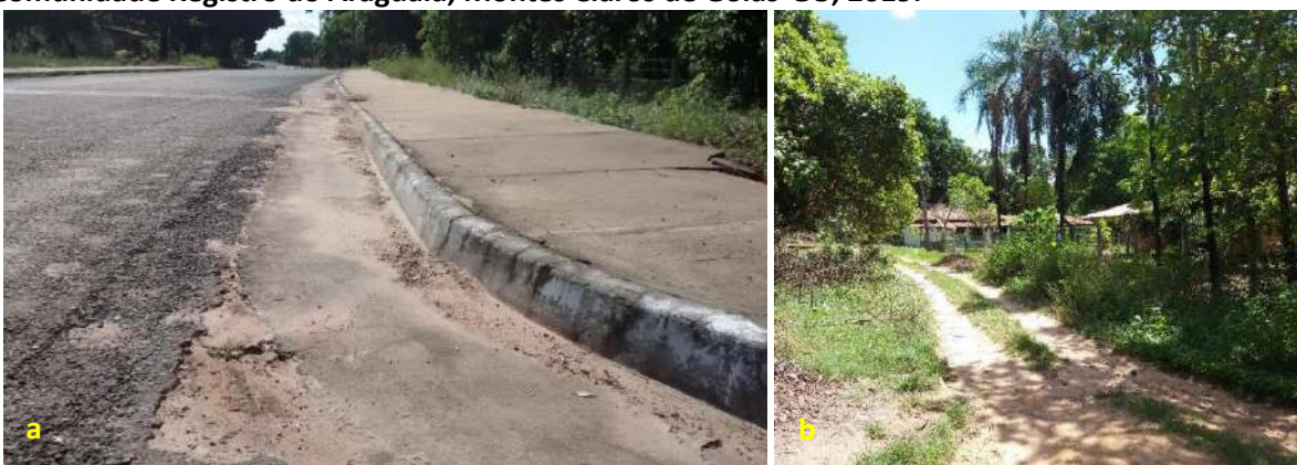
Foto 6.22 – Vias internas, pavimentada com meio fio e sarjeta (a) e não pavimentada (b), na Comunidade Registro do Araguaia, Montes Claros de Goiás-GO, 2019.
