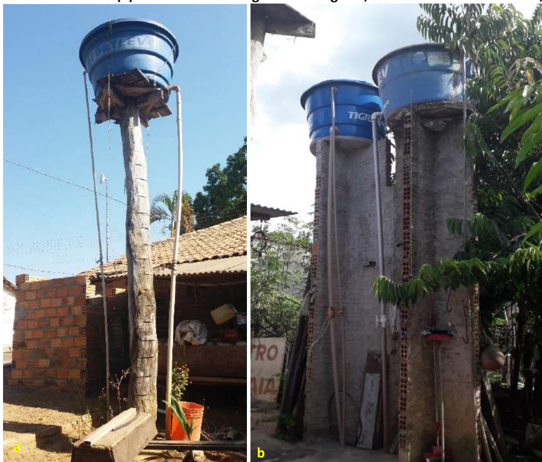
Foto 6.7 – Domicílios visitados com apenas um reservatório de polietileno fixado com arrame e instalado sobre estrutura de madeira (a) e reservatórios de fibra de vidro e polietileno sobre estruturas em alvenaria (b) na Comunidade Registro do Araguaia, Montes Claros de Goiás-GO, 2019.
