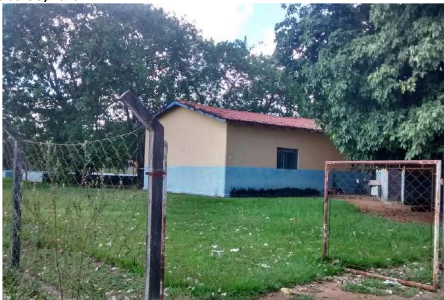
Foto 4.1 – Escola municipal desativada, identificada na Comunidade Registro do Araguaia, Montes Claros de Goiás-GO, 2019.
