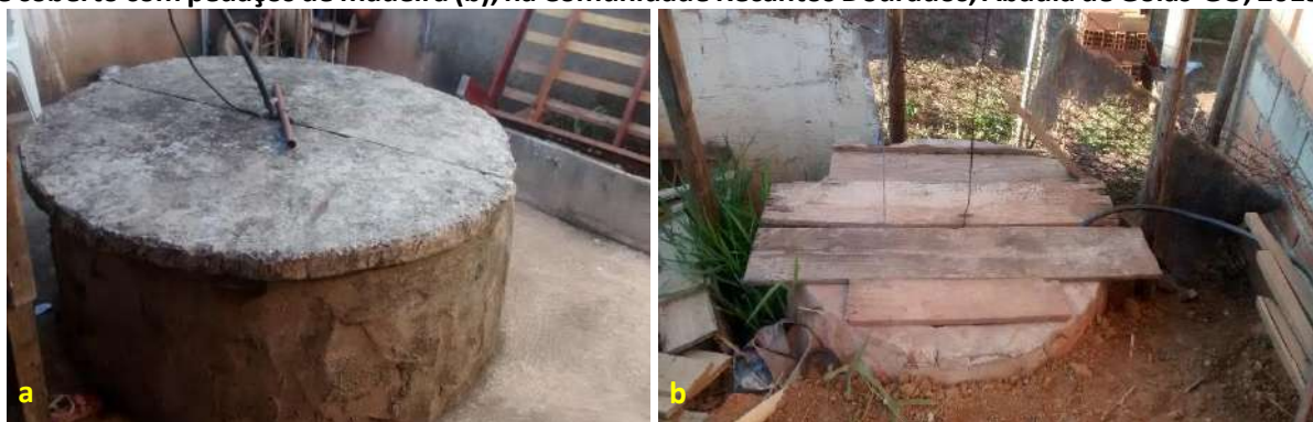
Foto 6.1 – Poços rasos escavados em diferentes condições, com existência de mureta de proteção, tampada e com calçamento ao redor (a), sem mureta de proteção, sem calçamento ao redor do poço e coberto com pedaços de madeira (b), na Comunidade Recantos Dourados, Abadia de Goiás-GO, 2019.
