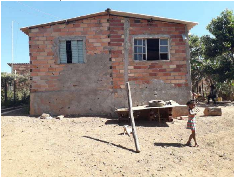
Foto 4.1 – Habitação construída de alvenaria sem reboco, identificada na Comunidade Recantos Dourados, Abadia de Goiás-GO, 2019.
