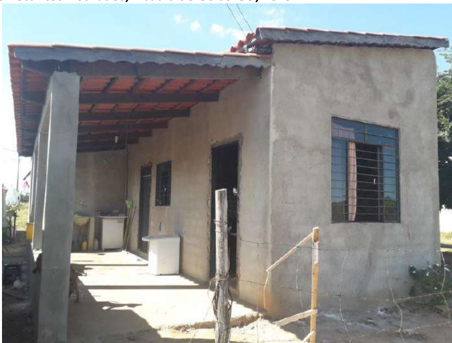
Foto 4.3 – Habitação construída de alvenaria com reboco, identificada nas habitações da Comunidade Recantos Dourados, Abadia de Goiás-GO, 2019.
