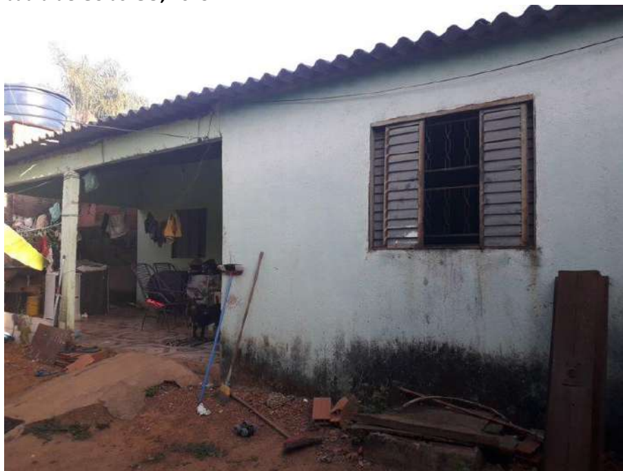
Foto 4.7 – Cobertura de telha de fibrocimento, identificada nas habitações da Comunidade Recantos Dourados, Abadia de Goiás-GO, 2019.
