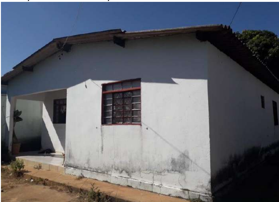
Foto 4.4 – Habitação construída de alvenaria com reboco e pintura, identificada na Comunidade Recantos Dourados, Abadia de Goiás-GO, 2019.
