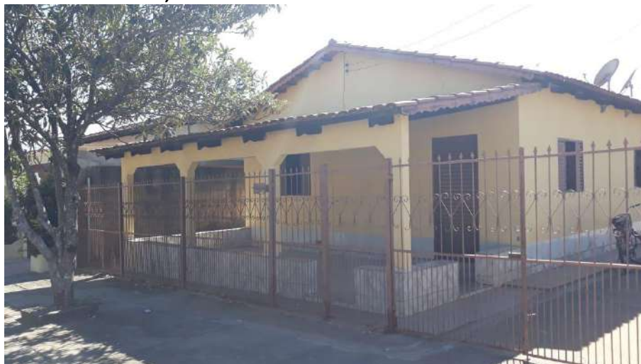
Foto 4.8 – Cobertura de telha de barro, identificada nas habitações da Comunidade Recantos Dourados, Abadia de Goiás-GO, 2019.
