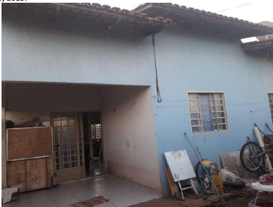
Foto 4.6 – Piso de cerâmica, identificado nas habitações da Comunidade Recantos Dourados, Abadia de Goiás-GO, 2019.
