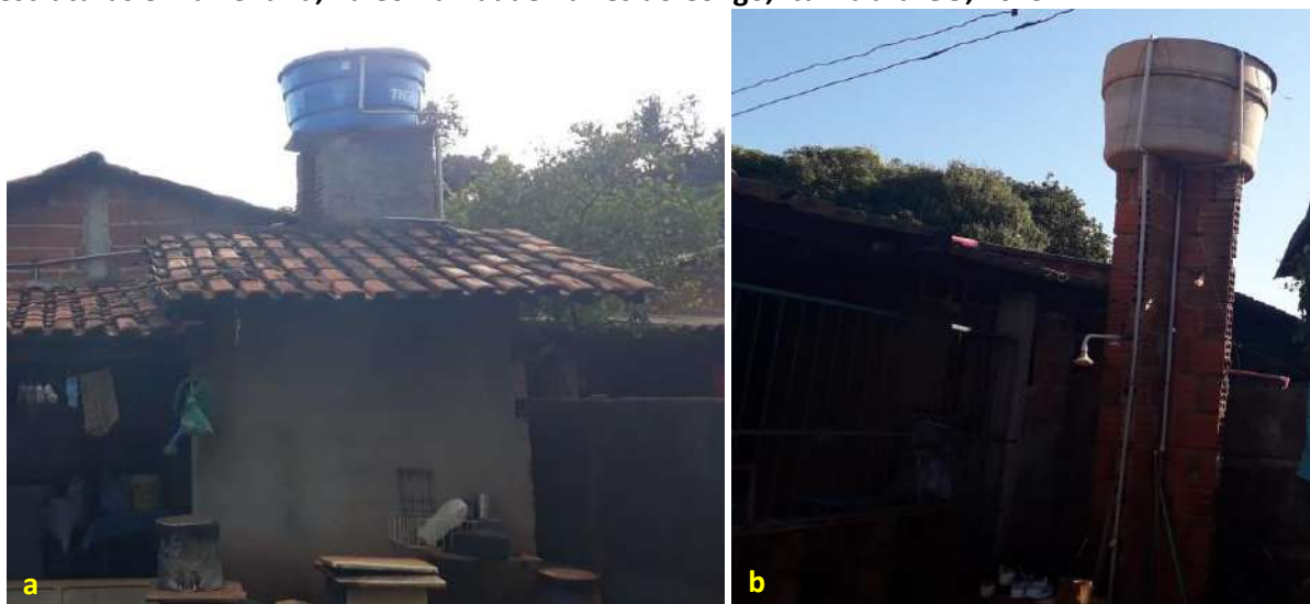
Foto 6.3 – Reservatórios domiciliares de polietileno (a) e de fibrocimento (b), instalados sobre estruturas em alvenaria, na Comunidade Raízes do Congo, Itumbiara-GO, 2019.
