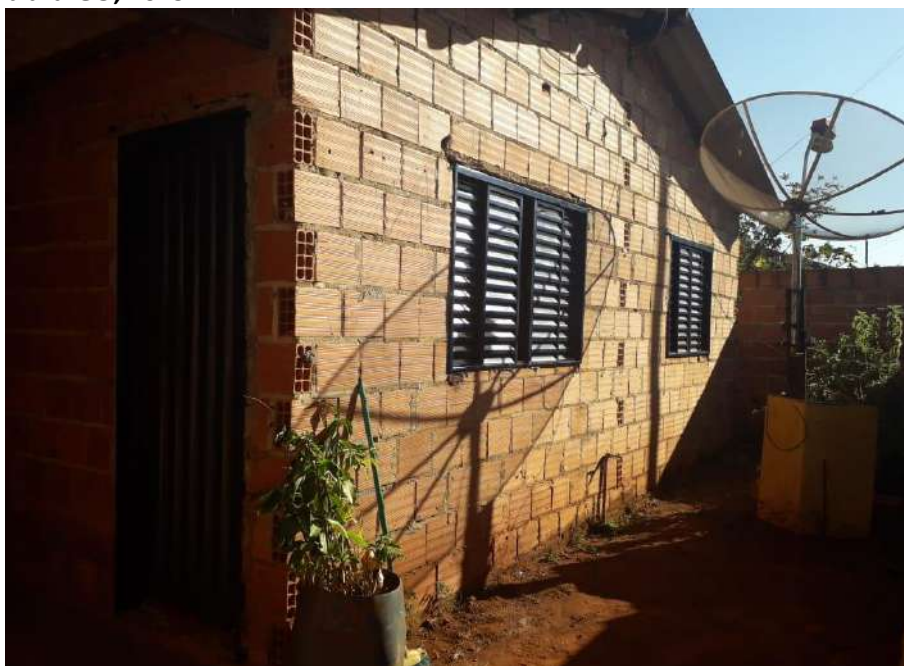
Foto 4.3 – Habitação construída de alvenaria sem reboco, identificada na Comunidade Raízes do Congo, Itumbiara-GO, 2019.
