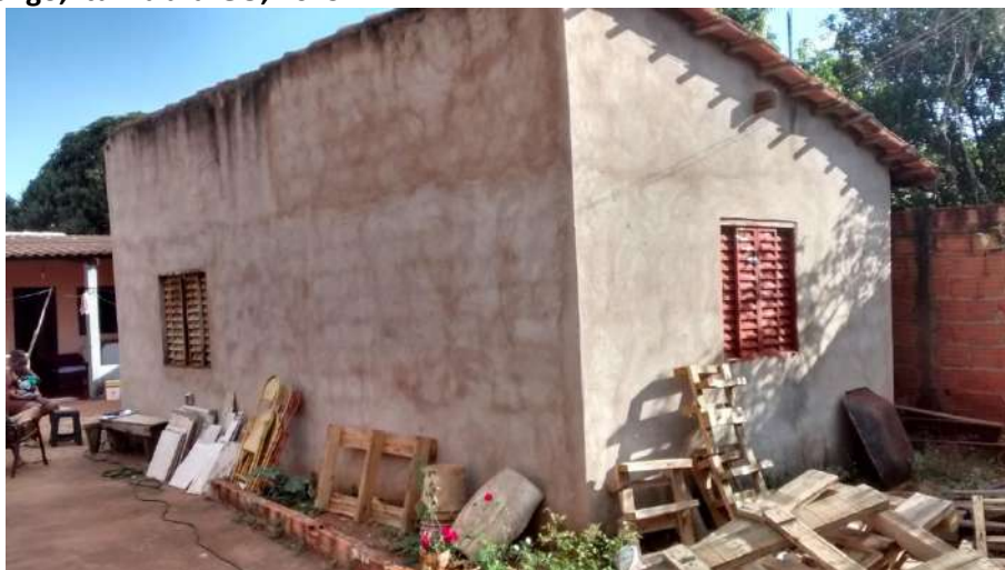
Foto 4.2 – Habitação construída de alvenaria com reboco sem pintura, identificada na Comunidade Raízes do Congo, Itumbiara-GO, 2019.
