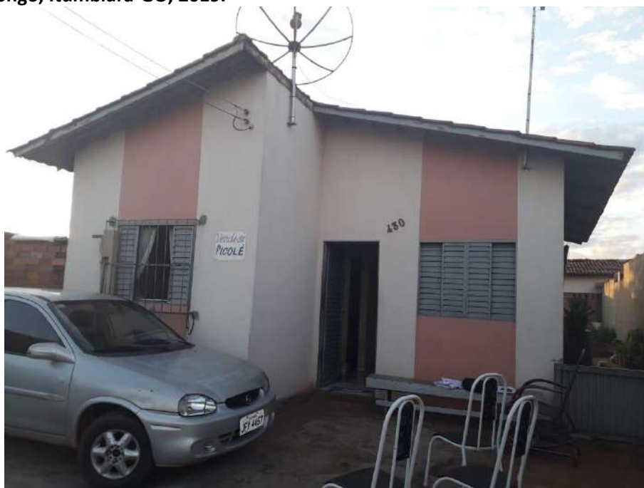
Foto 4.1 – Habitação construída de alvenaria com reboco e pintura, identificada na Comunidade Raízes do Congo, Itumbiara-GO, 2019.
