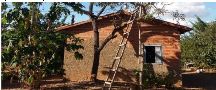
Foto 4.6 – Habitação construída de alvenaria sem reboco, identificada na Comunidade Rafael Machado, Niquelândia-GO, 2019.
