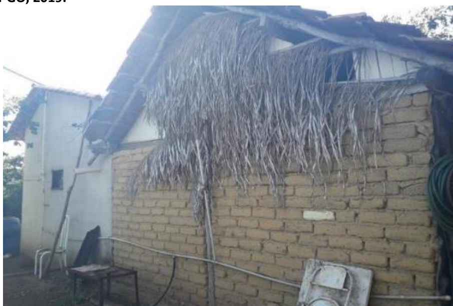
Foto 4.8 – Habitação construída de adobe, identificada na Comunidade Rafael Machado, Niquelândia-GO, 2019.
