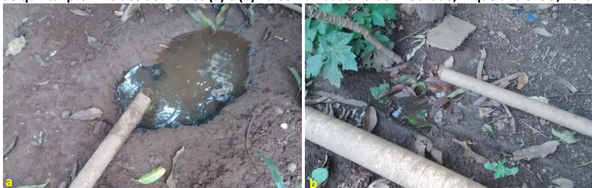
Foto 6.7 – Lançamento e acúmulo de água cinza proveniente da pia da cozinha diretamente no solo do quintal próximo aos domicílios (a) e (b) na Comunidade Rafael Machado, Niquelândia-GO, 2019.
