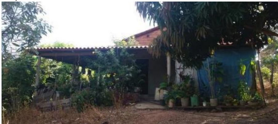
Foto 4.13 – Cobertura do tipo fibrocimento, identificada na Comunidade Rafael Machado, Niquelândia-GO, 2019.
