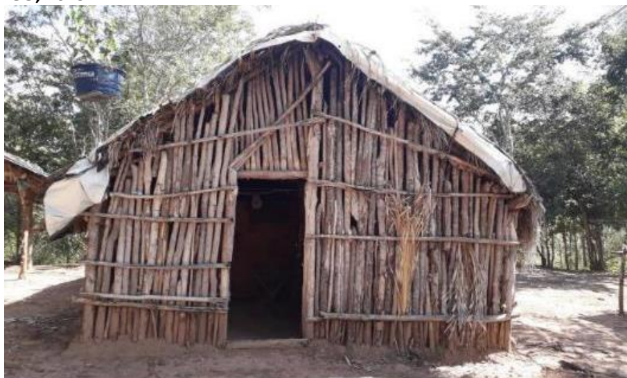
Foto 4.9 – Habitação construída de madeira, identificada na Comunidade Rafael Machado, Niquelândia-GO, 2019.
