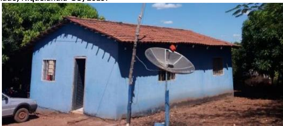
Foto 4.7 – Habitação construída de alvenaria com reboco e pintura, identificada na Comunidade Rafael Machado, Niquelândia-GO, 2019.
