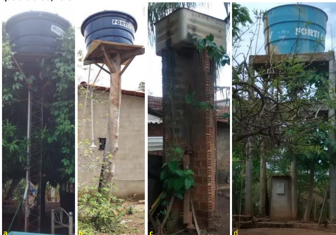
Foto 6.4 – Reservatórios domiciliares de diferentes materiais instalados sobre estruturas diversas: de polietileno sobre estrutura metálica (a) e de madeira (b), de cimento amianto sobre estrutura em alvenaria (c) e de fibra de vidro sobre estrutura de concreto (d), Comunidade Rafael Machado, Niquelândia-GO, 2019.
