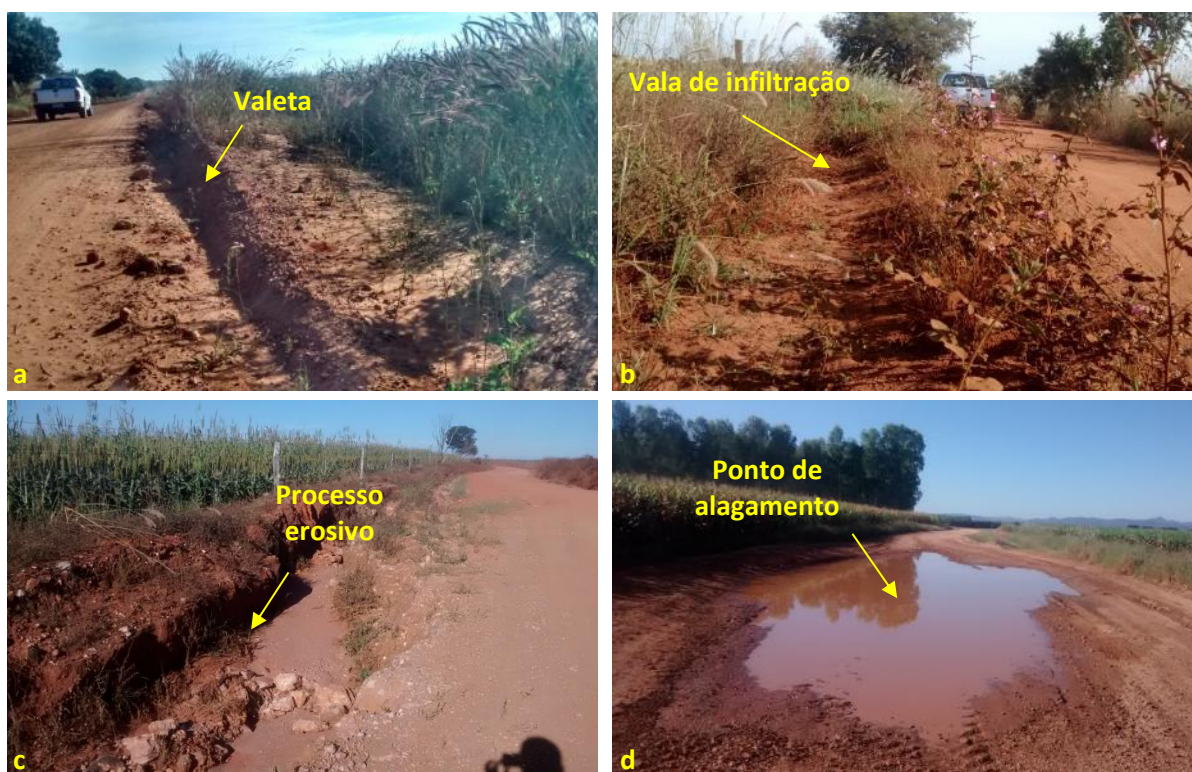
Foto 6.17 – Situação da drenagem pluvial na via de acesso: valeta de infiltração (a), vala de infiltração (b), processo erosivo (c) e ponto de alagamento (d) nas vias de acesso e internas da Comunidade Rafael Machado, Niquelândia-GO, 2019.
