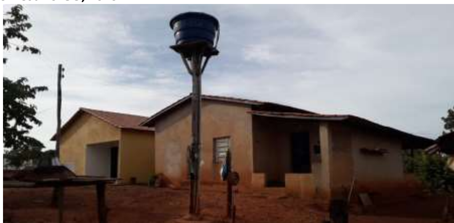
Foto 4.13 – Cobertura de telha de barro, identificada na Comunidade de Quilombo de Pombal, Santa Rita do Novo Destino-GO, 2019.
