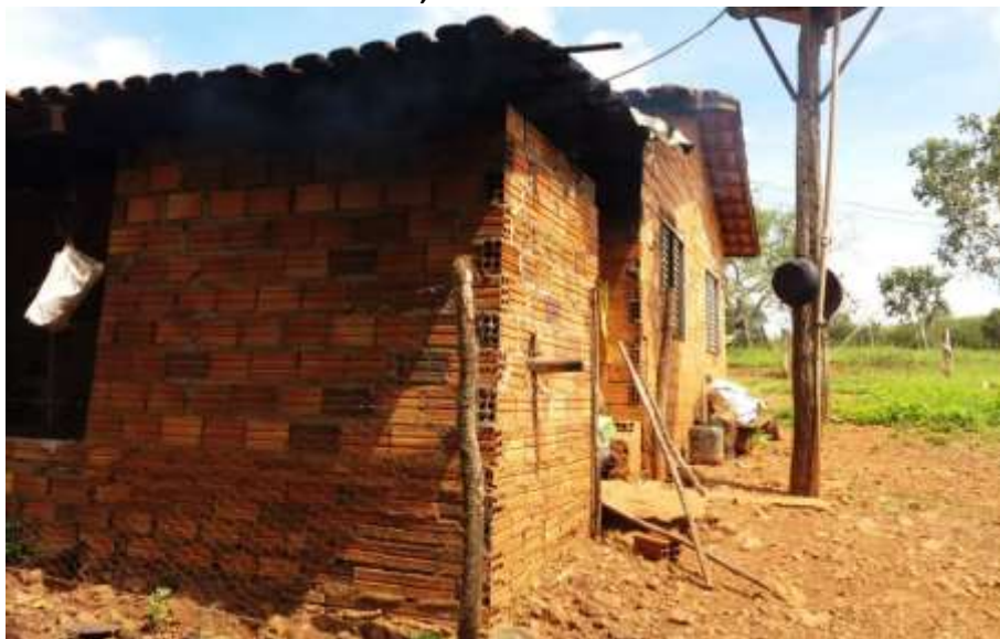
Foto 4.9 – Habitação construída de alvenaria sem reboco, identificada na Comunidade de Quilombo de Pombal, Santa Rita do Novo Destino-GO, 2019.
