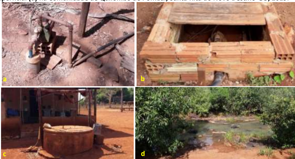
Foto 6.1 – Poço tubular raso (a), poço tubular profundo (b), poço raso escavado (c) e manancial superficial (d) na Comunidade de Quilombo de Pombal, Santa Rita do Novo Destino-GO, 2019.
