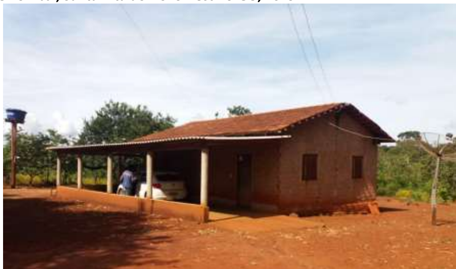
Foto 4.12 – Cobertura de telha de barro e telha fibrocimento, identificada na Comunidade de Quilombo de Pombal, Santa Rita do Novo Destino-GO, 2019.
