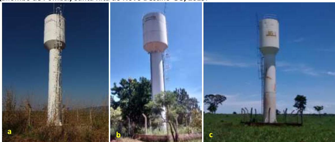
Foto 6.4 – Reservatórios coletivos, R1 (a), R2 (b) e R3 (c), do tipo taça em material metálico e devidamente cercados, que abastecem, respectivamente, o SAA1, SAA2 e SAA3 da Comunidade de Quilombo de Pombal, Santa Rita do Novo Destino-GO, 2019.
