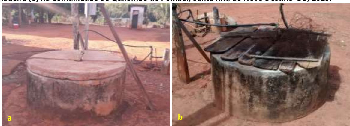
Foto 6.5 – Poços rasos escavados com mureta e tampa de concreto (a) e tampa improvisada de madeira (b) na Comunidade de Quilombo de Pombal, Santa Rita do Novo Destino-GO, 2019.
