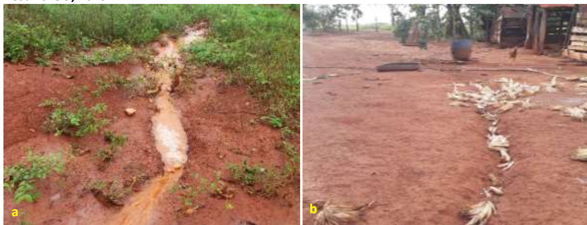
Foto 6.28 – Processos erosivos em lotes da Comunidade de Quilombo de Pombal, Santa Rita do Novo Destino-GO, 2019.
