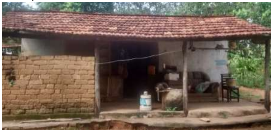
Foto 4.10 – Piso de concreto bruto, identificado na Comunidade de Quilombo de Pombal, Santa Rita do Novo Destino-GO, 2019.
