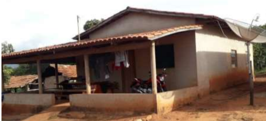
Foto 4.8 – Habitação construída de alvenaria com reboco, identificada na Comunidade de Quilombo de Pombal, Santa Rita do Novo Destino-GO, 2019.
