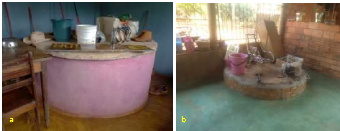
Foto 6.6 – Poços rasos escavados no intradomicílio (a) e (b) na Comunidade de Quilombo de Pombal, Santa Rita do Novo Destino-GO, 2019.
