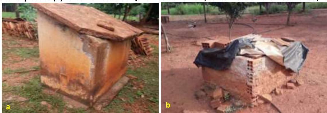
Foto 6.7 – Poços tubulares rasos no interior de abrigos em alvenaria, e laje em concreto (a) e com material plástico (b) na Comunidade de Quilombo de Pombal, Santa Rita do Novo Destino-GO, 2019.
