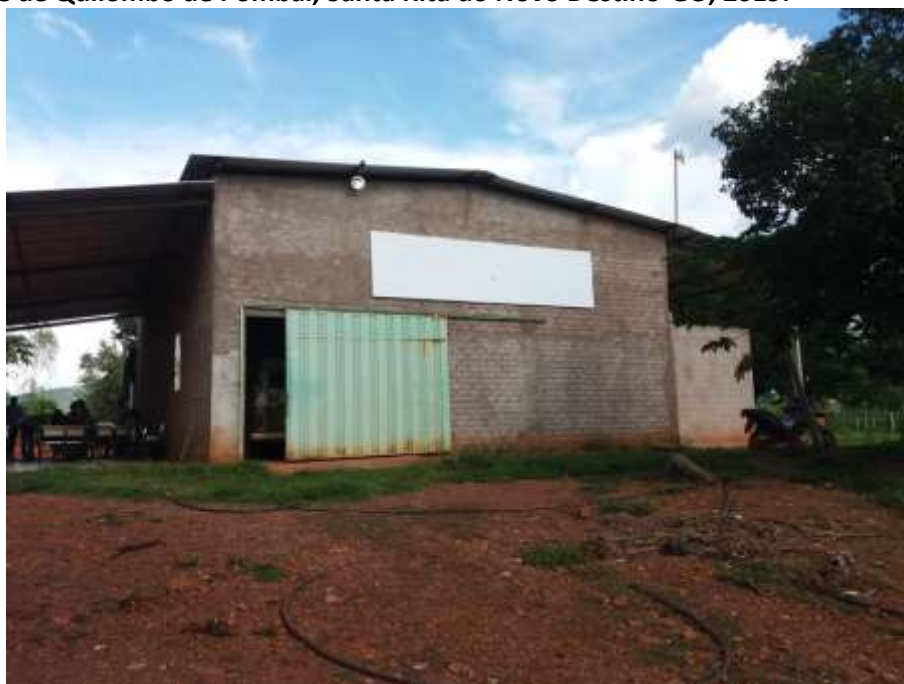
Foto 4.2 – Sede da Associação dos Remanescentes do Quilombo de Pombal, identificada na Comunidade de Quilombo de Pombal, Santa Rita do Novo Destino-GO, 2019.
