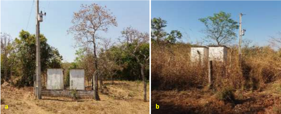
Foto 6.2 – Áreas das captações do SSA 1 e SSA 2 devidamente cercadas e com fonte de alimentação de energia na Comunidade de Quilombo de Pombal, Santa Rita do Novo Destino-GO, 2019.
