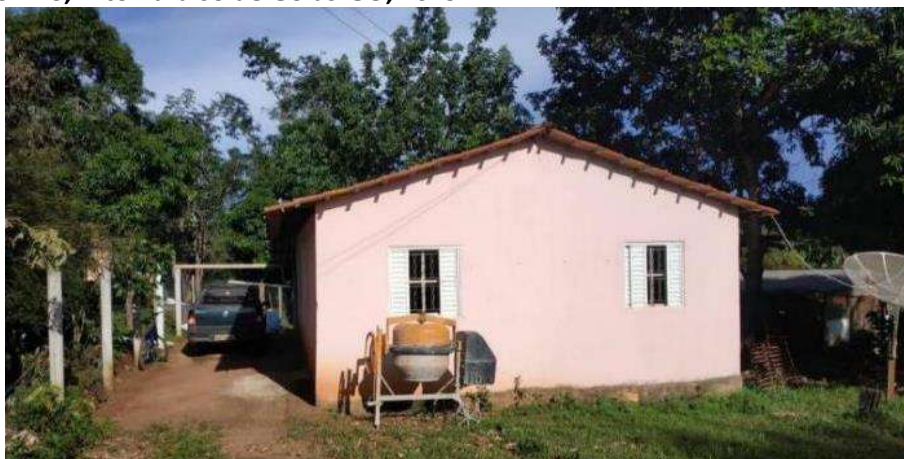
Foto 4.14 – Habitação construída de alvenaria com reboco e pintura, identificada na Comunidade Povoadado Moinho, Alto Paraíso de Goiás-GO, 2019.
