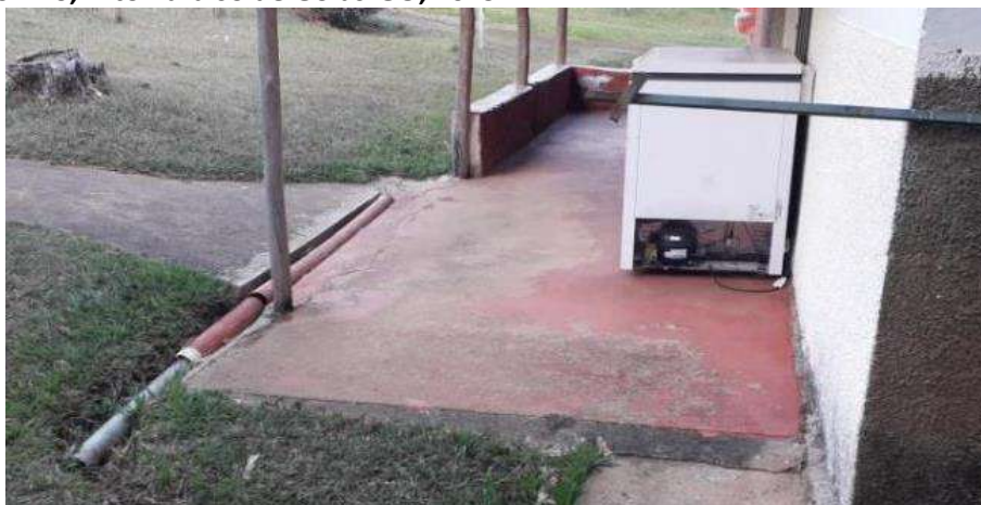
Foto 4.16 – Piso de residência constituído de cimento queimado, identificado na Comunidade Povoadado Moinho, Alto Paraíso de Goiás-GO, 2019.
