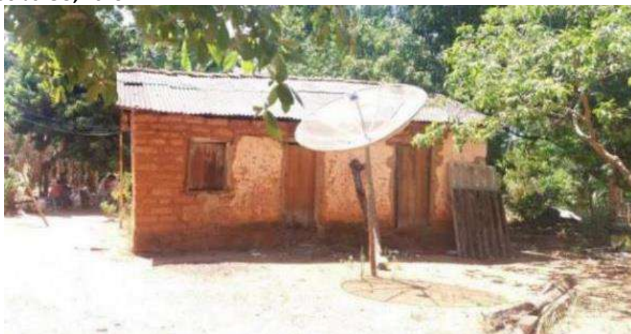
Foto 4.15 – Habitação construída de adobe, identificada na Comunidade Povoador Moinho, Alto Paraíso de Goiás-GO, 2019.
