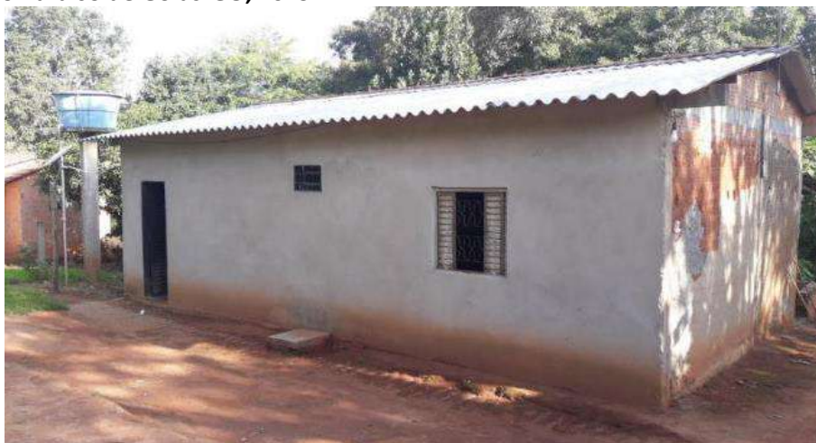
Foto 4.12 – Habitação construída de alvenaria com reboco, identificada na Comunidade Povoadado Moinho, Alto Paraíso de Goiás-GO, 2019.
