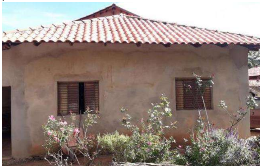
Foto 4.19 – Cobertura de telha de barro, identificada na Comunidade Povoado Moinho, Alto Paraíso de Goiás-GO, 2019.
