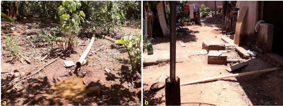
Foto 6.11 – Lançamento e acúmulo de água cinza proveniente da pia da cozinha diretamente no solo do quintal próximo aos domicílios (a), trecho de tubulação de uma sequência de caixa de gordura, fossa séptica e sumidouro (b) na Comunidade Povoado Moinho, Alto Paraíso-GO, 2019.
