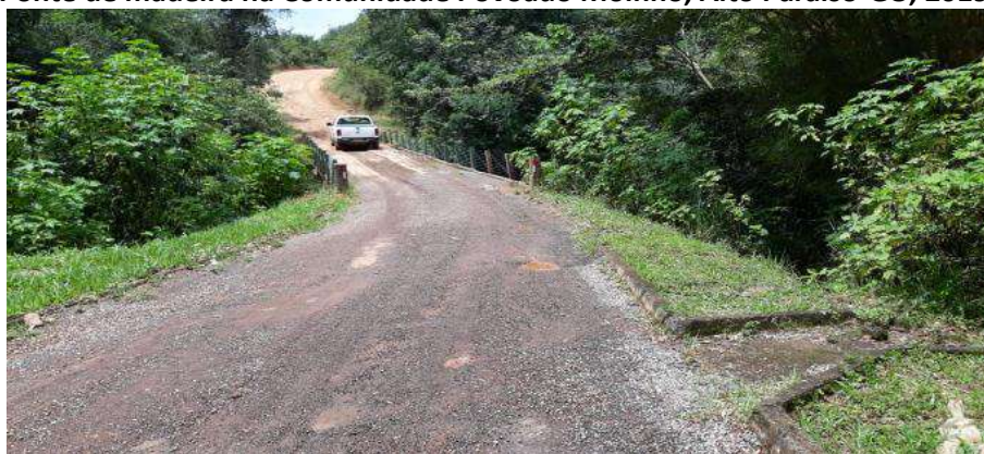
Foto 6.20 – Ponte de madeira na Comunidade Povoado Moinho, Alto Paraíso-GO, 2019.
