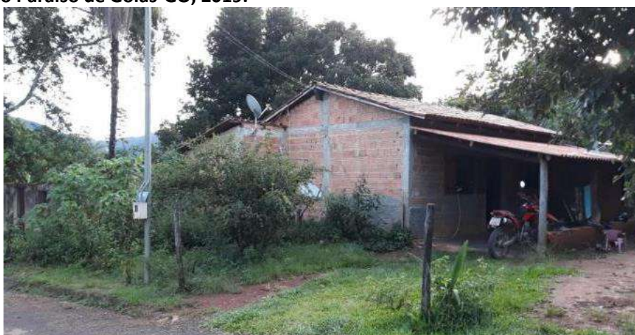
Foto 4.13 – Habitação construída de alvenaria sem reboco, identificada na Comunidade Povoadado Moinho, Alto Paraíso de Goiás-GO, 2019.
