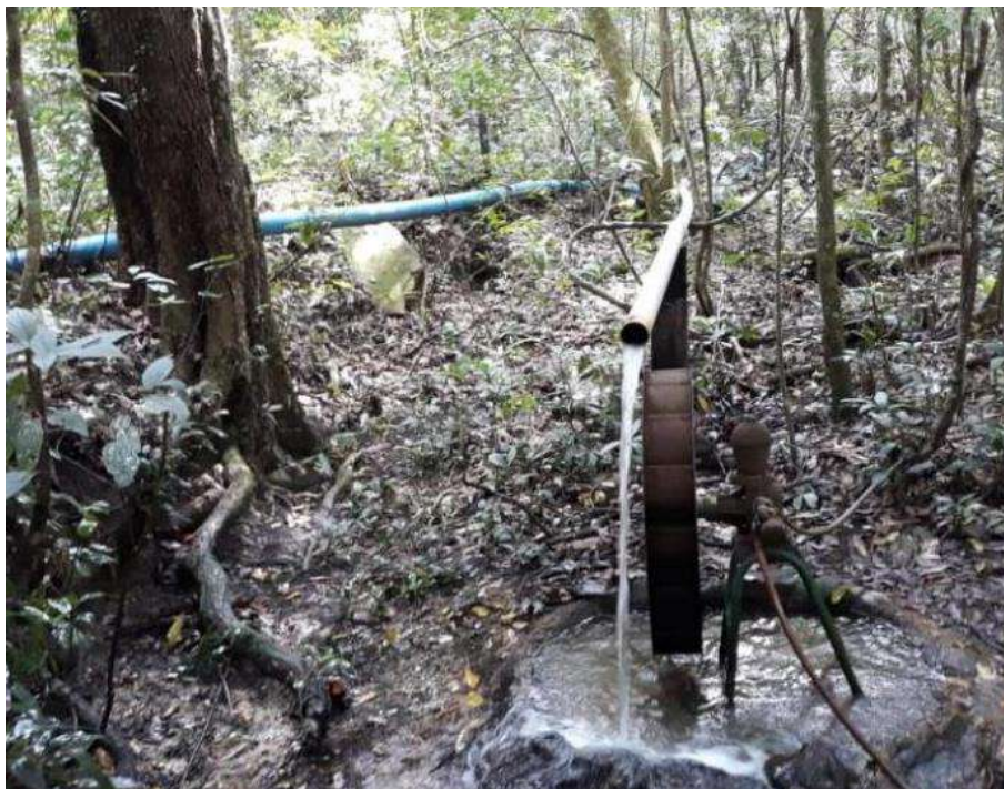
Foto 6.5 – Roda d'água e barragem utilizadas pela Comunidade Povoado Moinho, Alto Paraíso de Goiás-GO, 2019.
