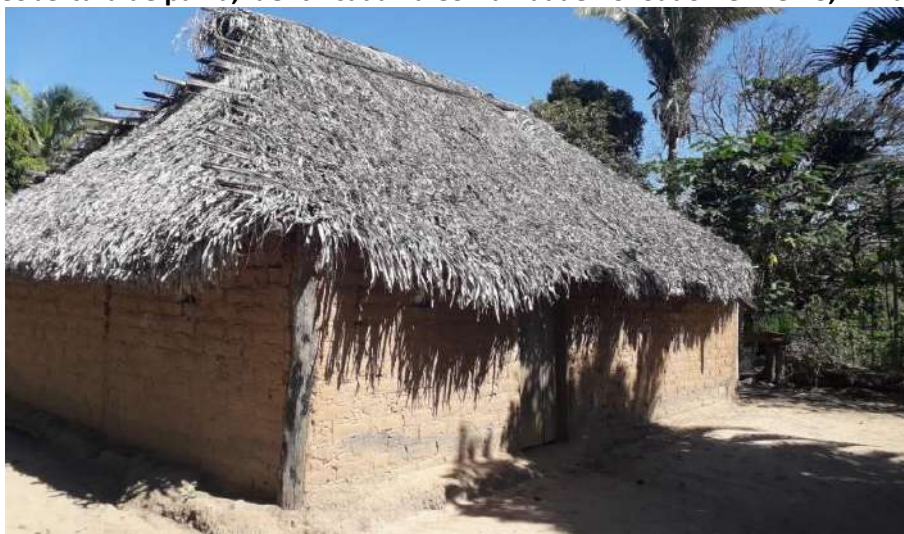
Foto 4.18 – Cobertura de palha, identificada na Comunidade Povoado Vermelho, Minaçu-GO, 2019.
