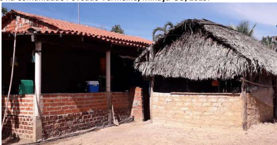
Foto 4.11 – Habitação construída de alvenaria sem reboco e habitação construída de adobe, identificadas na Comunidade Povoado Vermelho, Minaçu-GO, 2019.
