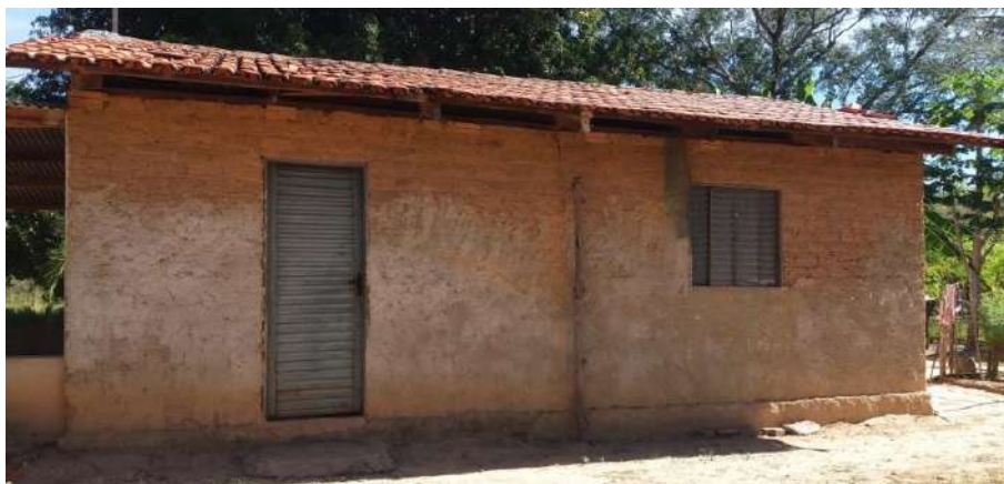
Foto 4.19 – Cobertura de telha de barro, identificada na Comunidade Povoado Vermelho, Minaçu-GO, 2019.
