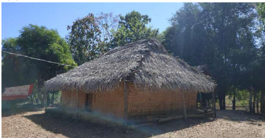
Foto 4.13 – Habitação construída de pau a pique, identificada na Comunidade Povoador Vermelho, Minaçu-GO, 2019.
