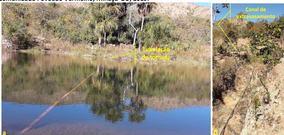
Foto 6.2 – Represa onde é realizada a captação do SAA (a) e com canal de extravasamento (b), na Comunidade Povoadado Vermelho, Minaçu-GO, 2019.
