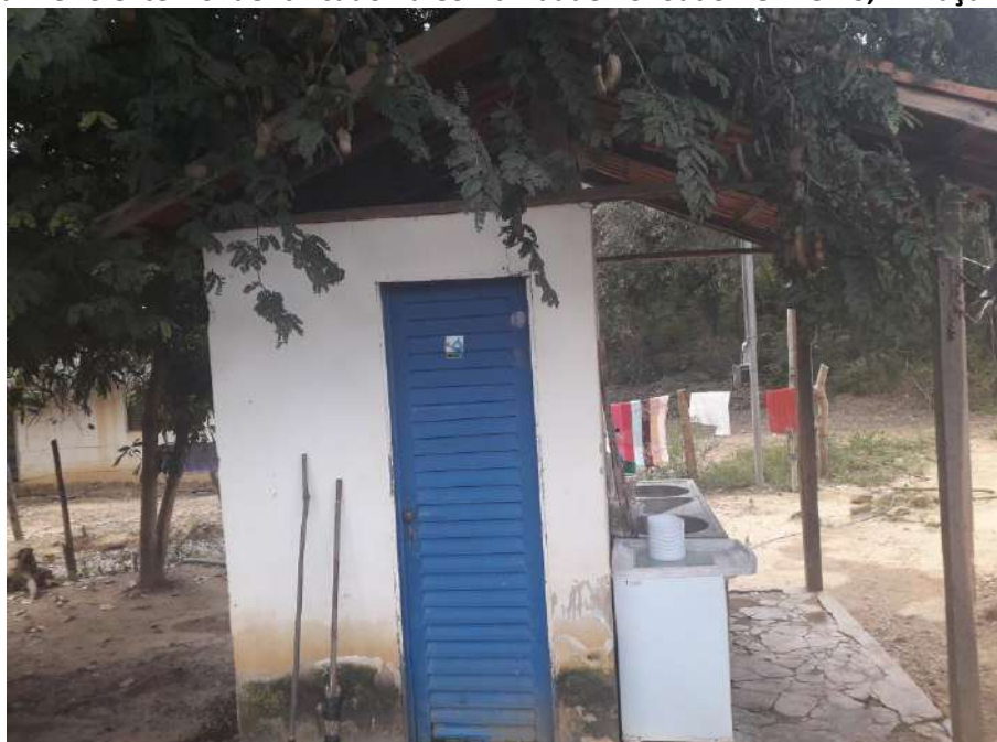
Foto 4.8 – Banheiro externo identificado na Comunidade Povoado Vermelho, Minaçu-GO, 2019.
