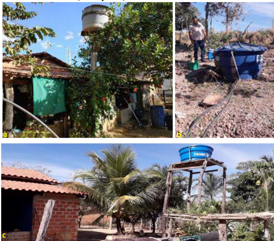
Foto 6.6 – Reservatório em fibrocimento com tampa amarrada, instalado sobre estrutura de madeira (a), em polietileno apoiado ao solo (b), e outro instalado sobre estrutura de madeira (c), na Comunidade Povoado Vermelho, Minaçu-GO, 2019.
