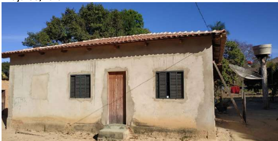
Foto 4.10 – Habitação construída de alvenaria com reboco, identificada na Comunidade Povoado Vermelho, Minaçu-GO, 2019.
