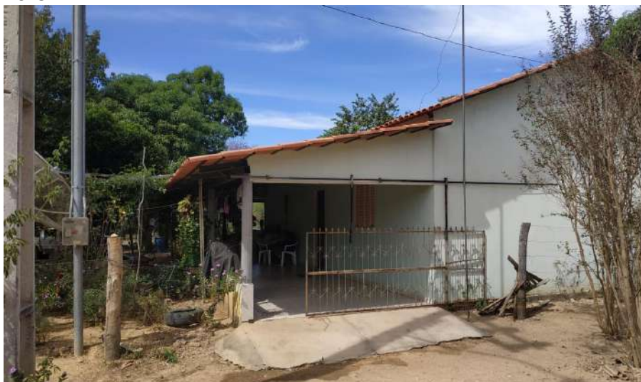
Foto 4.17 – Piso de residência constituído cerâmica, identificado na Comunidade Povoadado Vermelho, Minaçu-GO, 2019.
