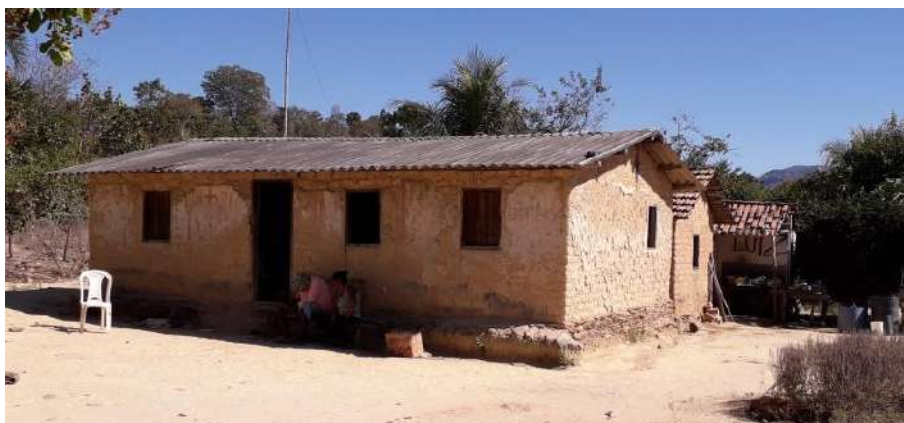
Foto 4.20 – Cobertura de fibrocimento, identificada na Comunidade Povoado Vermelho, Minaçu-GO, 2019.
