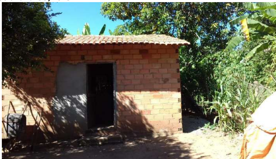
Foto 4.12 – Habitação construída de alvenaria sem reboco, identificada na Comunidade Povoado Veríssimo, Goiândia-GO, 2018.
