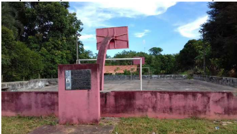
Foto 4.7 – Quadra poliesportiva, identificada na Comunidade Povoado Veríssimo, Goiandira-GO, 2018.
