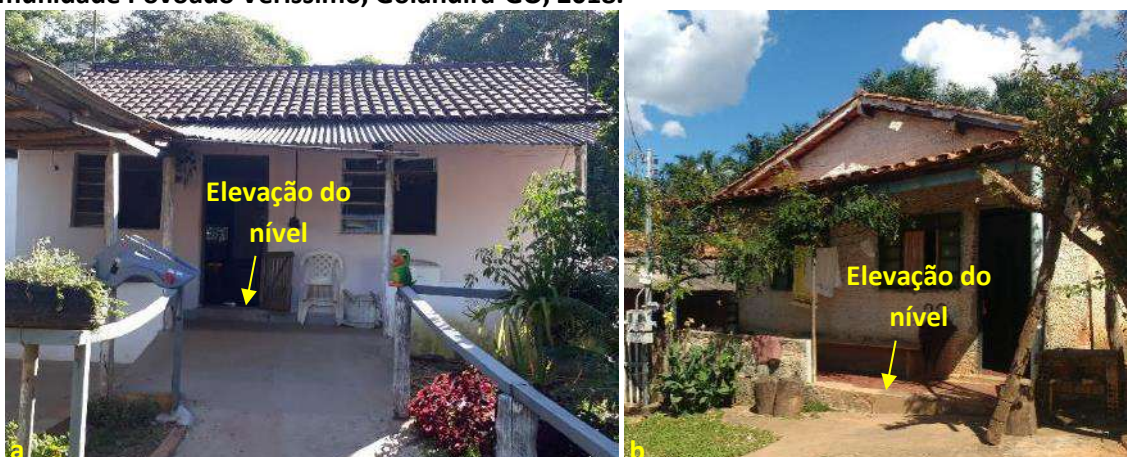
Foto 6.21 – Dispositivos de prevenção dos danos provocados pelas águas em residências da Comunidade Povoado Veríssimo, Goiandira-GO, 2018.
