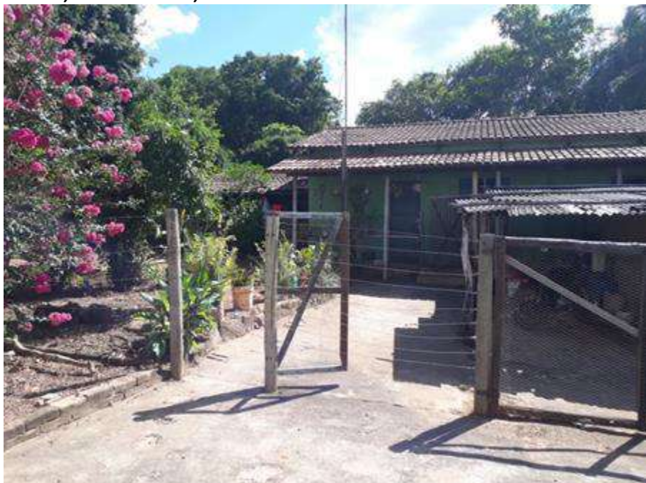
Foto 4.11 – Habitação construída de alvenaria com reboco e pintura, identificada na Comunidade Povoador Veríssimo, Goiandira-GO, 2018.
