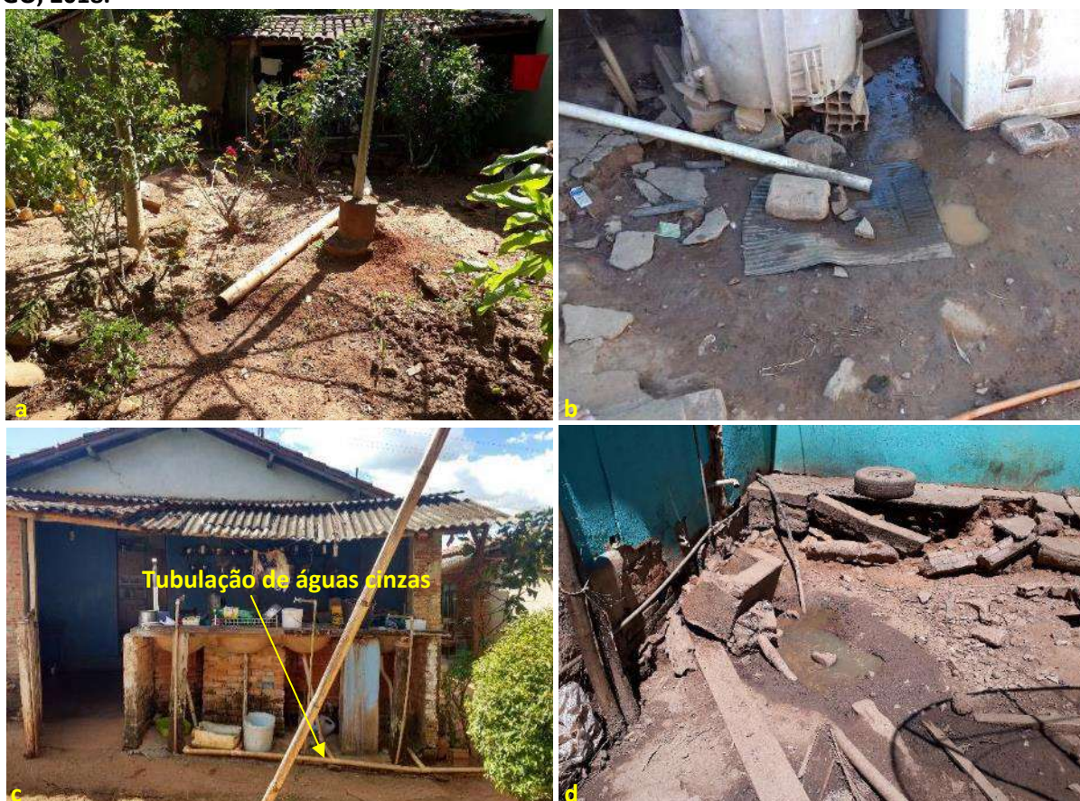
Foto 6.5 – Lançamento e acúmulo de água cinza proveniente da pia da cozinha diretamente no solo do quintal próximo aos domicílios (a), (b), (c) e (d), na Comunidade Povoado Veríssimo, Goiandira-GO, 2018.
