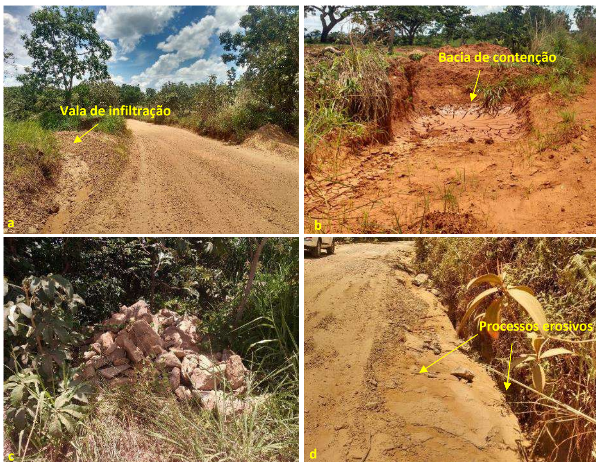
Foto 6.17 – Situação da drenagem pluvial na via de acesso: vala de infiltração (a), bacia de contenção (b), resíduo de construção (c) e processos erosivos (d), na Comunidade Povoado Veríssimo, Goiandira-GO, 2018.
