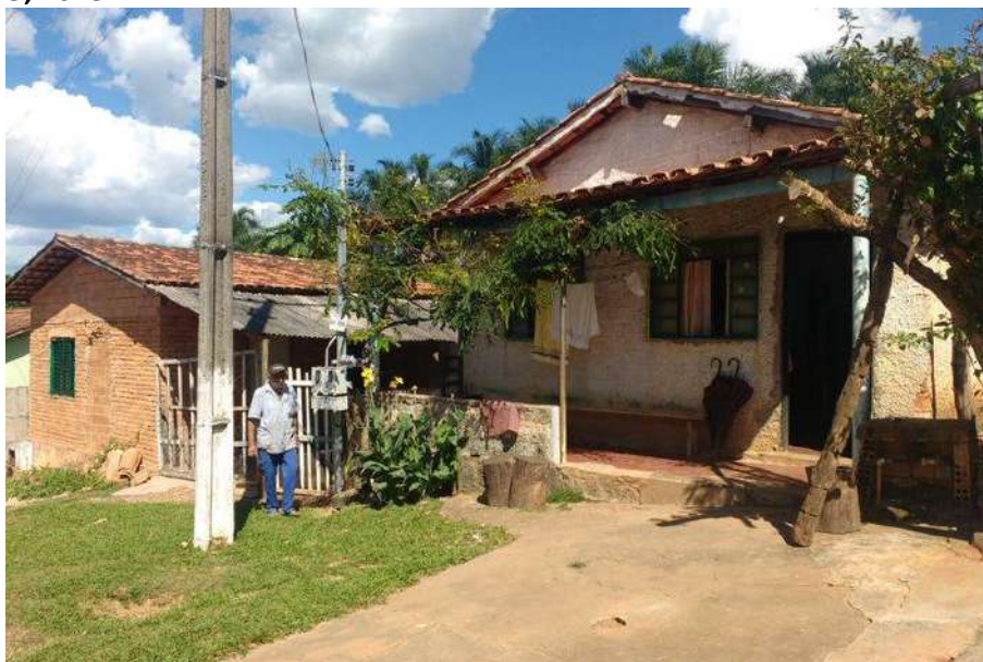
Foto 4.13 – Piso queimado, identificado nas habitações da Comunidade Povoado Veríssimo, Goiandira-GO, 2018.
