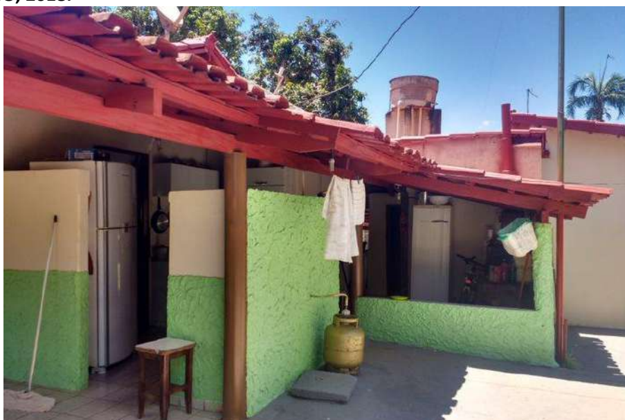
Foto 4.14 – Piso em cerâmica, identificado nas habitações da Comunidade Povoado Veríssimo, Goiandira-GO, 2018.
