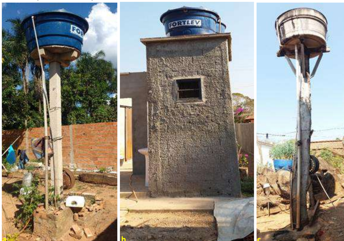
Foto 6.2 – Reservatórios domiciliares instalados sobre diferentes estruturas, sendo um reservatório de polietileno instalado sobre estrutura de concreto (a) e estrutura de alvenaria (b) e um reservatório de fibrocimento instalado sobre estrutura de madeira (c), na Comunidade Povoadado Veríssimo, Goiandira-GO, 2018.
