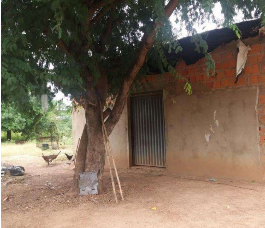
Foto 4.5 – Habitação construída de alvenaria com reboco sem pintura, identificada na Comunidade de Povoado Levantado, Iaciara-GO, 2019.
