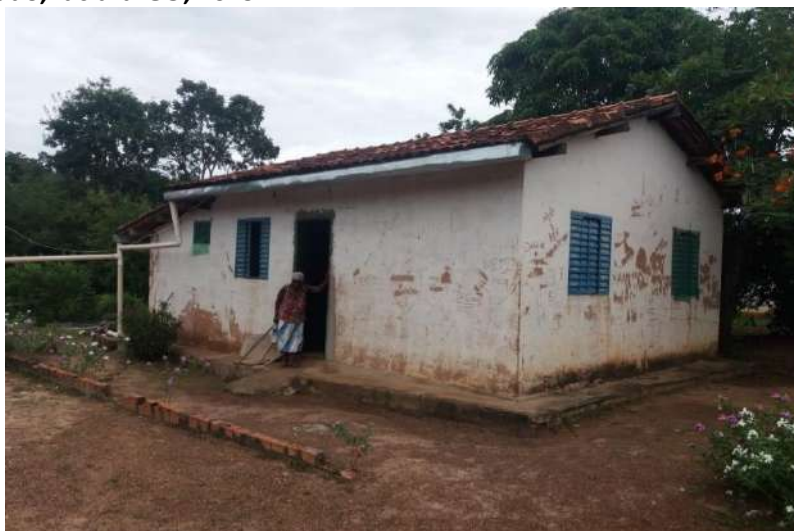
Foto 4.7 – Habitação construída de alvenaria com reboco e pintura, identificada na Comunidade de Povoador Levantado, Iaciara-GO, 2019.
