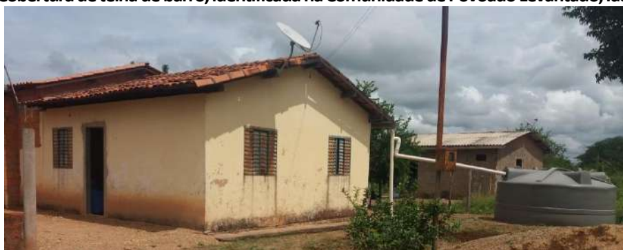
Foto 4.10 – Cobertura de telha de barro, identificada na Comunidade de Povoado Levantado, Iaciara-GO, 2019.
