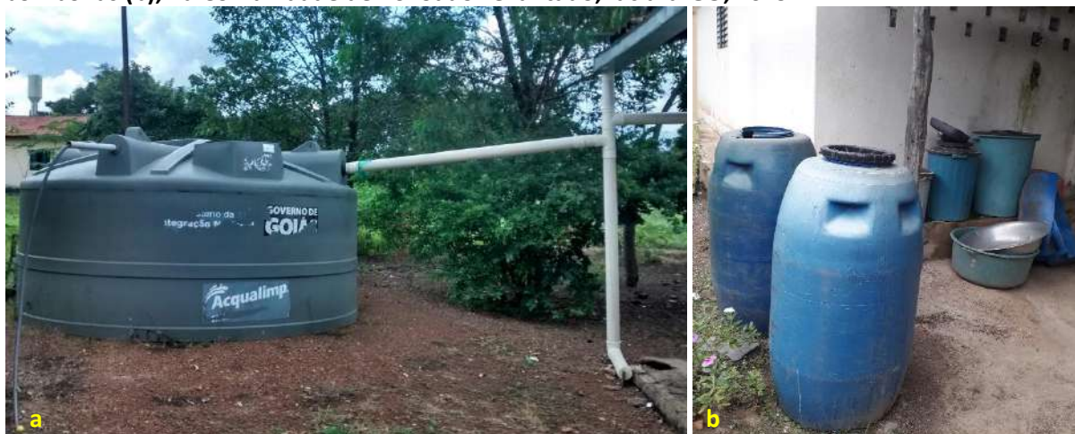
Foto 6.4 – Sistema de captação da água de chuva e armazenamento realizado em cisterna (a) ou em bombonas (b), na Comunidade de Povoado Levantado, Iaciara-GO, 2019.
