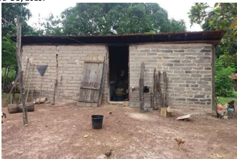
Foto 4.8 – Extensão habitacional construída de adobe, identificada na Comunidade de Povoador Levantado, Iaciara-GO, 2019.
