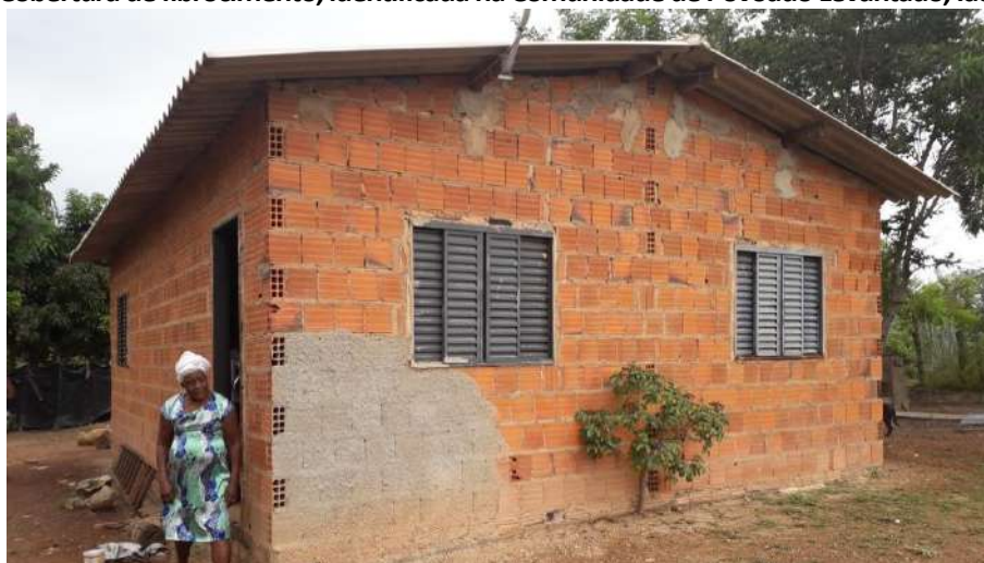
Foto 4.11 – Cobertura de fibrocimento, identificada na Comunidade de Povoado Levantado, Iaciara-GO, 2019.
