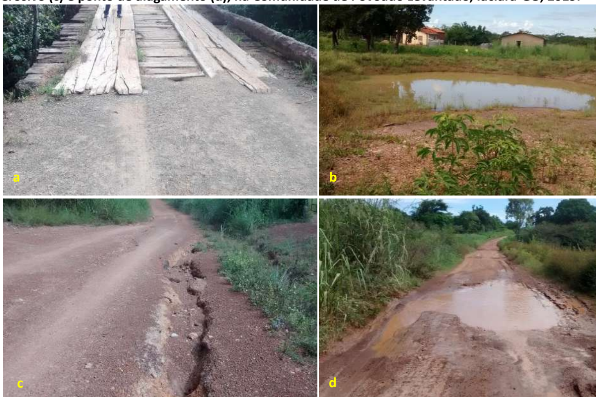
Foto 6.14 – Ponte na via de acesso sobre ribeirão do Fogo (a), bacia de contenção (b), processo erosivo (c) e ponto de alagamento (d), na Comunidade de Povoado Levantado, Iaciara-GO, 2019.
