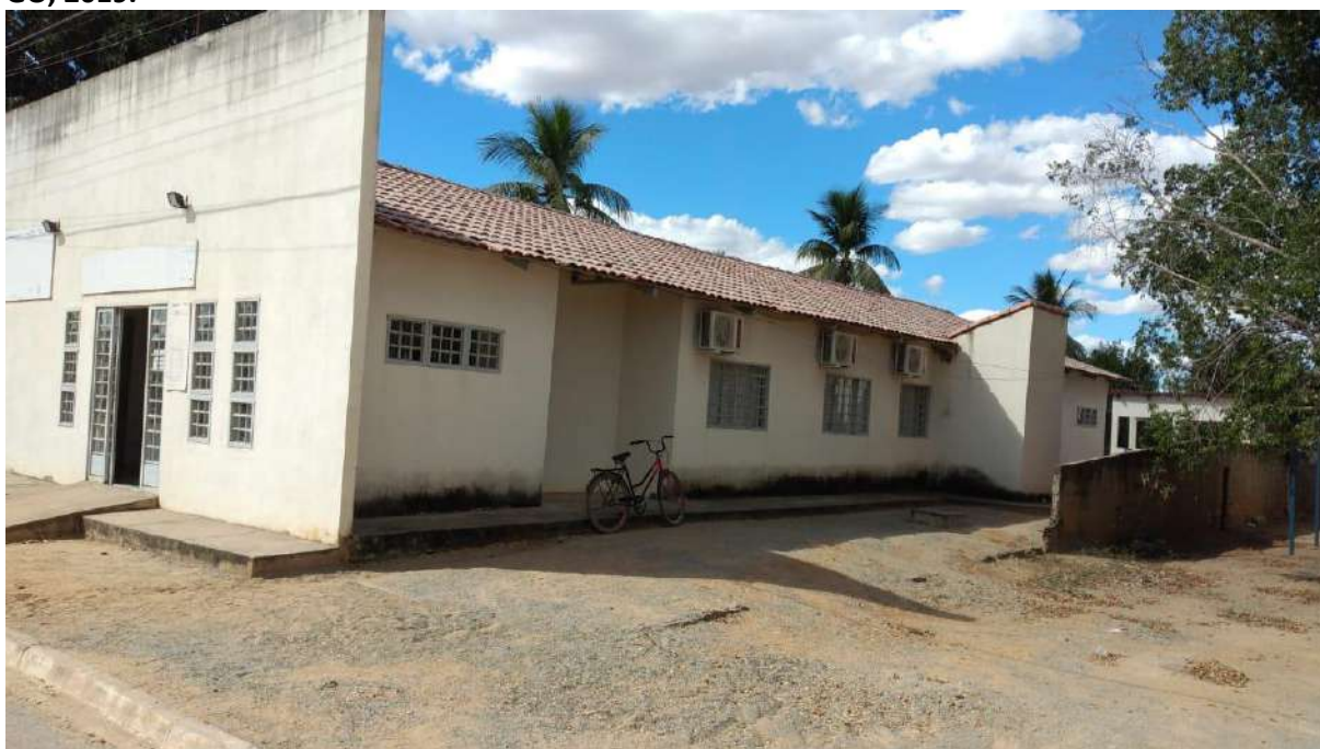
Foto 5.1 – Vista externa da UBSF-III, referência para a Comunidade de Povoado Levantado, Iaciara-GO, 2019.
