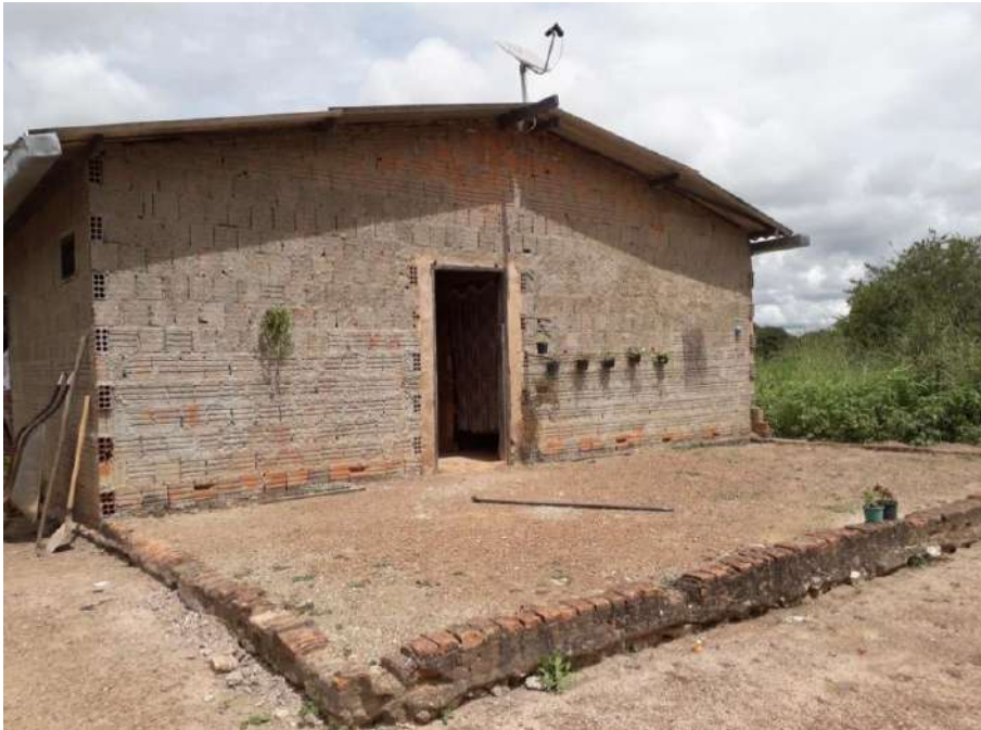
Foto 4.6 – Habitação construída de alvenaria sem reboco, identificada na Comunidade de Povoado Levantado, Iaciara-GO, 2019.
