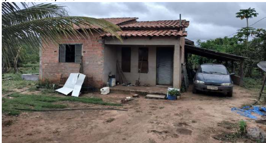
Foto 4.7 – Habitação construída de alvenaria sem reboco e com reboco, identificada na Comunidade Pouso Alegre, Mineiros-GO, 2019.
