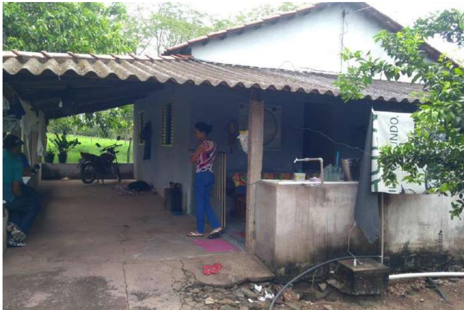
Foto 4.10 – Cobertura de telha fibrocimento, identificada na Comunidade Pouso Alegre, Mineiros-GO, 2019.
