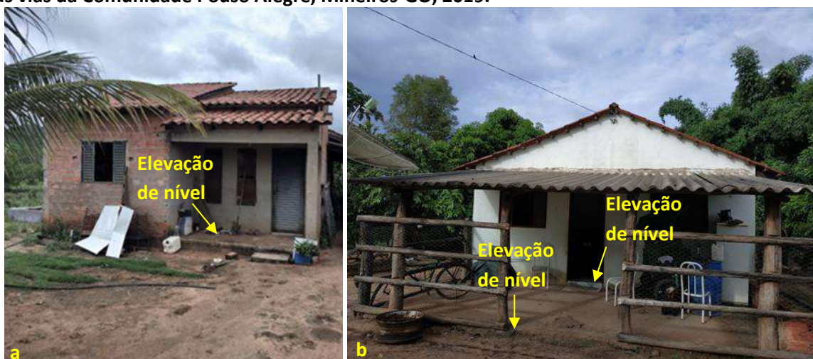
Foto 6.17 – Dispositivos de prevenção dos danos provocados pelas águas (a) nas residências e (b) nas vias da Comunidade Pouso Alegre, Mineiros-GO, 2019.
