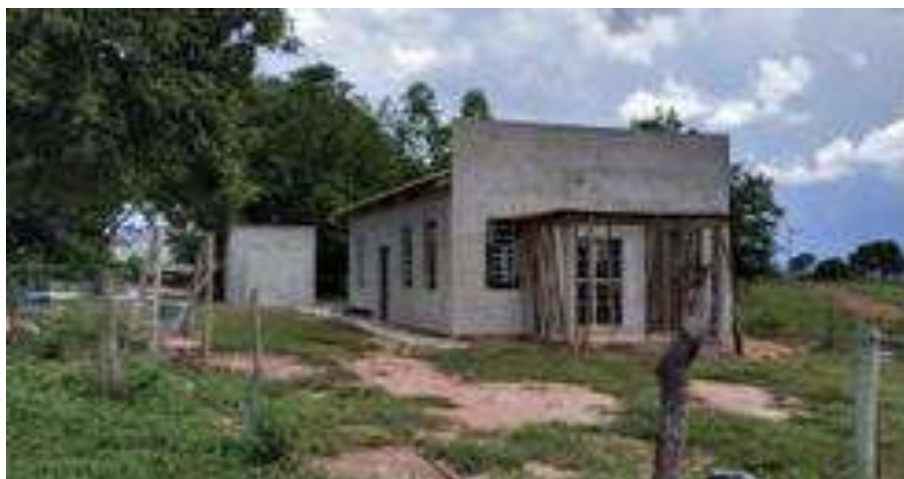
Foto 4.1 – Igreja evangélica em construção, identificada na comunidade Pouso Alegre, Mineiros-GO, 2019.
