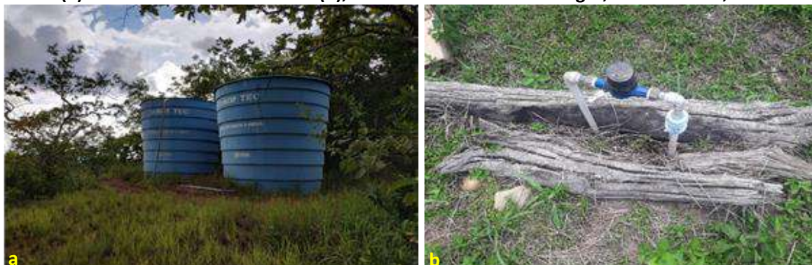
Foto 6.2 – Componentes do SAA, sistema de reservação R1 constituído de dois reservatórios de 20 m 3 cada (a) e macro medidor de vazão (b), na Comunidade Pouso Alegre, Mineiros-GO, 2019.
