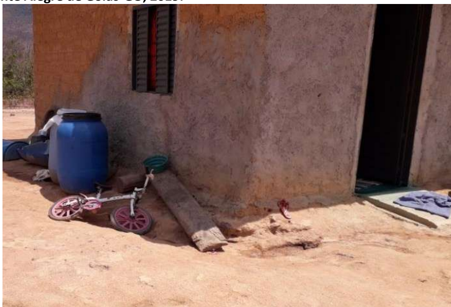
Foto 4.11 – Piso de residência constituído de cimento queimado, identificado na Comunidade de Pelotas, Monte Alegre de Goiás-GO, 2019.
