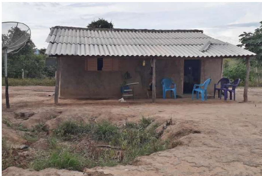
Foto 4.16 – Cobertura de fibrocimento, identificada na Comunidade de Pelotas, Monte Alegre de Goiás-GO, 2019.
