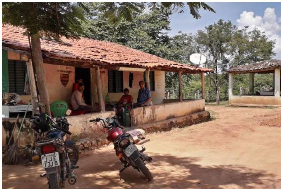
Foto 4.15 – Cobertura de telha de barro, identificada na Comunidade de Pelotas, Monte Alegre de Goiás-GO, 2019.
