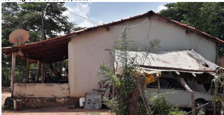
Foto 4.8 – Habitação construída de alvenaria com reboco e pintura, identificada na Comunidade de Pelotas, Monte Alegre de Goiás-GO, 2019.
