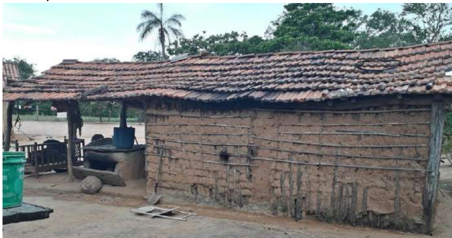
Foto 4.9 – Habitação construída de pau a pique, identificada na Comunidade de Pelotas, Monte Alegre de Goiás-GO, 2019.
