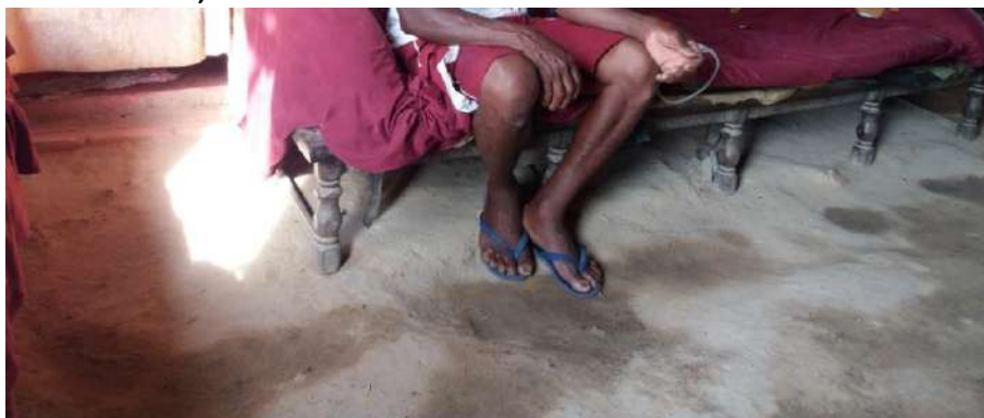
Foto 4.13 – Piso de residência constituído chão batido, identificado na Comunidade de Pelotas, Monte Alegre de Goiás-GO, 2019.
