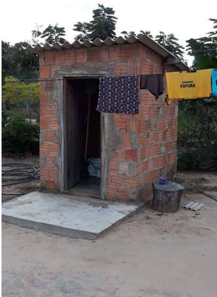
Foto 4.5 – Banheiro externo identificado na Comunidade de Pelotas, Monte Alegre de Goiás-GO, 2019.
