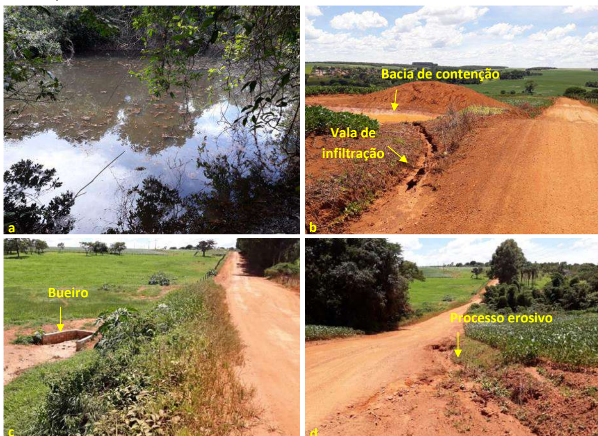
Foto 6.13 – Situação da drenagem pluvial: área de brejo (a), vala de infiltração e bacia de contenção (b), bueiro (c) e processo erosivo (d) na via de acesso à Comunidade Olhos D'Água, Gameleira de Goiás-GO, 2018.
