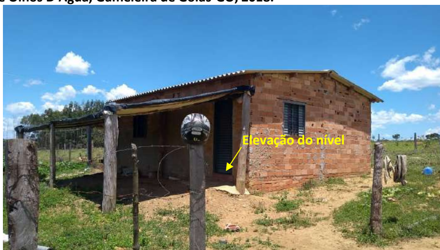
Foto 6.15 – Dispositivo de prevenção dos danos provocados pelas águas em residência da Comunidade Olhos D'Água, Gameleira de Goiás-GO, 2018.
