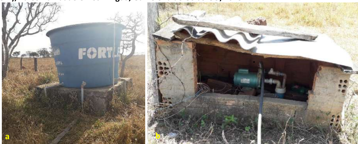
Foto 6.1 – Poço tubular raso (a) e reservatório (b) constituinte do Sistema Alternativo Individual (SAI), na Comunidade Olhos D'Água, Gameleira de Goiás-GO, 2018.
