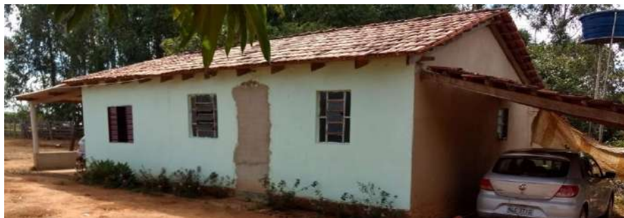
Foto 4.6 – Cobertura de telha de barro, identificada na Comunidade Olhos D'Água, Gameleira de Goiás-GO, 2018.
