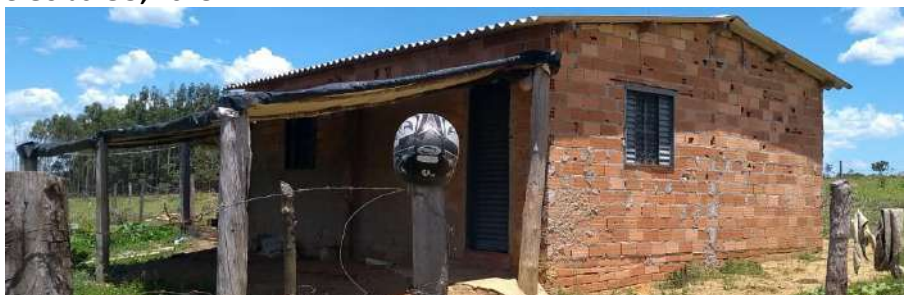
Foto 4.2 – Habitação construída de alvenaria sem reboco, identificada na Comunidade Olhos D’Água, Gameleira de Goiás-GO, 2018.
