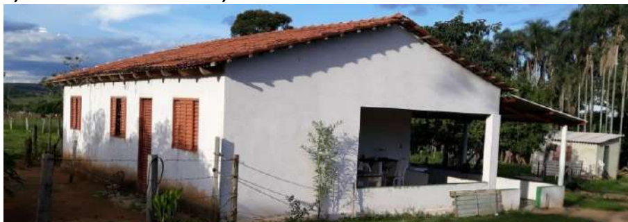
Foto 4.3 – Habitação construída de alvenaria com reboco e pintura, identificada na Comunidade Olhos D’Água, Gameleira de Goiás-GO, 2018.
