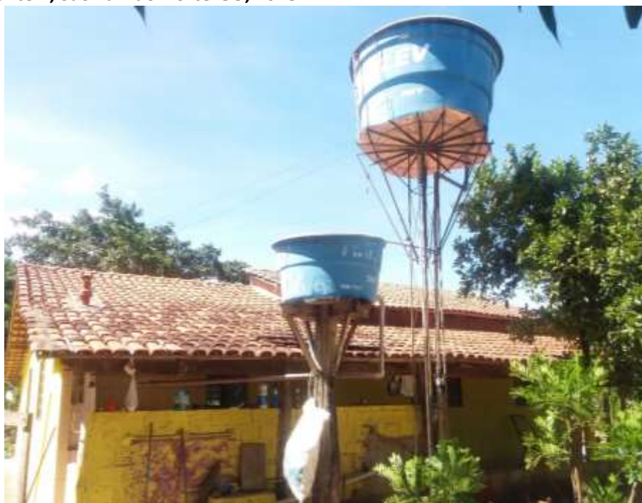
Foto 6.4 – Domicílio com dois reservatórios em fibra de vidro de diferentes volumes, na Comunidade Novo Horizonte II, São Luiz do Norte-GO, 2018.
