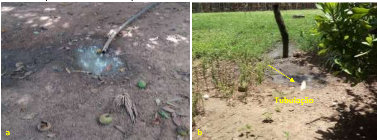
Foto 6.7 – Lançamento e acúmulo de água cinza proveniente da pia da cozinha e/ou do tanque de lavar roupas, diretamente no solo do quintal próximo aos domicílios (a) e (b), na Comunidade Novo Horizonte II, São Luiz do Norte-GO, 2018.
