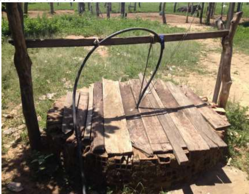
Foto 6.1 – Poço raso escavado usado para captação de água para ingestão, na Comunidade Novo Horizonte II, São Luiz do Norte-GO, 2018.
