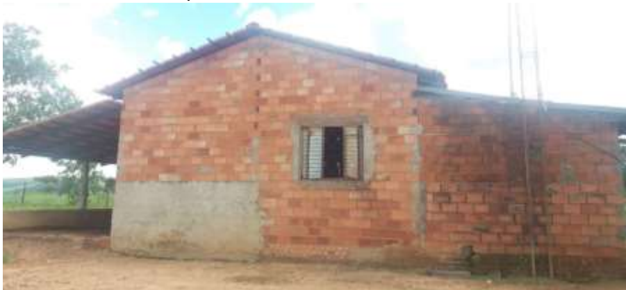
Foto 4.9 – Habitação construída de alvenaria sem reboco, identificada na Comunidade Novo Horizonte II, São Luiz do Norte-GO, 2018.
