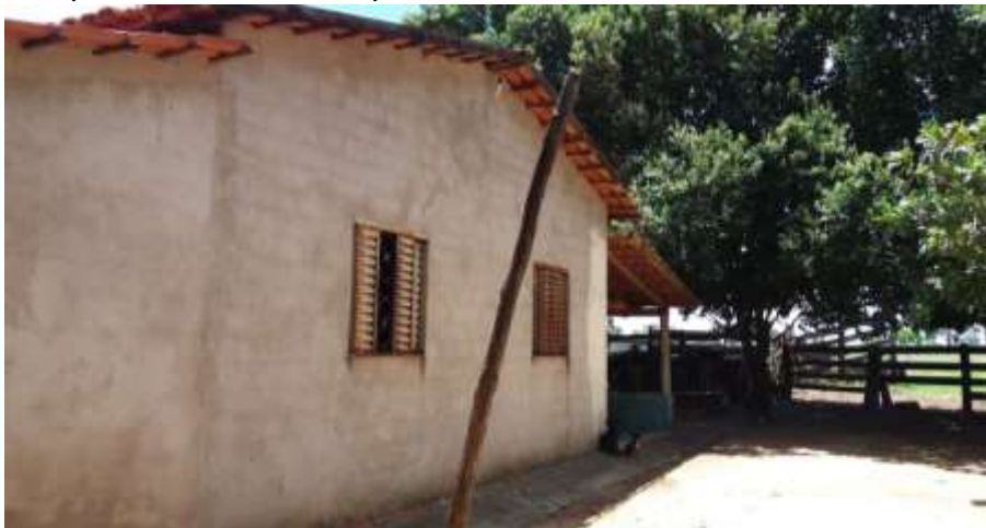
Foto 4.8 – Habitação construída de alvenaria com reboco sem pintura, identificada na Comunidade Novo Horizonte II, São Luiz do Norte-GO, 2018.
