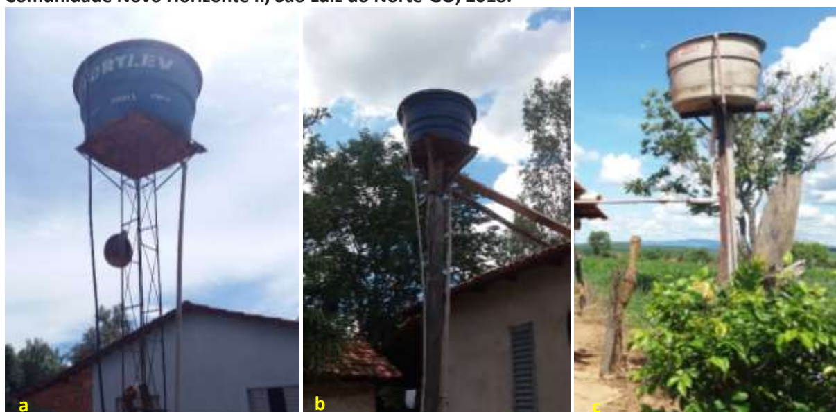
Foto 6.5 – Reservatórios domiciliares: em fibra de vidro instalado sobre estrutura metálica (a), em polietileno sobre estrutura de madeira (b) e de fibrocimento sobre estrutura de madeira (c), na Comunidade Novo Horizonte II, São Luiz do Norte-GO, 2018.
