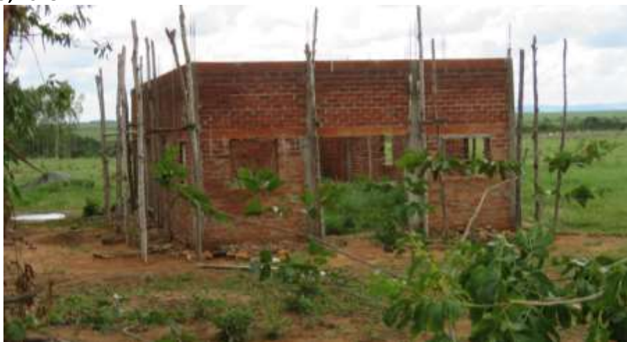
Foto 4.5 – Igreja evangélica em construção, identificada na Comunidade Novo Horizonte II, São Luiz do Norte-GO, 2018.
