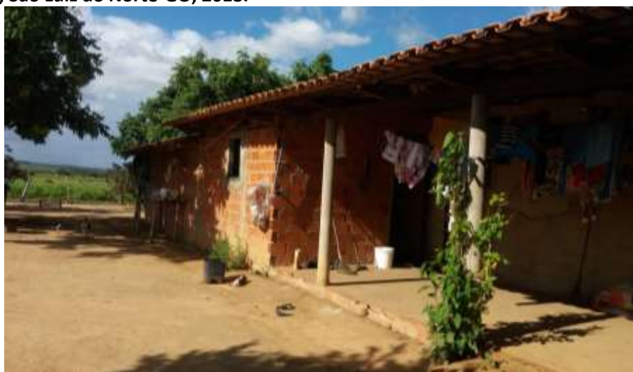
Foto 4.10 – Piso de residência constituído de concreto bruto, identificado na Comunidade Novo Horizonte II, São Luiz do Norte-GO, 2018.
