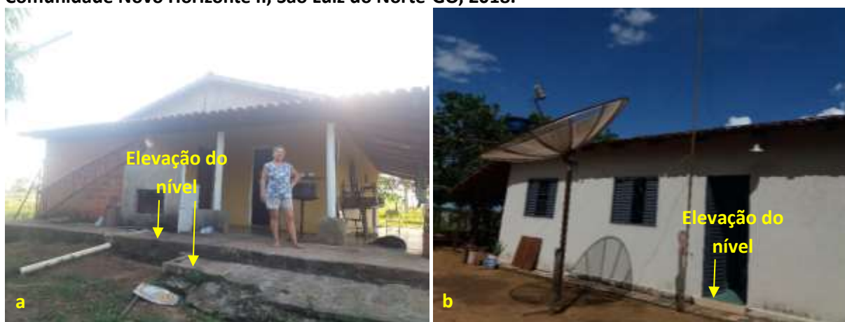
Foto 6.19 – Dispositivos de prevenção dos danos provocados pelas águas em residências da Comunidade Novo Horizonte II, São Luiz do Norte-GO, 2018.
