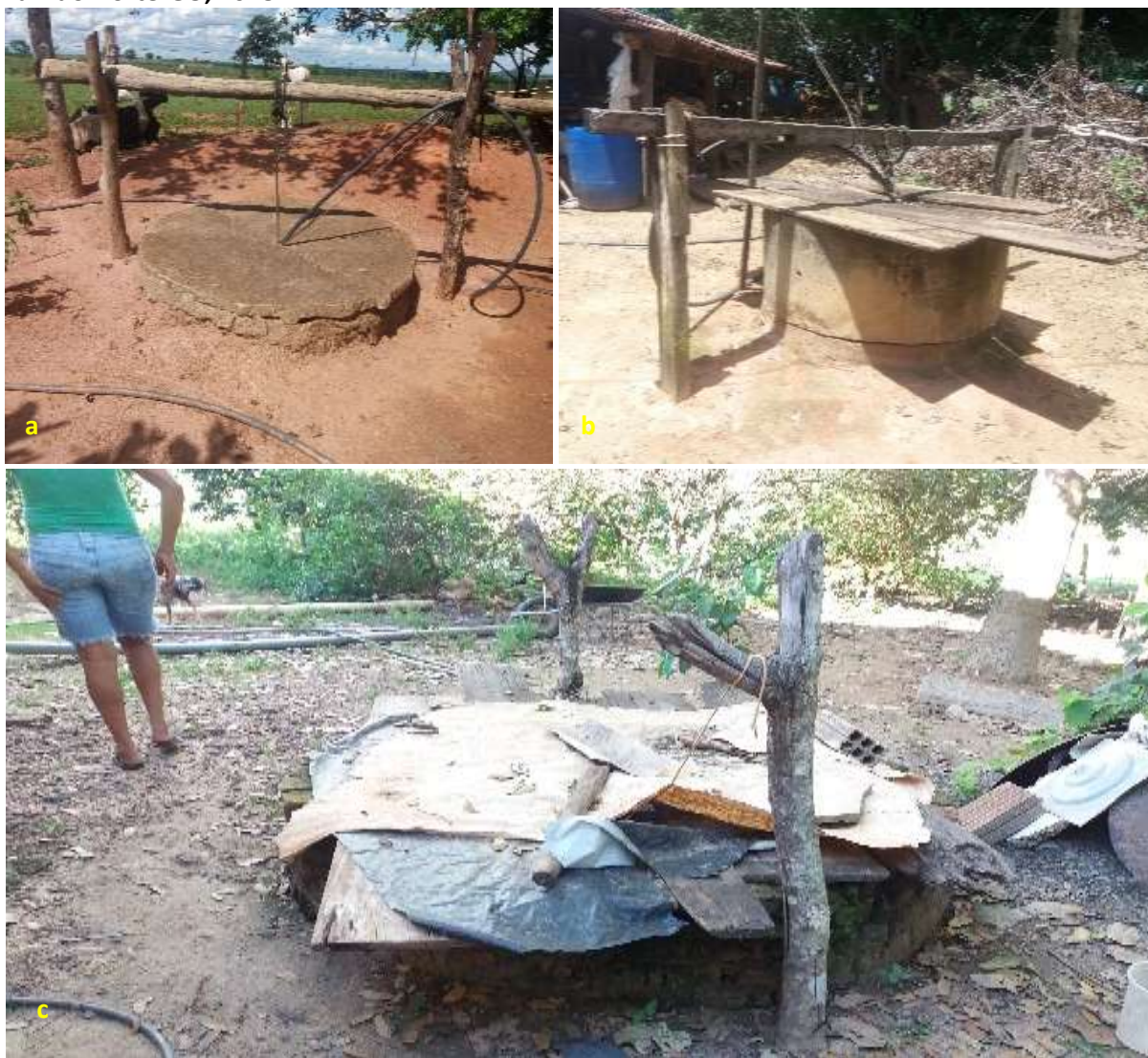
Foto 6.3 – Poços rasos escavados tampados com tampa de concreto (a), madeira (b), e de forma improvisada com plástico, pedaços de madeira e tijolos (c), na Comunidade Novo Horizonte II, São Luiz do Norte-GO, 2018.
