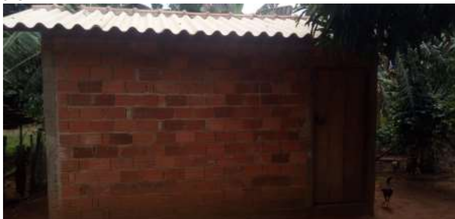
Foto 4.14 – Cobertura de fibrocimento, identificada na Comunidade Novo Horizonte II, São Luiz do Norte-GO, 2018.
