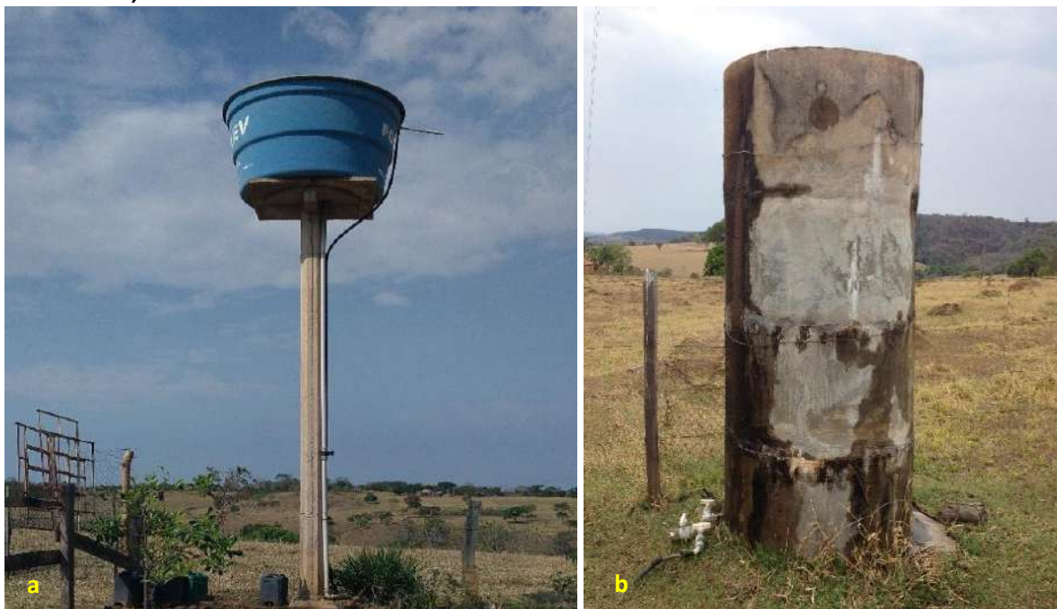
Foto 6.5 – Reservatório suspenso de polietileno dotado de extravasor (a) e reservatório apoiado de anéis de concreto com sinais de transbordamento (b) na Comunidade Nascente São Domingos, Piranhas-GO, 2018.
