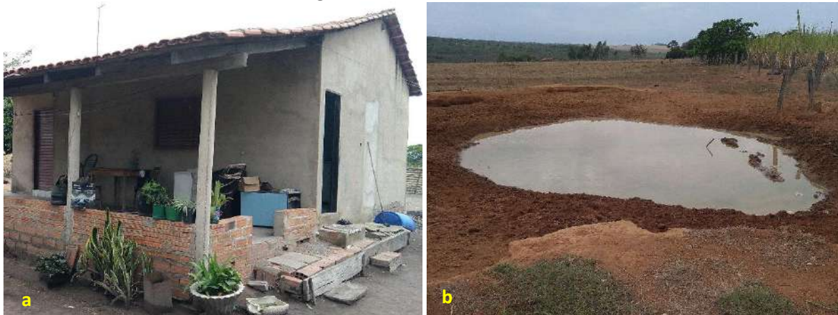
Foto 6.27 – Dispositivos de prevenção dos danos provocados pelas águas em residência (a) e lote (b) da Comunidade Nascente São Domingos, Piranhas-GO, 2018.
