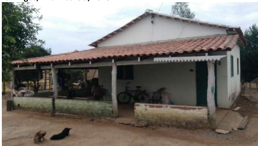
Foto 4.5 – Habitação construída de alvenaria com reboco e pintura, identificada na Comunidade Nascente São Domingos, Piranhas-GO, 2018.
