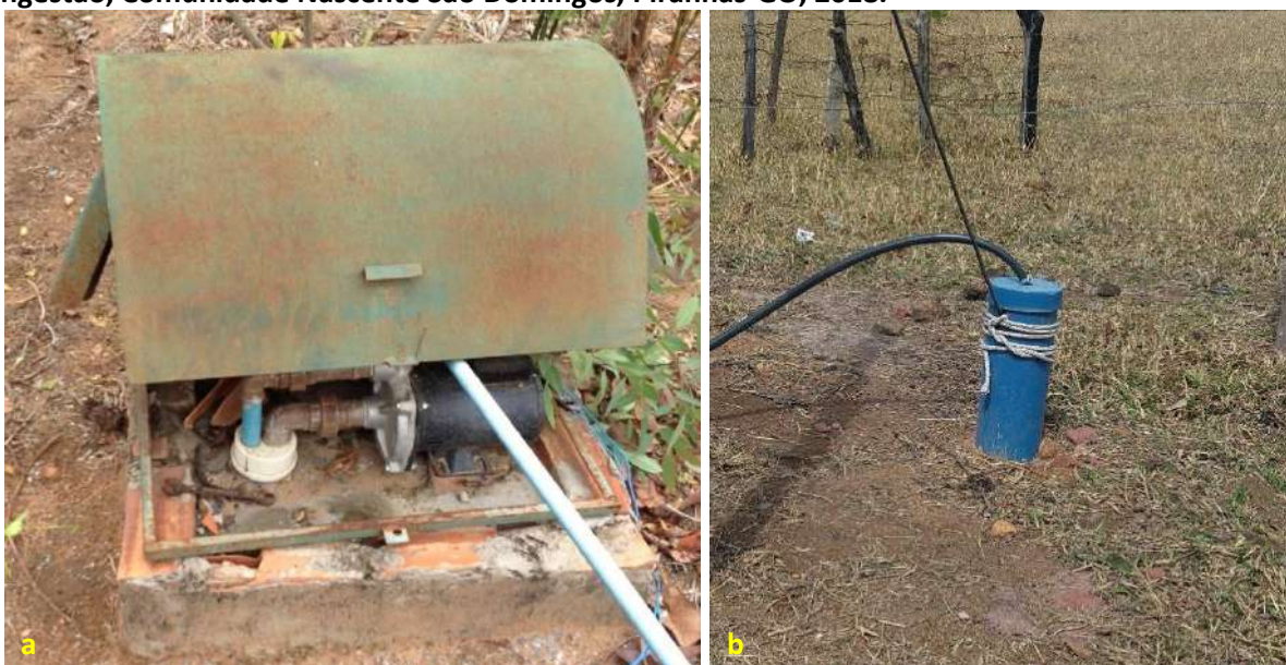
Foto 6.1 – Poço tubular raso (a) e poço tubular profundo (b) utilizados para obtenção de água para ingestão, Comunidade Nascente São Domingos, Piranhas-GO, 2018.
