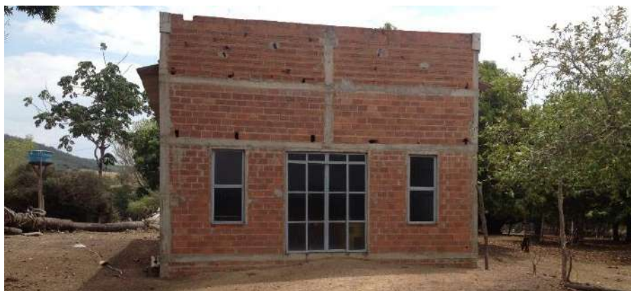
Foto 4.1 – Igreja assembleia de Deus, identificada na Comunidade Nascente São Domingos Piranhas-GO, 2018.
