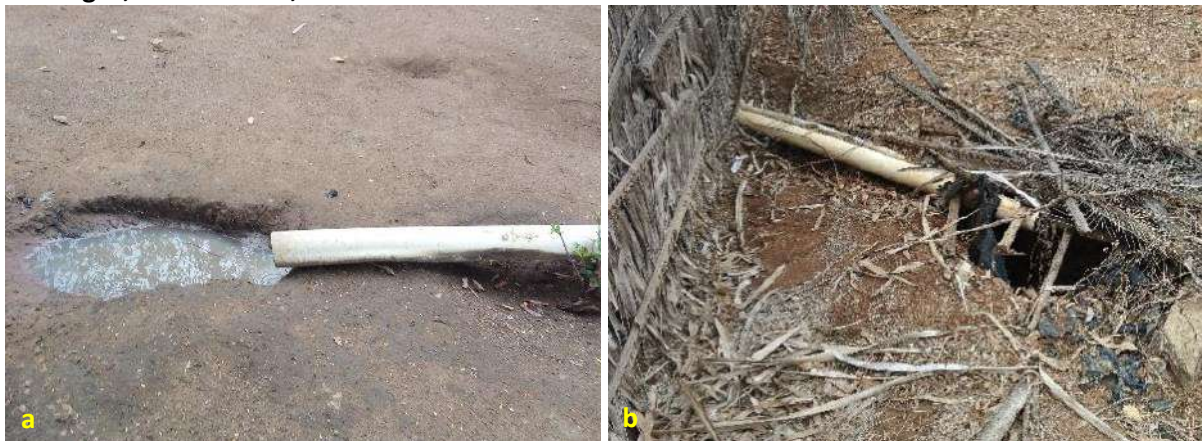
Foto 6.10 – Lançamento e acúmulo de água cinza proveniente da pia da cozinha e da lavagem de roupas diretamente no solo do quintal próximo aos domicílios (a) e (b) na Comunidade Nascente São Domingos, Piranhas-GO, 2018.
