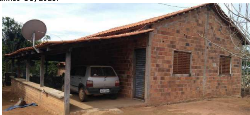
Foto 4.3 – Habitação construída de alvenaria sem reboco, identificada na Comunidade Nascente São Domingos, Piranhas-GO, 2018.
