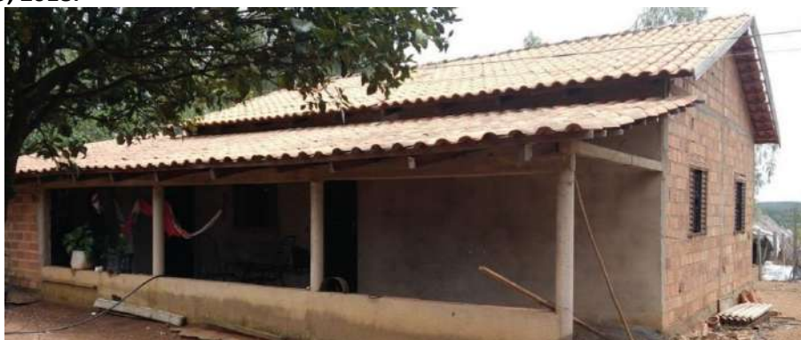
Foto 4.8 – Telha de barro, identificada nas habitações da Comunidade Nascente São Domingos, Piranhas-GO, 2018.
