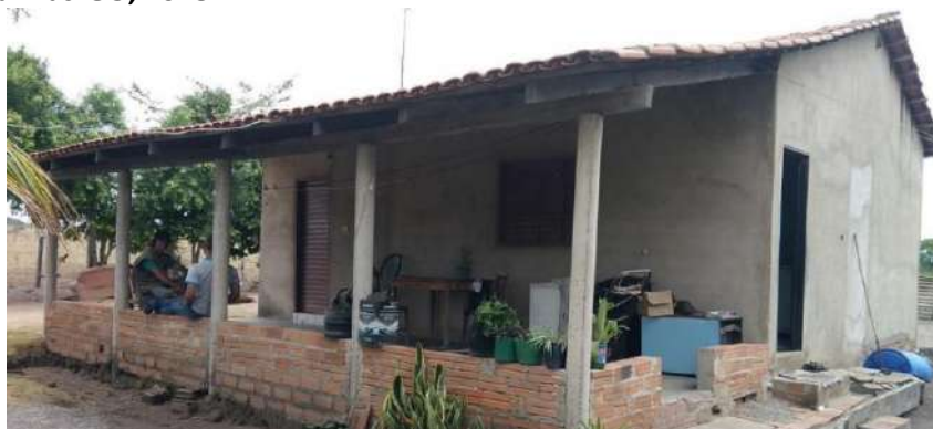
Foto 4.4 – Habitação construída de alvenaria com reboco, identificada na Comunidade Nascente São Domingos, Piranhas-GO, 2018.
