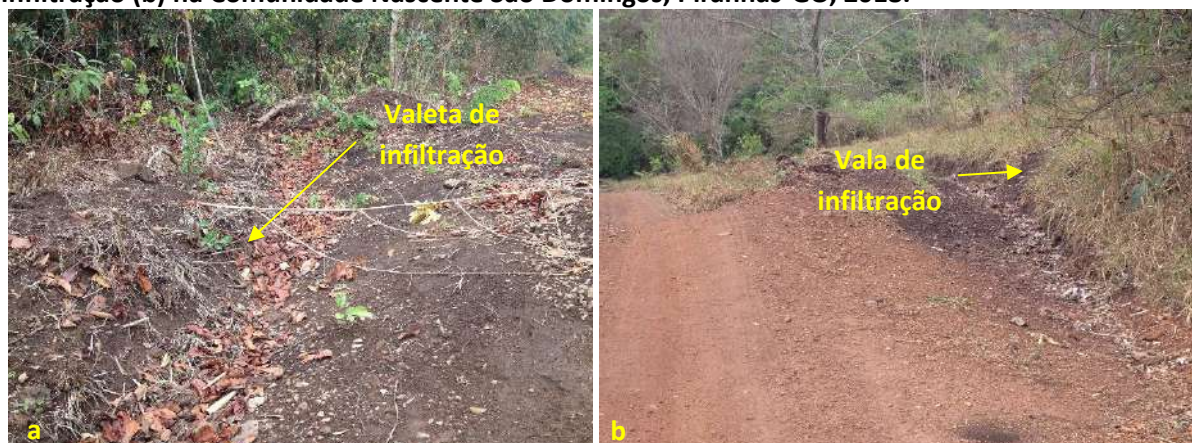
Foto 6.20 – Situação da drenagem pluvial na via de acesso: valeta de infiltração (a) e vala de infiltração (b) na Comunidade Nascente São Domingos, Piranhas-GO, 2018.
