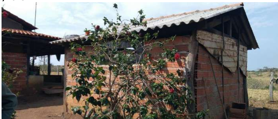
Foto 4.9 – Cobertura de telha fibrocimento, identificada na Comunidade Nascente São Domingos, Piranhas-GO, 2018.
