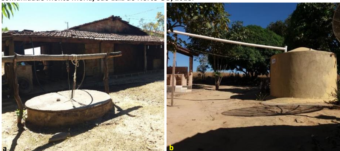
Foto 6.1 – Poço raso escavado (a) e cisterna para armazenamento de água de chuva (b) na Comunidade Monte Moria, São Luiz do Norte-GO, 2018.
