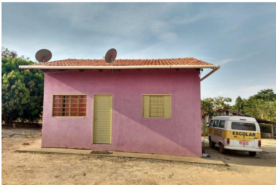
Foto 4.5 – Cobertura de telha de barro, identificada na Comunidade Monte Moria, São Luiz do Norte-GO, 2018.
