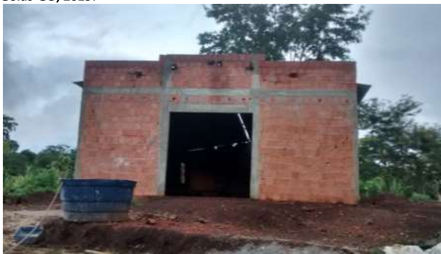
Foto 4.2 – Igreja evangélica em construção identificada na Comunidade de Mimoso (Queixo Dantas), Mimoso de Goiás-GO, 2019.
