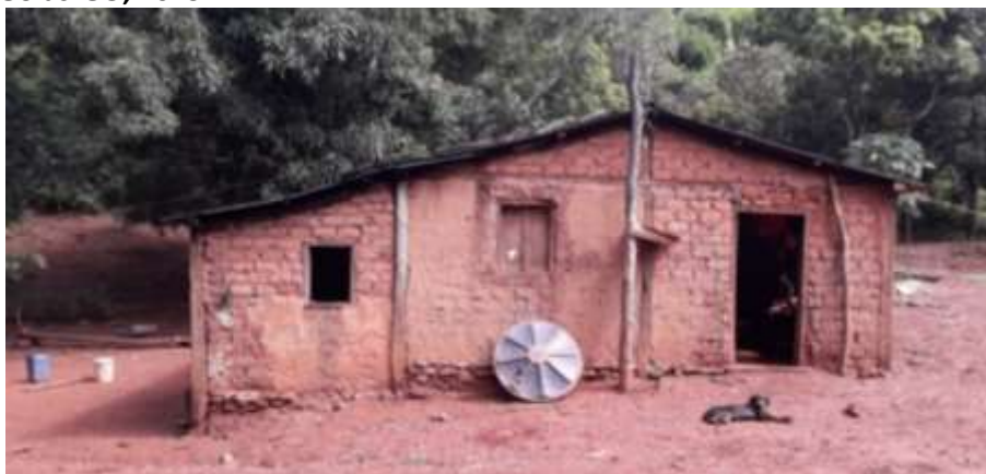
Foto 4.8 – Habitação construída de adobe, identificada na Comunidade de Mimoso (Queixo Dantas), Mimoso de Goiás-GO, 2019.
