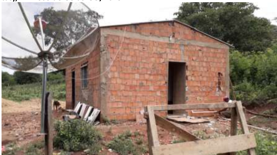
Foto 4.5 – Habitação construída de alvenaria sem reboco, identificada na Comunidade de Mimoso (Queixo Dantas), Mimoso de Goiás-GO, 2019.
