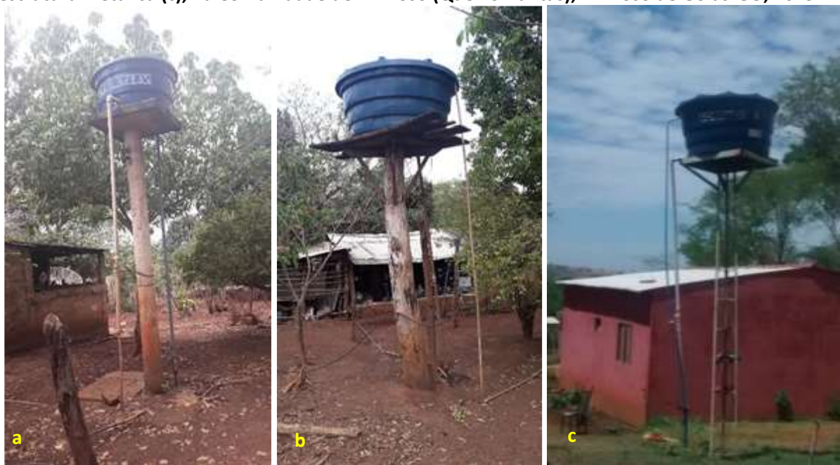
Foto 6.6 – Reservatório de polietileno instalado sobre estrutura de concreto (a), madeira (b) e estrutura metálica (c), na Comunidade de Mimoso (Queixo Dantas), Mimoso de Goiás-GO, 2019.
