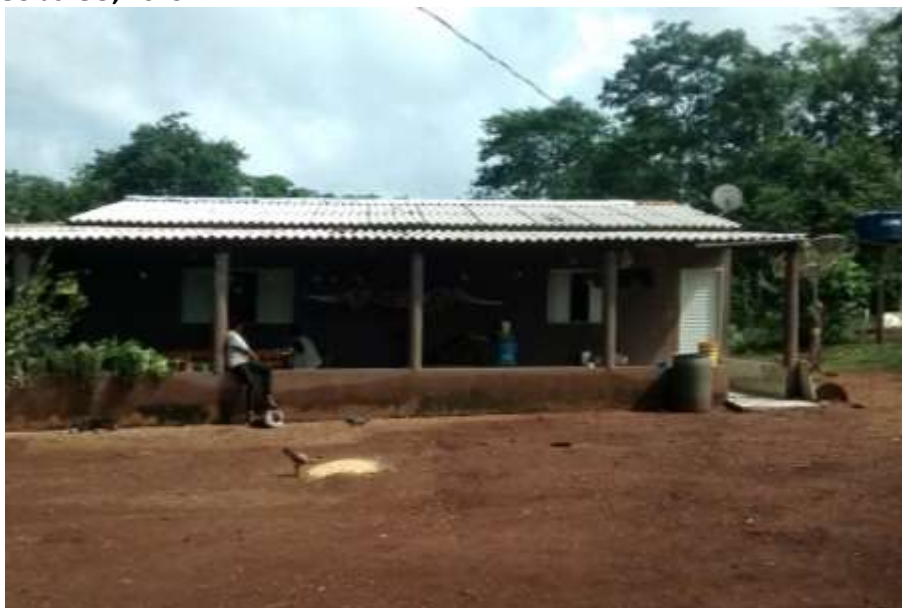
Foto 4.11 – Cobertura de fibrocimento, identificada na Comunidade de Mimoso (Queixo Dantas), Mimoso de Goiás-GO, 2019.
