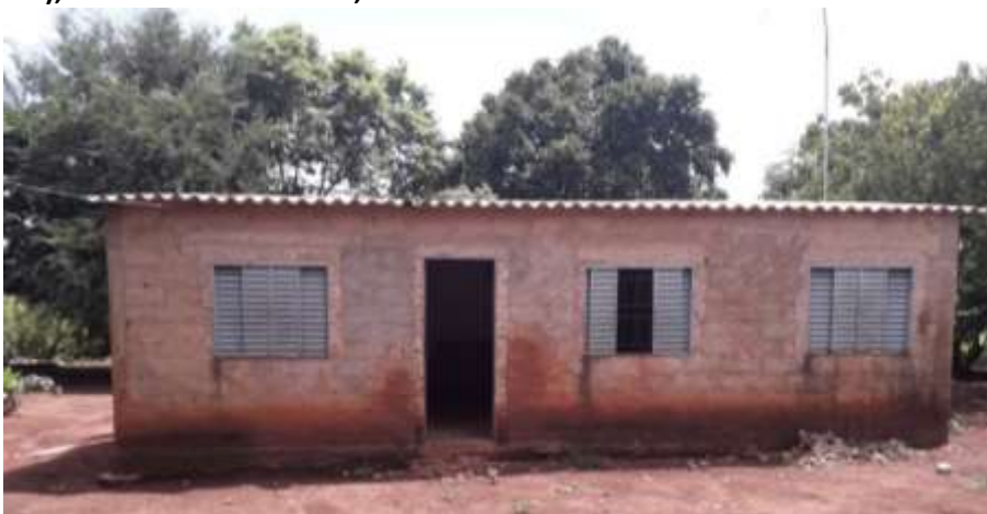
Foto 4.7 – Habitação construída de alvenaria com reboco, identificada na Comunidade de Mimoso (Queixo Dantas), Mimoso de Goiás-GO, 2019.
