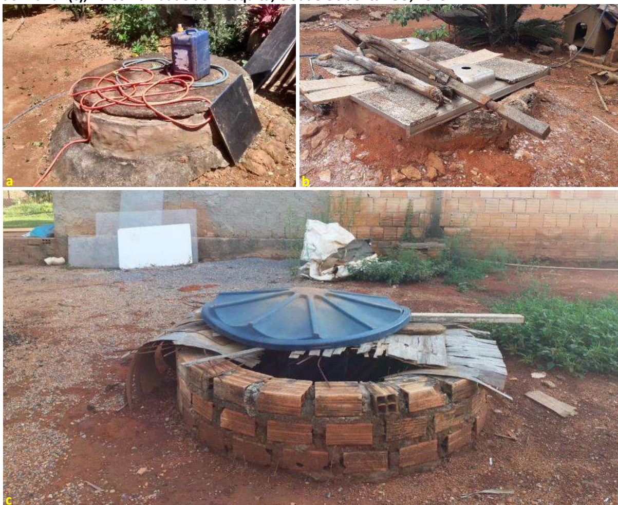
Foto 6.6 – Poço raso escavado desativado com contorno parcialmente calçado (a) e tampas feitas com material improvisado, como madeira, bancada de pia (b) tapume e tampa de reservatório domiciliar (c), na Comunidade de Mesquita, Cidade Ocidental-GO, 2019.
