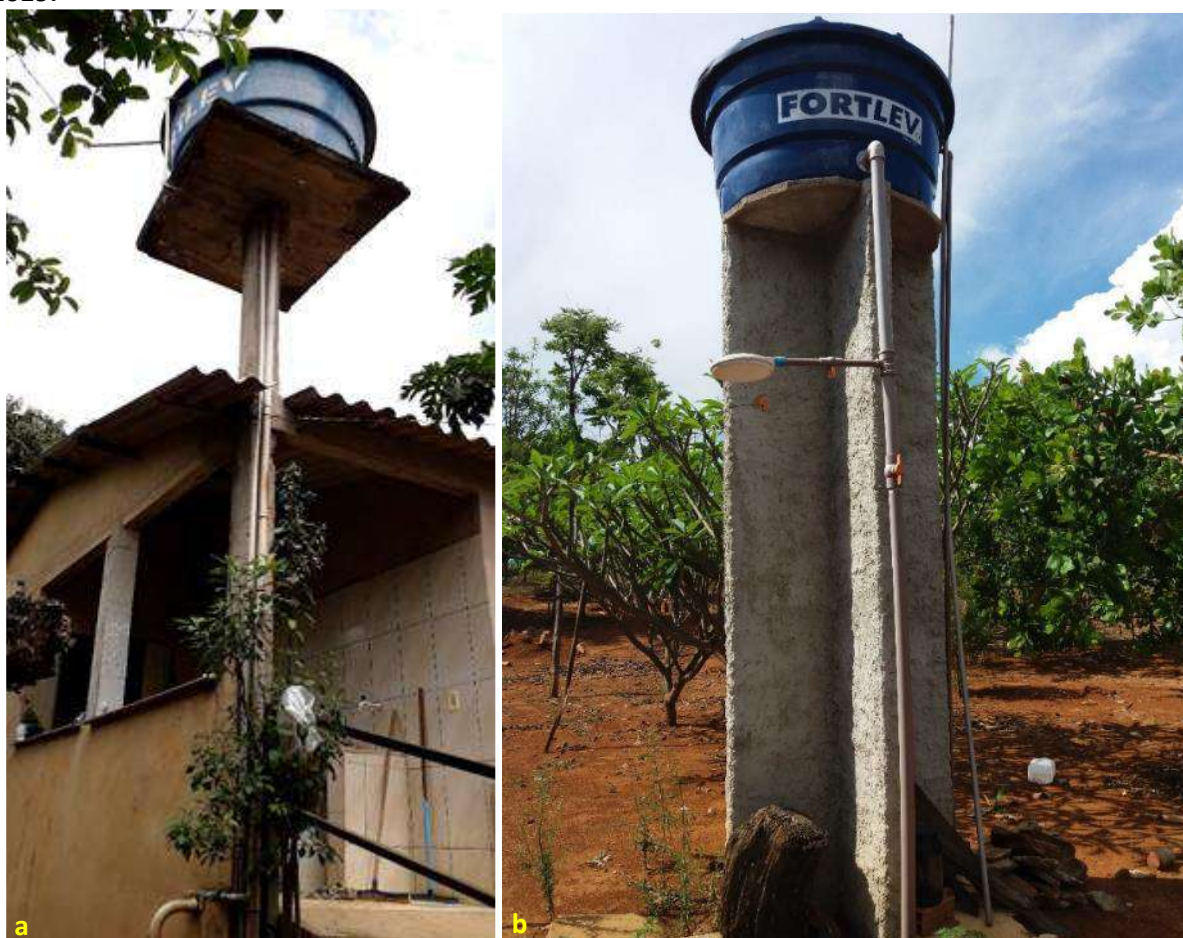
Foto 6.7 – Reservatório domiciliar de polietileno com extravasor e tampa amarrada, instalado sobre estrutura de concreto(a) e de alvenaria (b), na Comunidade de Mesquita, Cidade Ocidental-GO, 2019.
