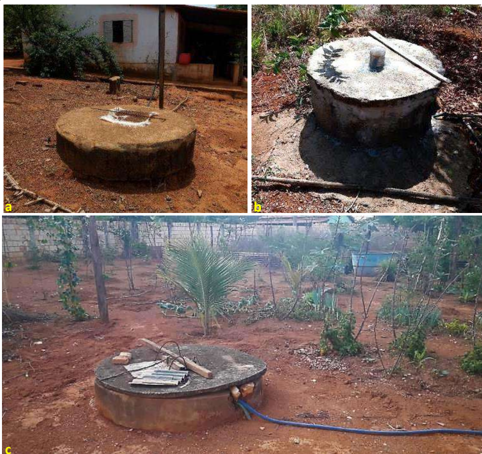
Foto 6.5 – Poço raso escavado com tampa feita em concreto (a), calçamento ao redor do poço raso escavado (b) e poço sem cercamento exclusivo (c), na Comunidade de Mesquita, Cidade Ocidental-GO, 2019.
