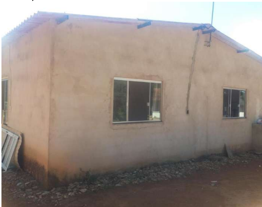
Foto 4.19 – Habitação construída de alvenaria com reboco, identificada na Comunidade de Mesquita, Cidade Ocidental-GO, 2019.
