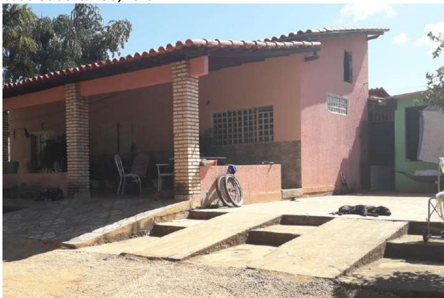
Foto 4.21 – Habitação construída de alvenaria com reboco e pintura, identificada na Comunidade de Mesquita, Cidade Ocidental-GO, 2019.
