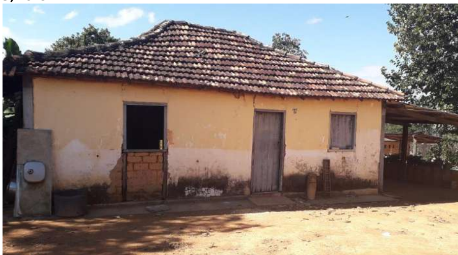
Foto 4.20 – Habitação construída de adobe, identificada na Comunidade de Mesquita, Cidade Ocidental-GO, 2019.
