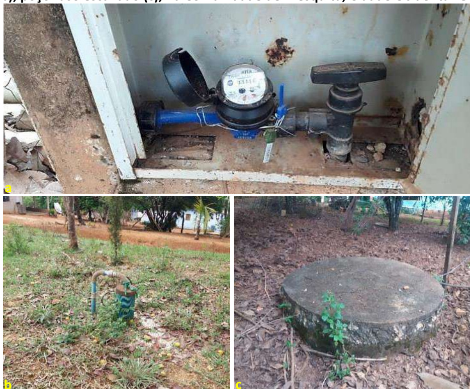
Foto 6.1 – Fontes de abastecimento de água, sendo micromedidor de água do SAA (a), poço tubular profundo (b), poço raso escavado (c), na Comunidade de Mesquita, Cidade Ocidental-GO, 2019.
