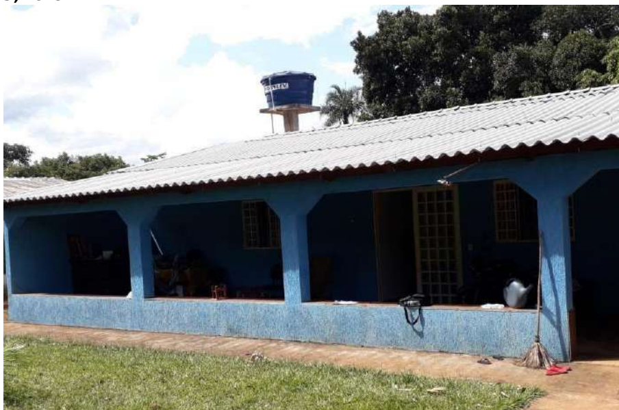
Foto 4.25 – Cobertura com telha de fibrocimento, identificada na Comunidade de Mesquita, Cidade Ocidental-GO, 2019.
