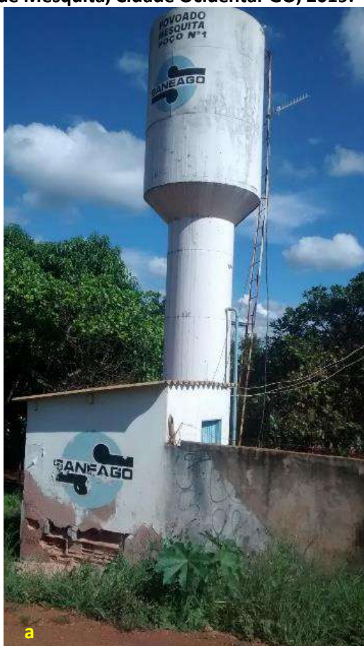
Foto 6.4 – Estrutura de alvenaria que abriga o sistema elétrico e o reservatório R1 (a), e portão com placa de identificação do sistema de abastecimento de água do reservatório R2 (b), na Comunidade de Mesquita, Cidade Ocidental-GO, 2019.
