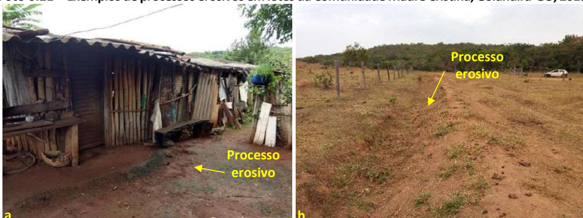
Foto 6.21 – Exemplos de processos erosivos em lotes da Comunidade Madre Cristina, Goiandira-GO, 2018.
