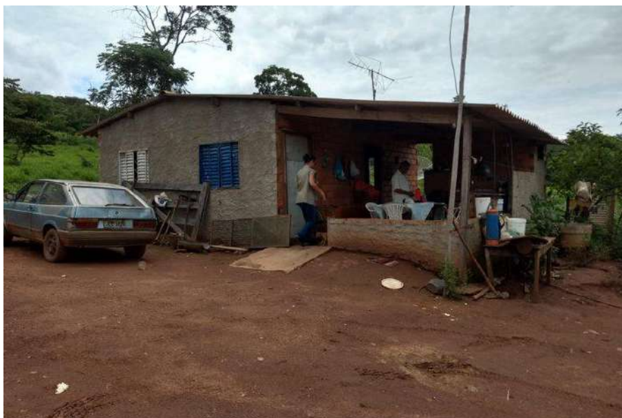
Foto 4.6 – Cobertura de telha fibrocimento, identificada na Comunidade Madre Cristina, Goiandira-GO, 2019.
