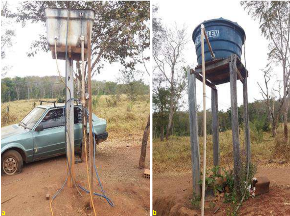
Foto 6.3 – Reservatório domiciliar de fibrocimento com extravasor(a) e reservatório de polietileno tampado (b) na Comunidade Madre Cristina, Goiandira-GO, 2018.
