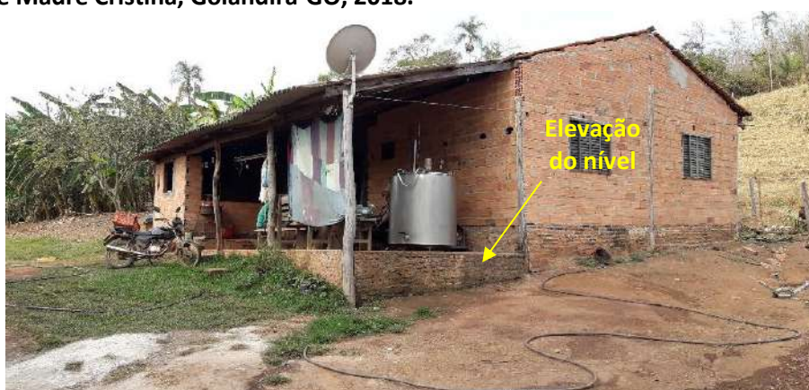
Foto 6.20 – Dispositivo de prevenção dos danos provocados pelas águas em residência da Comunidade Madre Cristina, Goiandira-GO, 2018.
