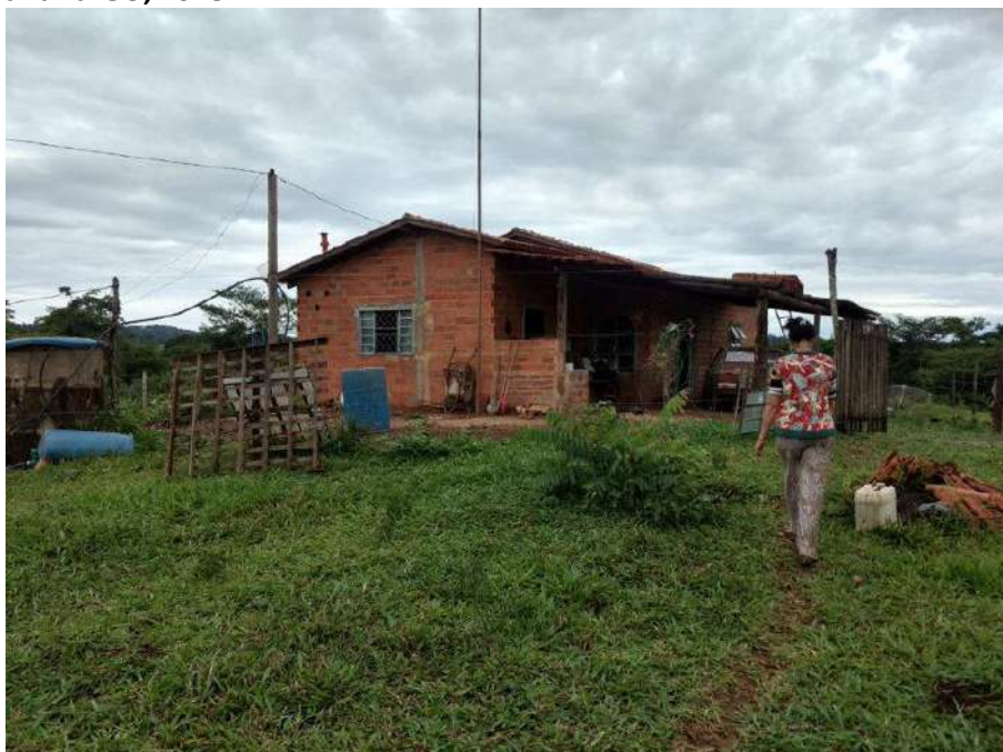
Foto 4.1 – Habitação construída de alvenaria sem reboco, identificada na Comunidade Madre Cristina, Goiandira-GO, 2018.
