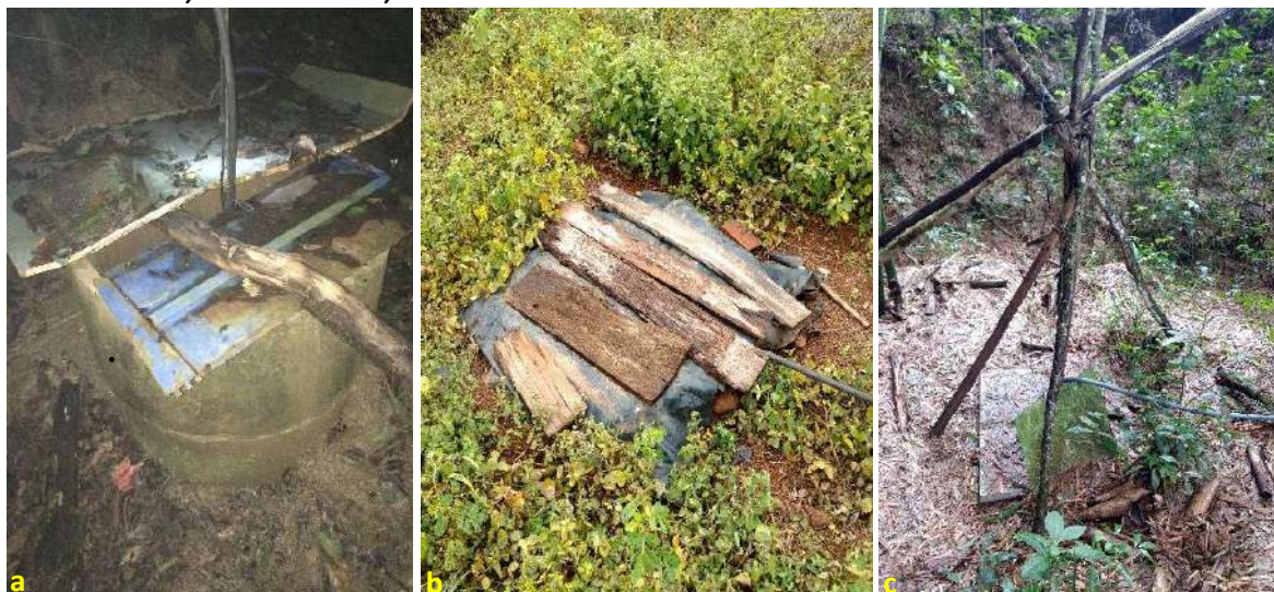
Foto 6.2 – Poços rasos escavados em diferentes condições, com existência de mureta de proteção (a) e coberto com pedaços de madeira e outros materiais de forma improvisada (b; c) na Comunidade Madre Cristina, Goiandira-GO, 2018.
