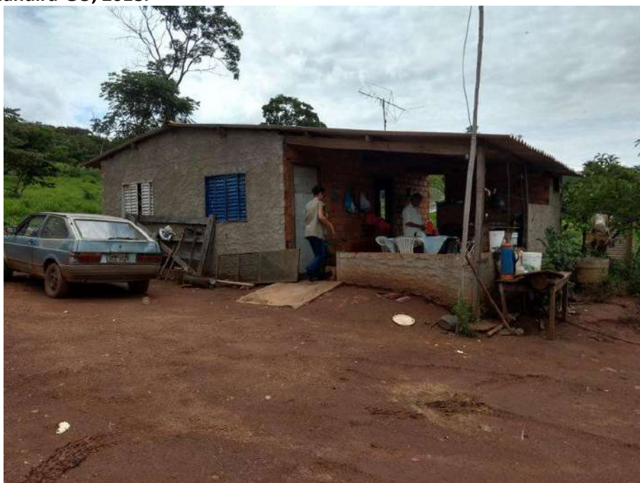
Foto 4.2 – Habitação construída de alvenaria com e sem reboco, identificada na Comunidade Madre Cristina, Goiandira-GO, 2018.
