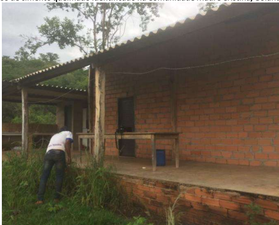
Foto 4.3 – Piso de cimento queimado identificado na Comunidade Madre Cristina, Goiândia-GO, 2018.
