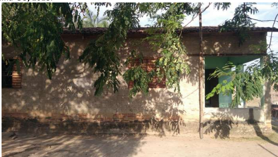
Foto 4.3 – Habitação construída de alvenaria com reboco sem pintura, identificada na Comunidade Limoeiro, Faina-GO, 2018.
