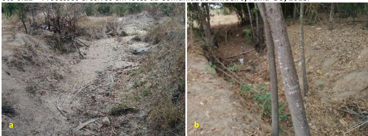
Foto 6.22 – Processos erosivos em lotes da Comunidade Limoeiro, Faina-GO, 2018.
