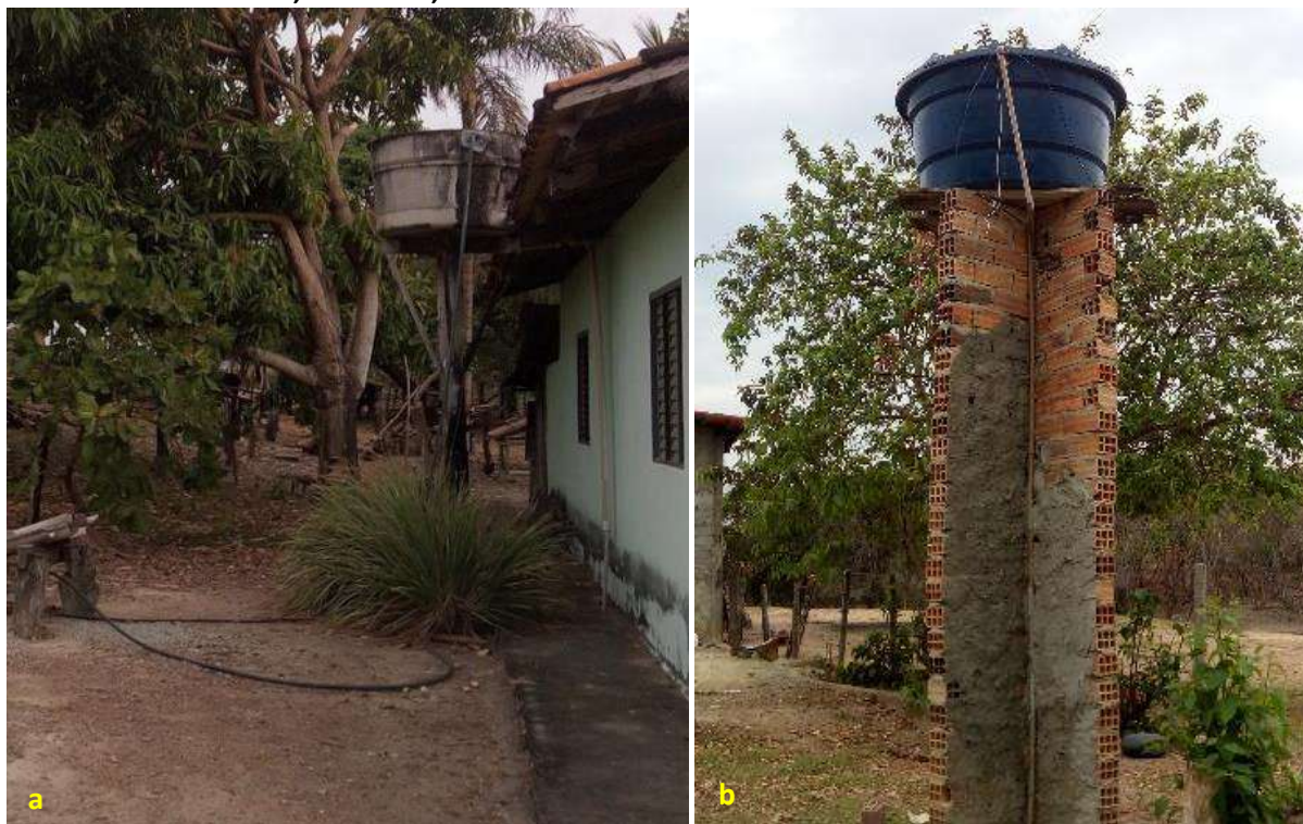
Foto 6.5 - Reservatórios domiciliares instalados sobre estrutura em madeira (a) ou alvenaria (b), na Comunidade Limoeiro, Faina-GO, 2018.
