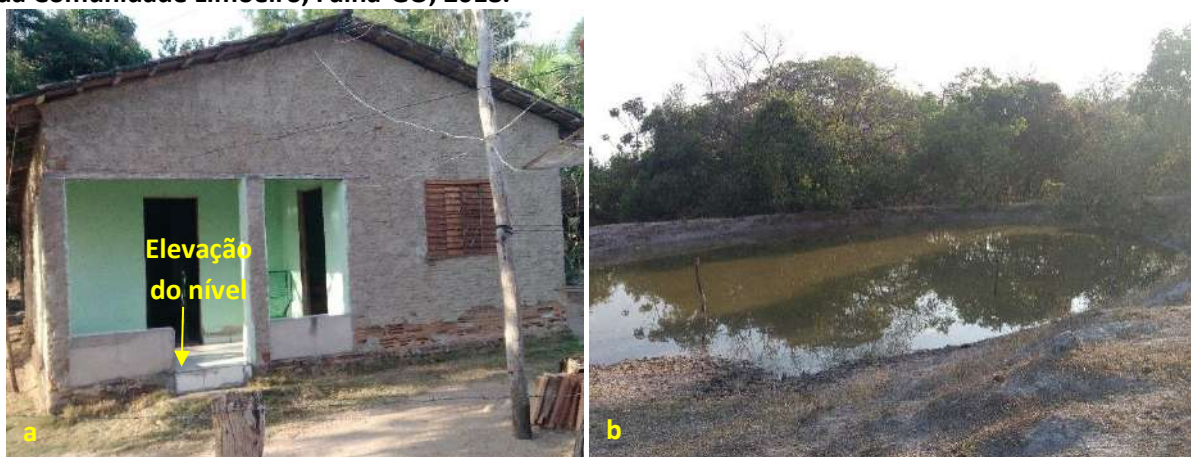
Foto 6.21 – Dispositivos de prevenção dos danos provocados pelas águas em residência (a) e lote (b) da Comunidade Limoeiro, Faina-GO, 2018.
