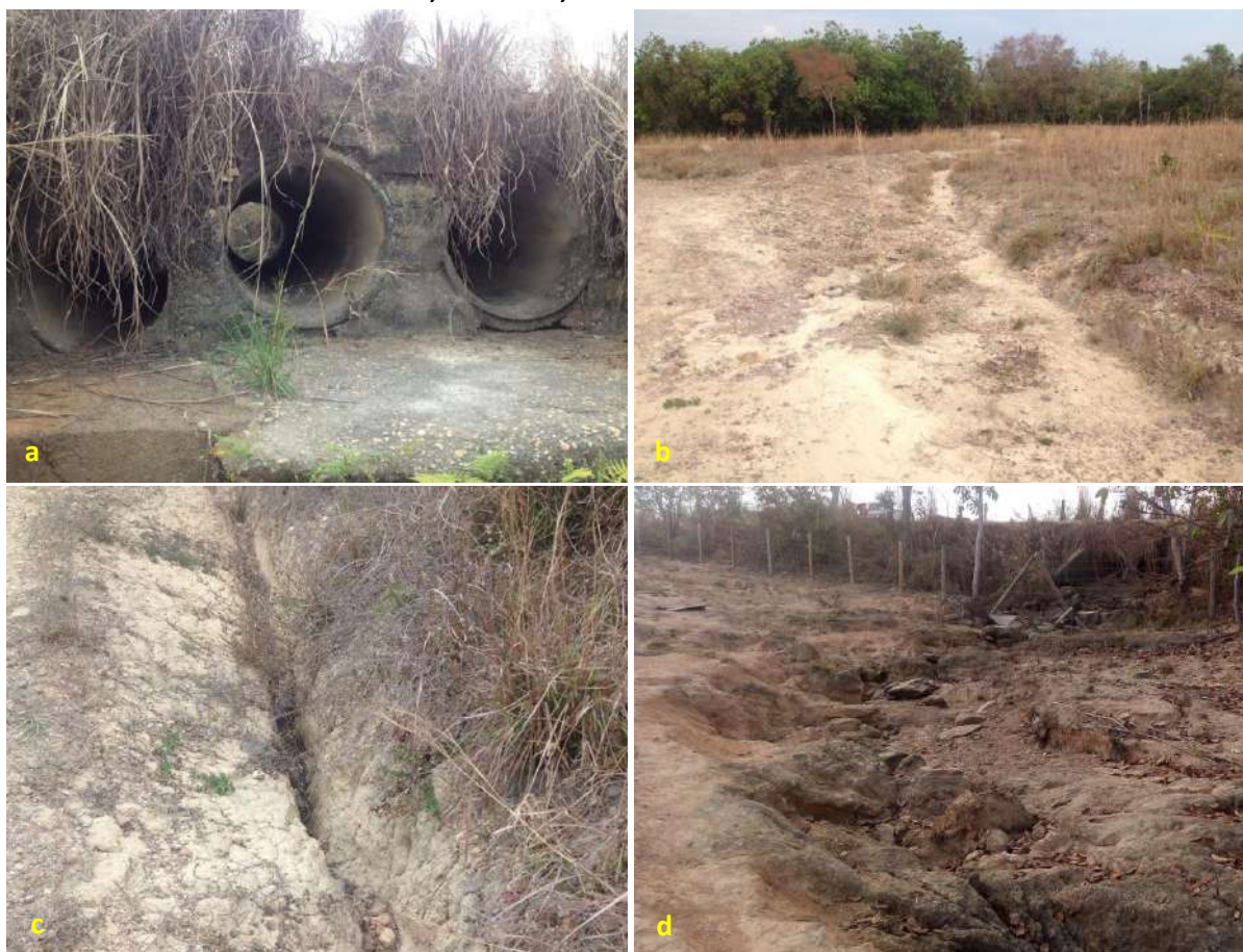
Foto 6.17 – Bueiro (a), vala de infiltração (b), valeta (c) e processos erosivos (d), na margem da via de acesso à Comunidade Limoeiro, Faina-GO, 2018.
