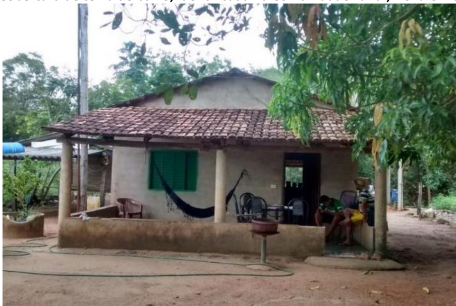
Foto 4.10 – Cobertura de telha de barro, identificada na Comunidade Landi, Nova Crixás-GO, 2019.
