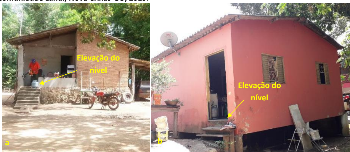
Foto 6.21 – Dispositivos de prevenção dos danos provocados pelas águas em residências da Comunidade Landi, Nova Crixás-GO, 2019.
