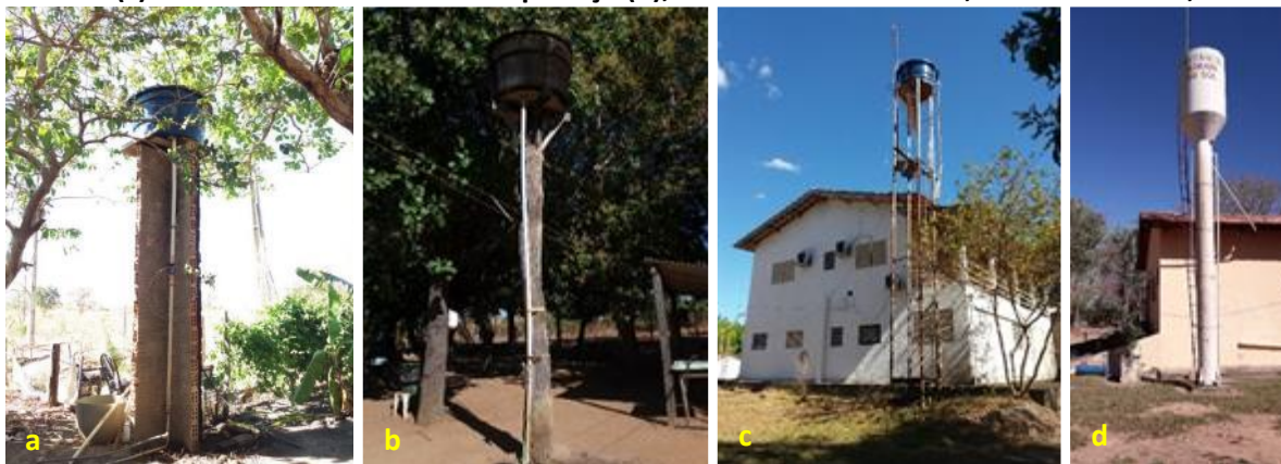
Foto 6.5 – Reservatório instalado sobre estrutura de alvenaria (a), madeira (b) ou de material metálico (c) e reservatório elevado do tipo taça (d), na Comunidade Landi, Nova Crixás-GO, 2019.
