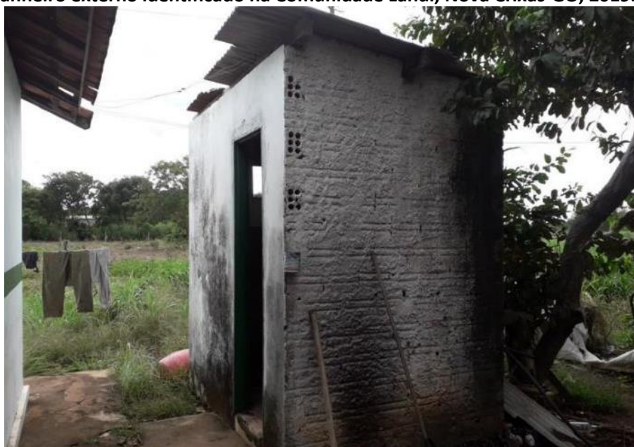
Foto 4.4 – Banheiro externo identificado na Comunidade Landi, Nova Crixás-GO, 2019.
