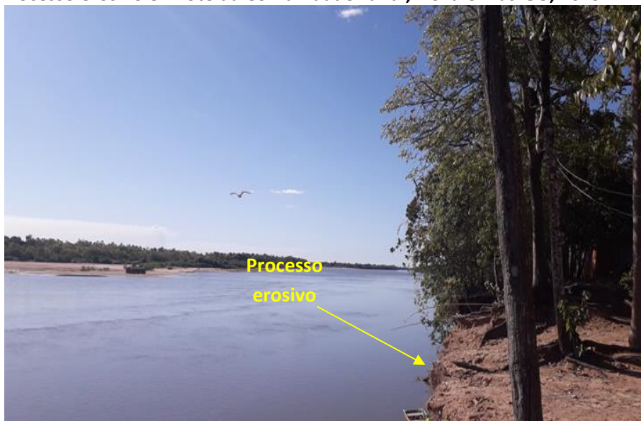
Foto 6.22 – Processo erosivo em lote da Comunidade Landi, Nova Crixás-GO, 2019.
