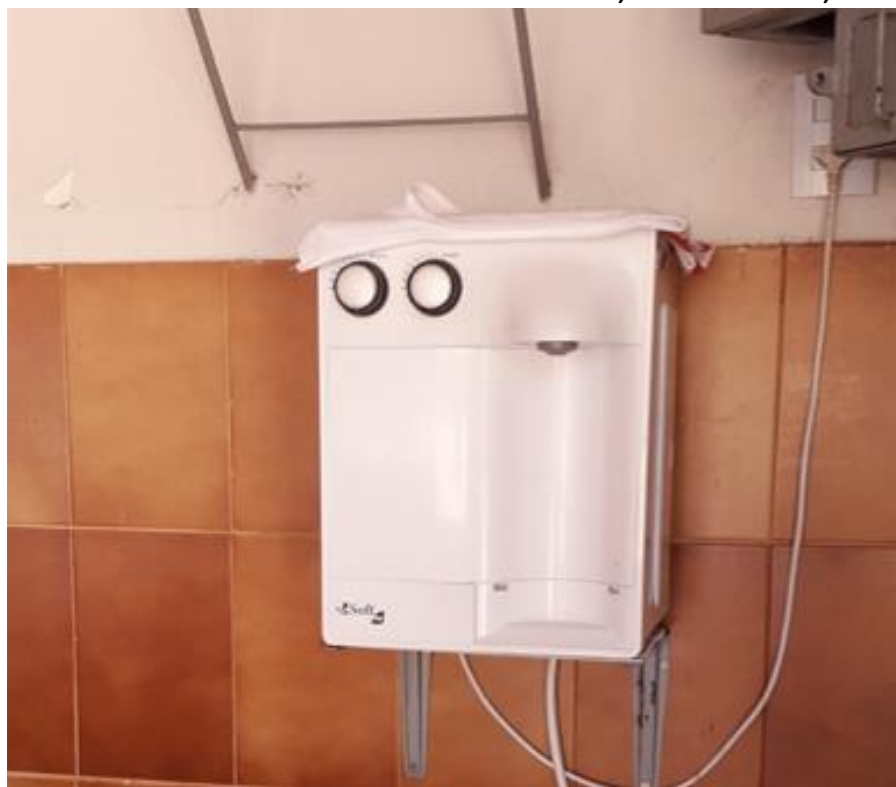
Foto 6.6 – Filtro elétrico de um domicílio da Comunidade Landi, Nova Crixás-GO, 2019.
