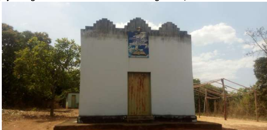
Foto 4.2 – Igreja evangélica identificada na Comunidade Lagoa Seca, Santa Rita do Novo Destino-GO, 2018.
