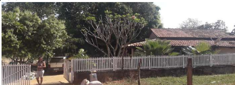
Foto 4.9 – Cobertura de telha de barro, identificada na Comunidade Lagoa Seca, Santa Rita do Novo Destino-GO, 2018.
