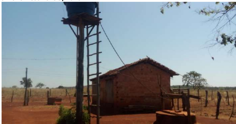
Foto 4.6 – Habitação construída de alvenaria sem reboco, identificada na Comunidade Lagoa Seca, Santa Rita do Novo Destino-GO, 2018.
