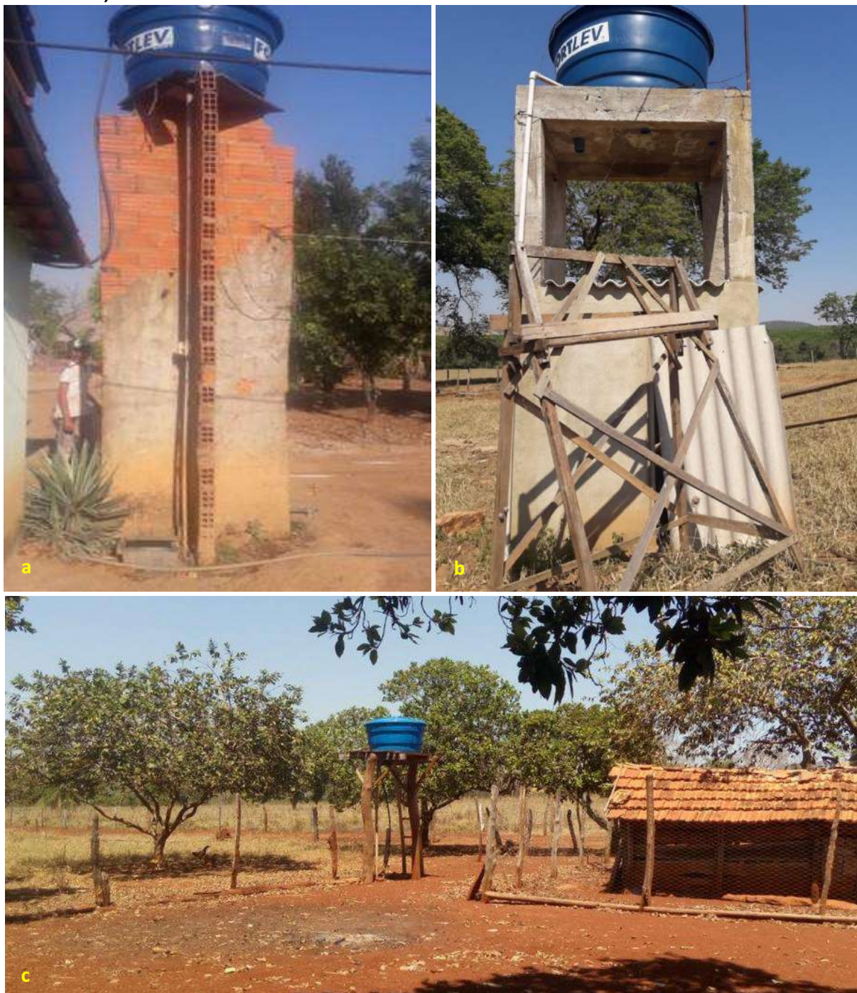
Foto 6.8 – Reservatórios em polietileno instalados sobre: estrutura em alvenaria de tijolos (a), estrutura de concreto (b) e estrutura de madeira (c), Comunidade Lagoa Seca, Santa Rita do Novo Destino-GO, 2018.
