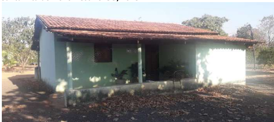
Foto 4.4 – Habitação construída de alvenaria com reboco e pintura, identificada na Comunidade Lagoa Seca, Santa Rita do Novo Destino-GO, 2018.
