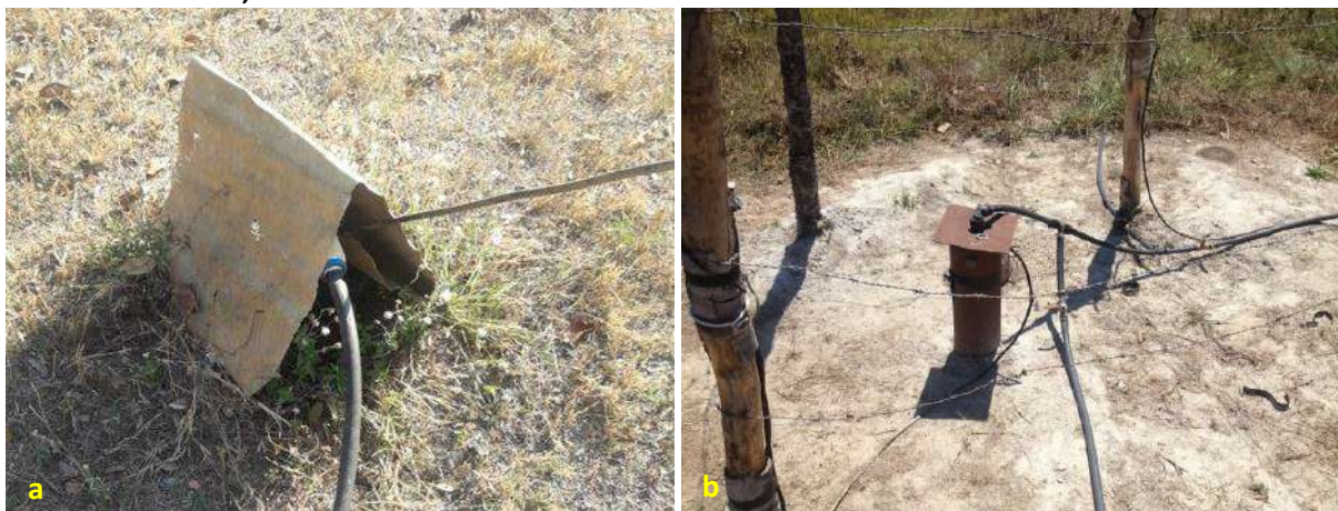
Foto 6.6 – Poços tubulares profundos, com ausência de cerca e com cobertura improvisada por telha de zinco (a) e com presença de cerca e chapa metálica (b) Comunidade Lagoa Seca, Santa Rita do Novo Destino-GO, 2018.
