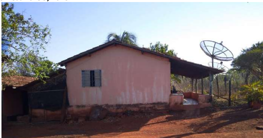
Foto 4.8 – Piso de residência constituído de cerâmica, identificado na Comunidade Lagoa Seca, Santa Rita do Novo Destino-GO, 2018.
