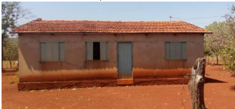
Foto 4.5 – Habitação construída de alvenaria com reboco sem pintura, identificada na Comunidade Lagoa Seca, Santa Rita do Novo Destino-GO, 2018.
