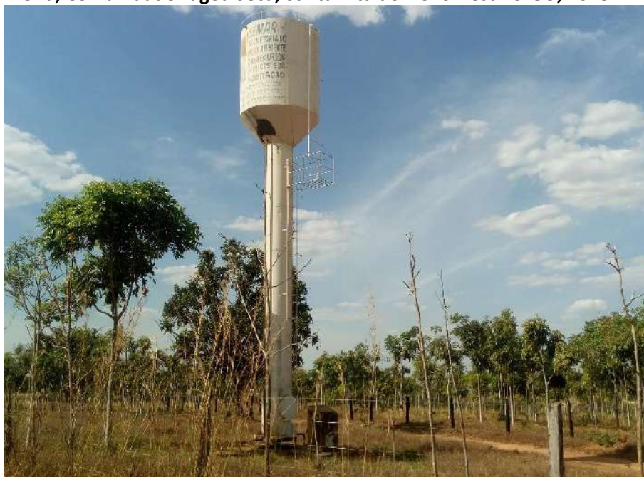
Foto 6.3 – Reservatório de distribuição do SAA parcialmente cercado e com uma caixa de proteção para uma torneira, Comunidade Lagoa Seca, Santa Rita do Novo Destino-GO, 2018.
