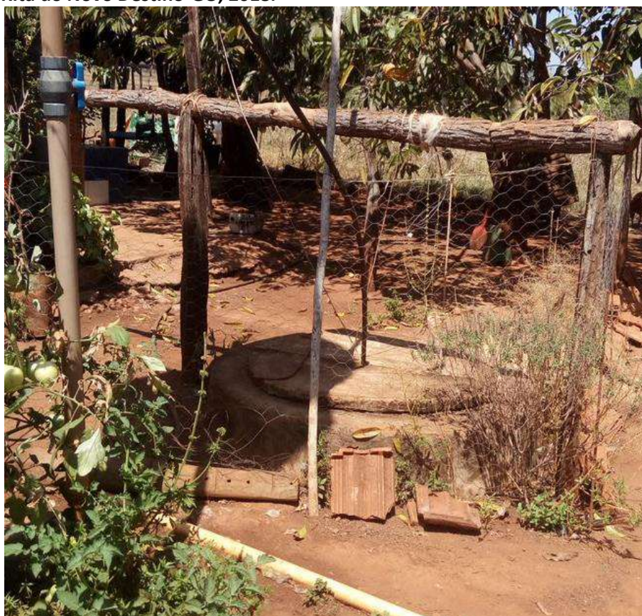
Foto 6.4 – Poço raso escavado com mureta de proteção e tampa de concreto, Comunidade Lagoa Seca, Santa Rita do Novo Destino-GO, 2018.
