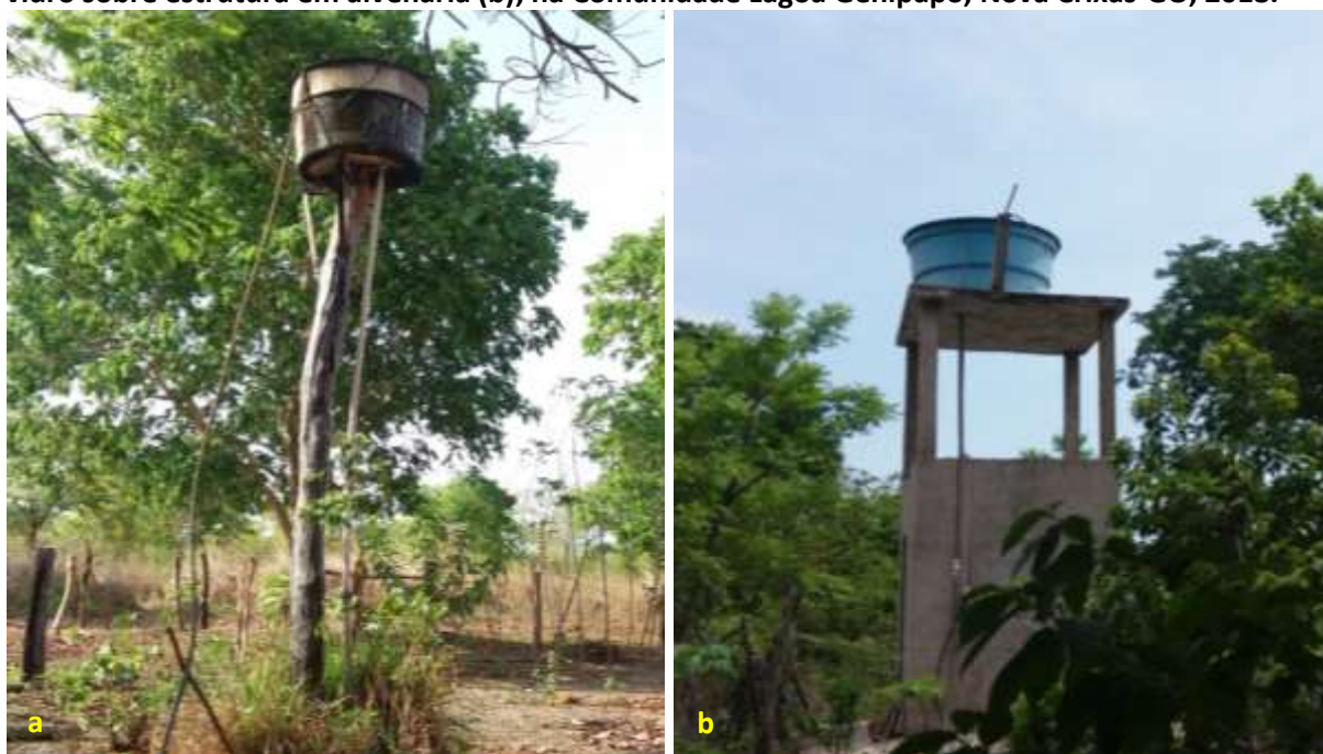
Foto 6.4 – Reservatórios domiciliares: de fibrocimento sobre estrutura em madeira (a), de fibra de vidro sobre estrutura em alvenaria (b), na Comunidade Lagoa Genipapo, Nova Crixás-GO, 2018.
