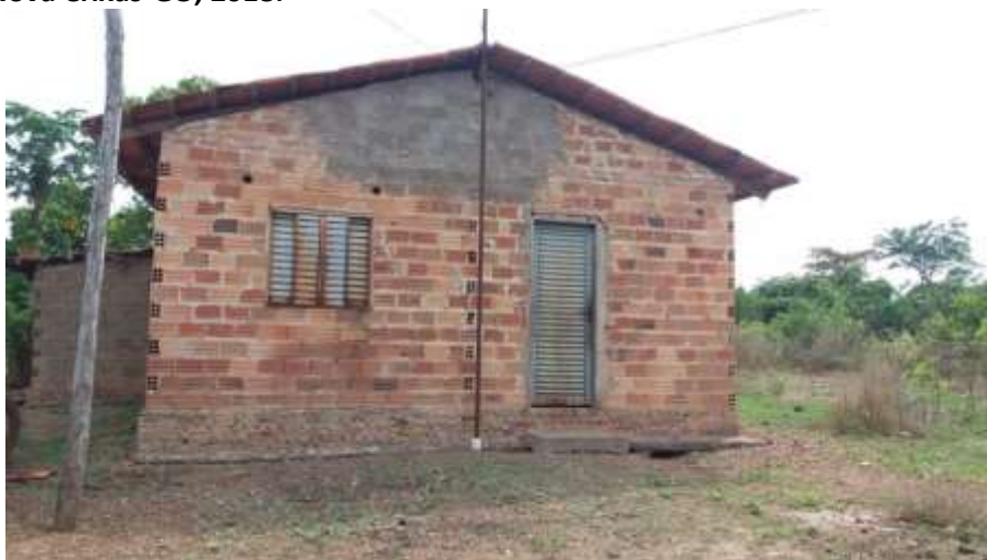
Foto 4.8 – Habitação construída de alvenaria sem reboco, identificada na Comunidade Lagoa Genipapo, Nova Crixás-GO, 2018.
