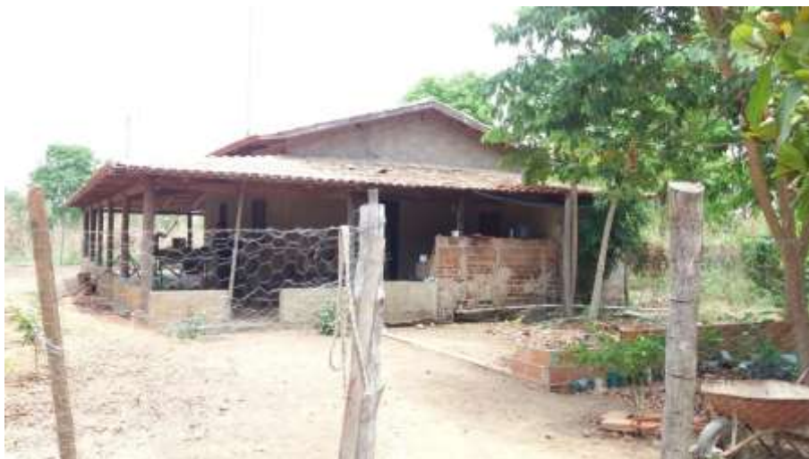
Foto 4.11 – Cobertura de telha de barro, identificada na Comunidade Lagoa Genipapo, Nova Crixás-GO, 2018.
