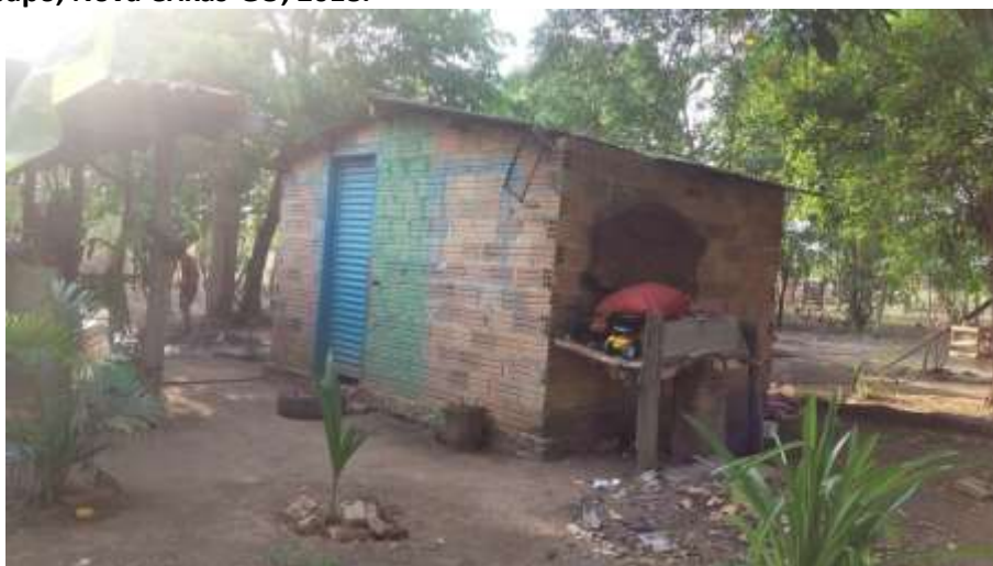
Foto 4.12 – Extensão habitacional com cobertura de fibrocimento, identificada na Comunidade Lagoa Genipapo, Nova Crixás-GO, 2018.
