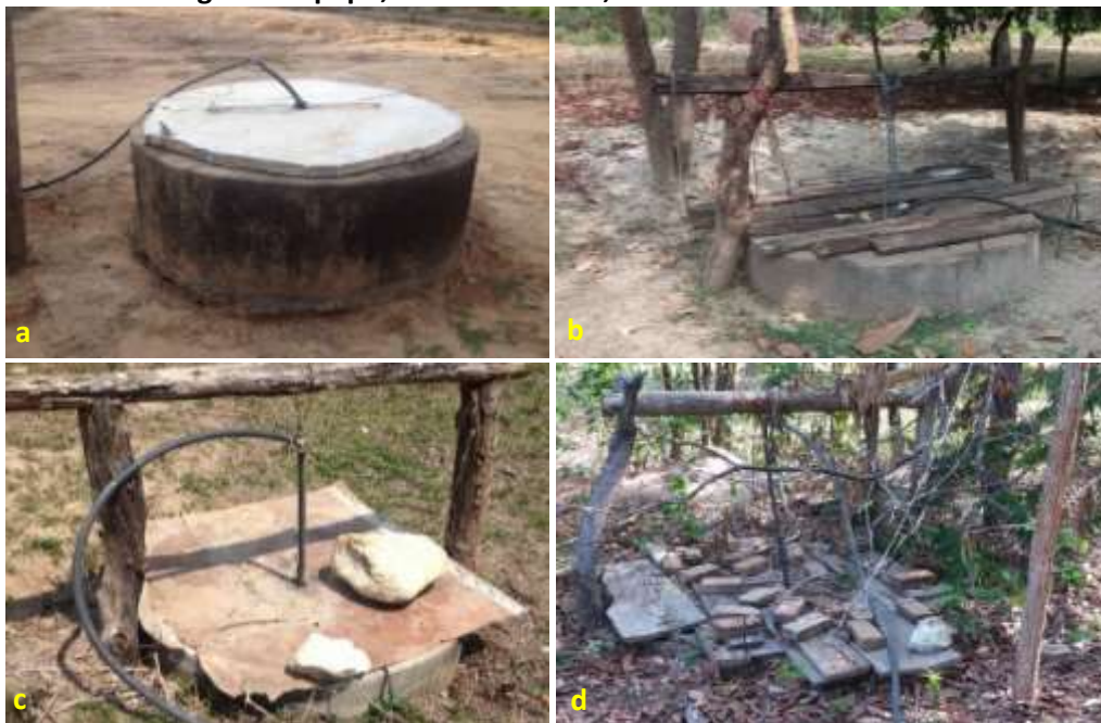
Foto 6.2 – Diferentes formas de tampas observadas nos poços rasos escavados: com tampa de concreto (a), com tábuas de madeira (b), com chapa metálica (c) e com tábuas de madeira e tijolos (d), na Comunidade Lagoa Genipapo, Nova Crixás-GO, 2018.
