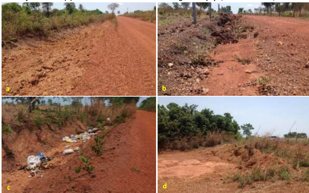
Foto 6.13 – Valeta (a), valeta obstruída (b), ponto de descarte de resíduos sólidos na valeta (c) e ponto de extração de terra (d) na via de acesso à Comunidade Lagoa Genipapo, Nova Crixás-GO, 2018.
