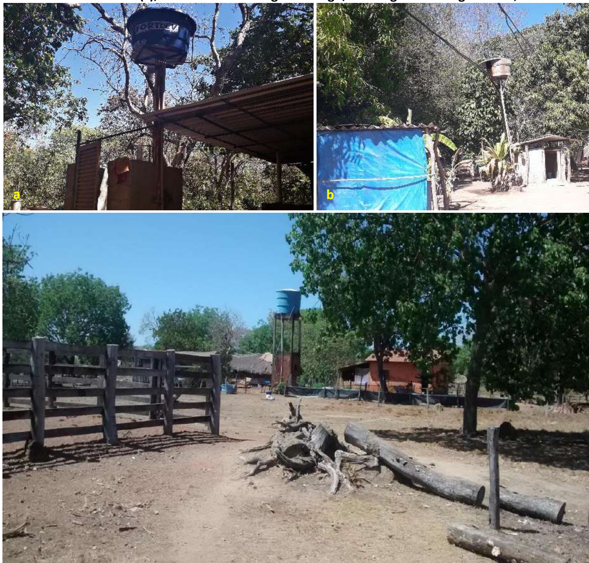
Foto 6.5 – Reservatório domiciliar instalado sobre estrutura metálica (a), madeira (b) e outro sobre estrutura em concreto (c), na Comunidade Lagoa do Lago, São Miguel do Araguaia-GO, 2019.
