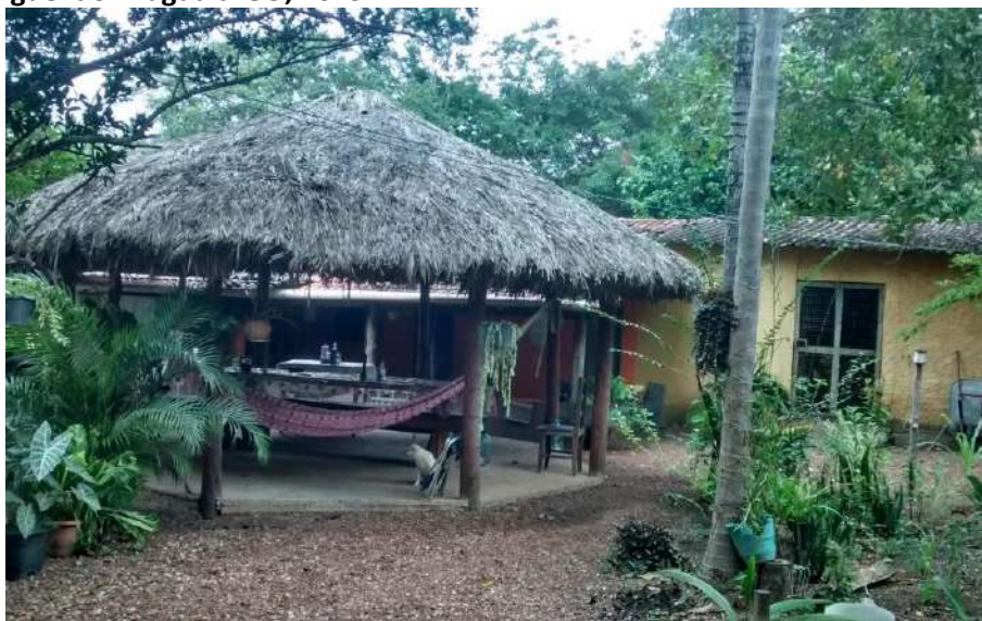
Foto 4.6 – Piso de residência constituído de concreto bruto, identificado na Comunidade Lagoa do Lago, São Miguel do Araguaia-GO, 2019.
