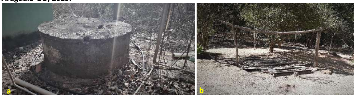
Foto 6.4 – Poços rasos escavados desativados na Comunidade Lagoa do Lago, São Miguel do Araguaia-GO, 2019.
