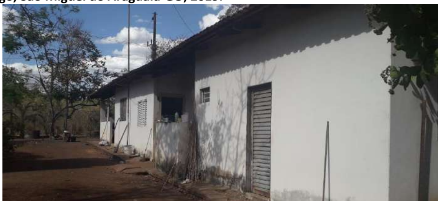
Foto 4.4 – Habitação construída de alvenaria com reboco e pintura, identificada na Comunidade Lagoa do Lago, São Miguel do Araguaia-GO, 2019.
