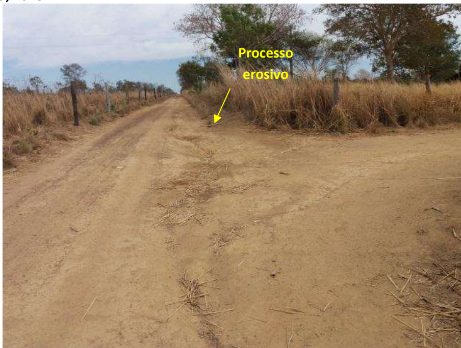
Foto 6.23 – Exemplo de processos erosivos em lote da Comunidade Lageado, São Miguel do Araguaia-GO, 2018.
