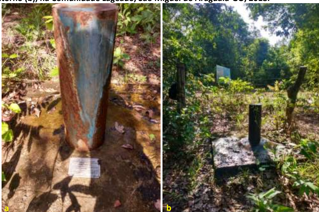
Foto 6.2 – Poço tubular profundo inativo (a), cercado com cerca e com calçamento de concreto no seu contorno (b), na Comunidade Lageado, São Miguel do Araguaia-GO, 2018.
