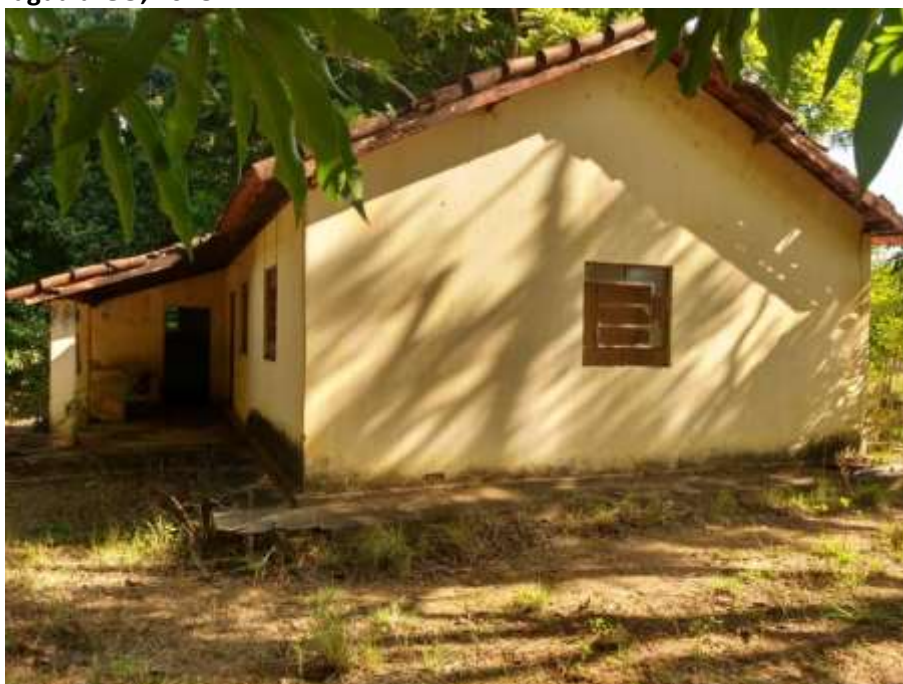
Foto 4.1 – Escola pública desativada identificada durante o checklist da Comunidade Lageado, São Miguel do Araguaia-GO, 2018.
