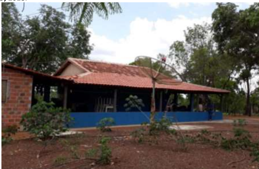
Foto 4.9 – Cobertura de telha de barro, identificada na Comunidade Lageado, São Miguel do Araguaia-GO, 2018.
