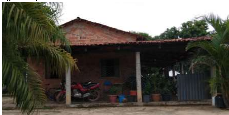
Foto 4.4 – Habitação construída de alvenaria sem reboco, identificada na Comunidade Lageado, São Miguel do Araguaia-GO, 2018.
