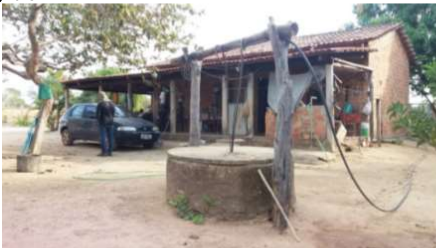
Foto 6.1 – Poço raso escavado utilizado em um domicílio da Comunidade Lageado, São Miguel do Araguaia-GO, 2018.
