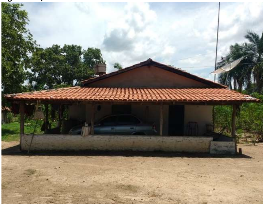
Foto 4.5 – Habitação construída de alvenaria com reboco, identificada na Comunidade Lageado, São Miguel do Araguaia-GO, 2018.
