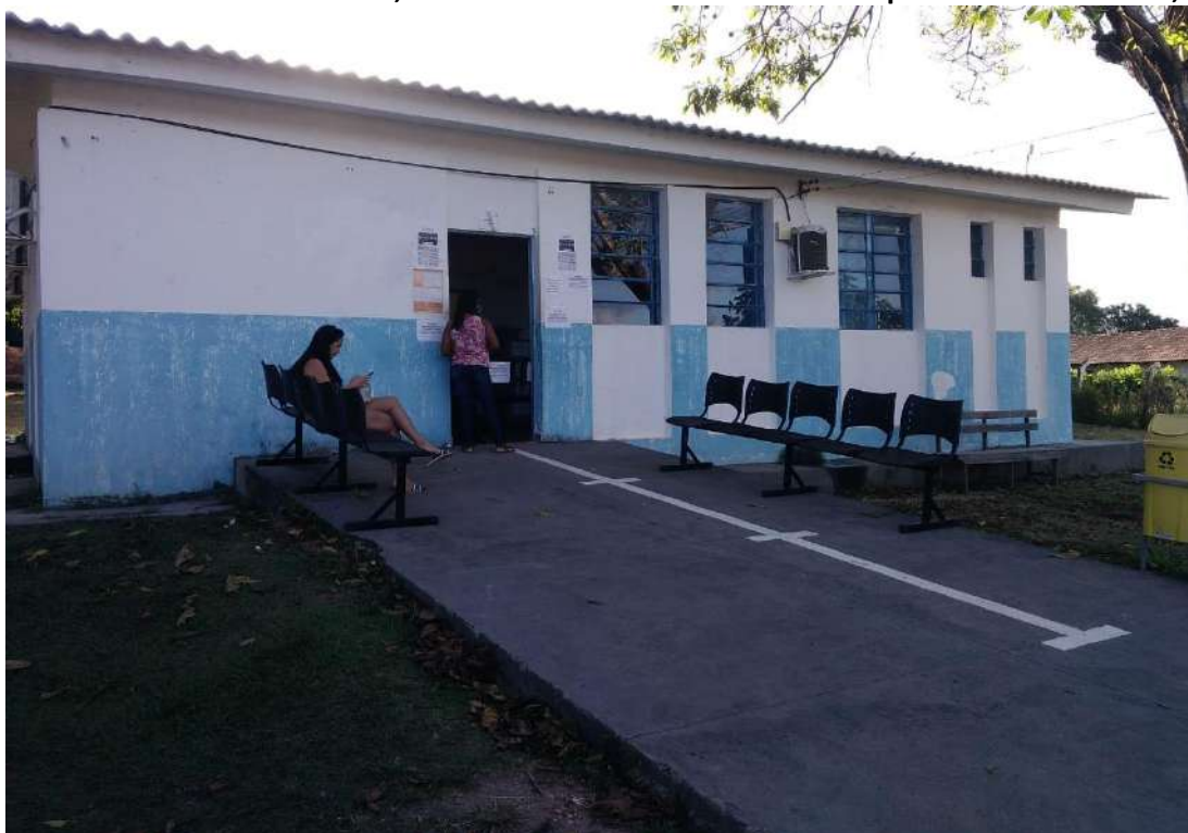
Foto 5.2 – Vista externa da UBSF II, localizada na zona urbana do município de Cavalcante-GO, 2020.
