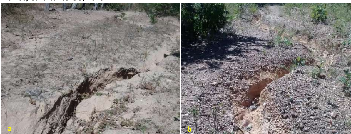
Foto 6.18 – Processos erosivos nas margens da via de acesso (a) e (b) à Comunidade Kalunga dos Morros, Cavalcante-GO, 2019.
