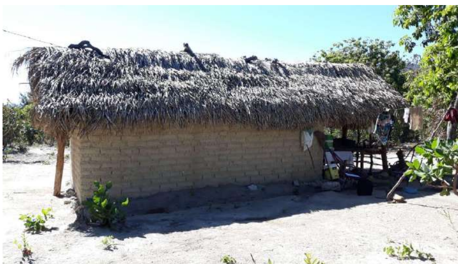
Foto 4.14 – Cobertura de palha, identificada na Comunidade Kalunga dos Morros, Cavalcante-GO, 2019.
