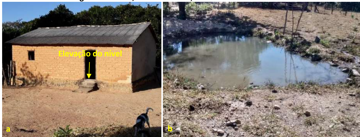
Foto 6.23 – Dispositivos de prevenção dos danos provocados pelas águas em residência (a) e lote (b) da Comunidade Kalunga dos Morros, Cavalcante-GO, 2019.
