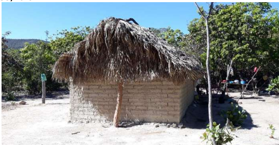
Foto 4.9 – Habitação construída de adobe, identificada na Comunidade Kalunga dos Morros, Cavalcante-GO, 2019.
