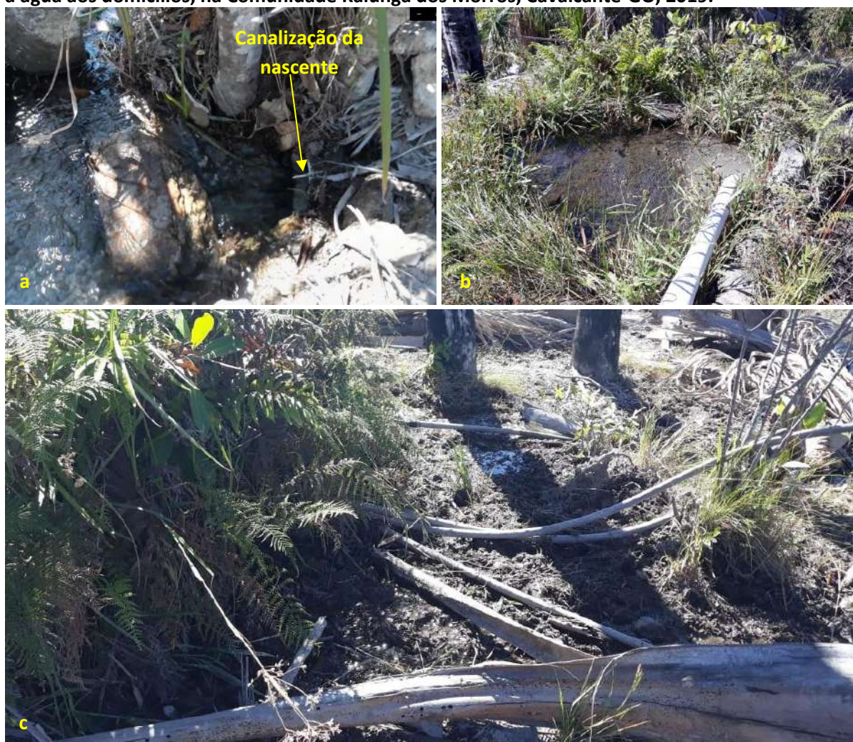
Foto 6.3 – Canalização da nascente (a) para a barraginha (b) e mangueiras instaladas para direcionar a água aos domicílios, na Comunidade Kalunga dos Morros, Cavalcante-GO, 2019.
