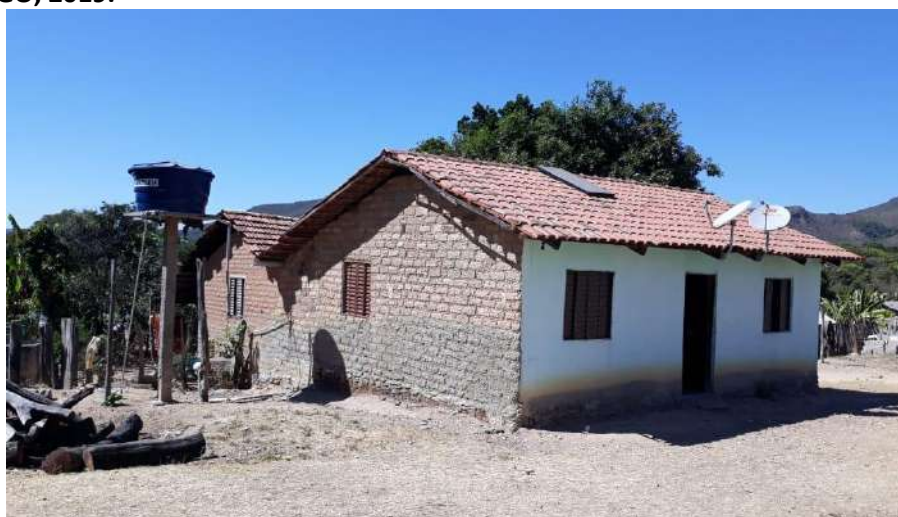
Foto 4.12 – Cobertura de telha de barro, identificada na Comunidade Kalunga dos Morros, Cavalcante-GO, 2019.
