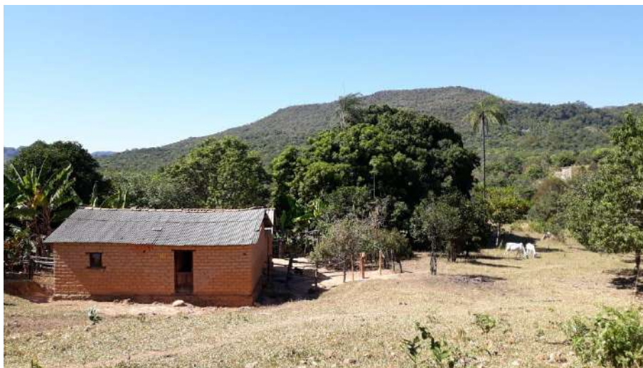
Foto 4.13 – Cobertura de fibrocimento identificada na Comunidade Kalunga dos Morros, Cavalcante-GO, 2019.
