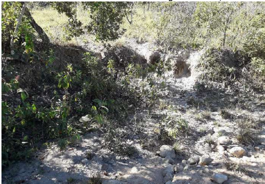
Foto 6.24 – Processo erosivo em lote da Comunidade Kalunga dos Morros, Cavalcante-GO, 2019.
