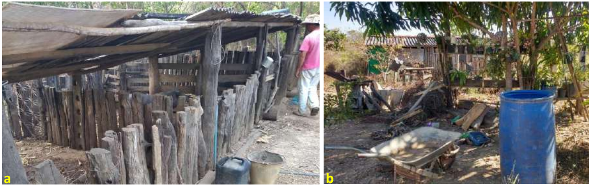
Foto 2.4 – Verificação das estruturas de confinamento de suínos no lote, juntamente com o morador (a), e verificação da casa e do quintal (b), conforme Formulário II, durante o Momento 2, na Comunidade Julião Ribeiro, Niquelândia-GO, 2018.
