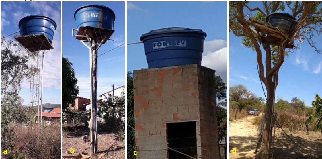
Foto 6.8 – Diferentes condições dos reservatórios domiciliares de polietileno, instalados sobre: estrutura metálica (a), com sinais de transbordamento; estrutura de madeira (b); estrutura de alvenaria (c), e outro sobre uma árvore na Comunidade Julião Ribeiro, Niquelândia-GO, 2018.
