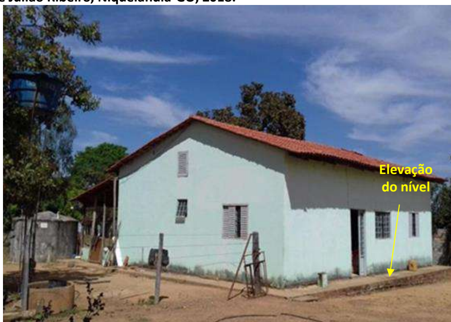
Foto 6.24 – Dispositivo de prevenção dos danos provocados pelas águas em residência da Comunidade Julião Ribeiro, Niquelândia-GO, 2018.
