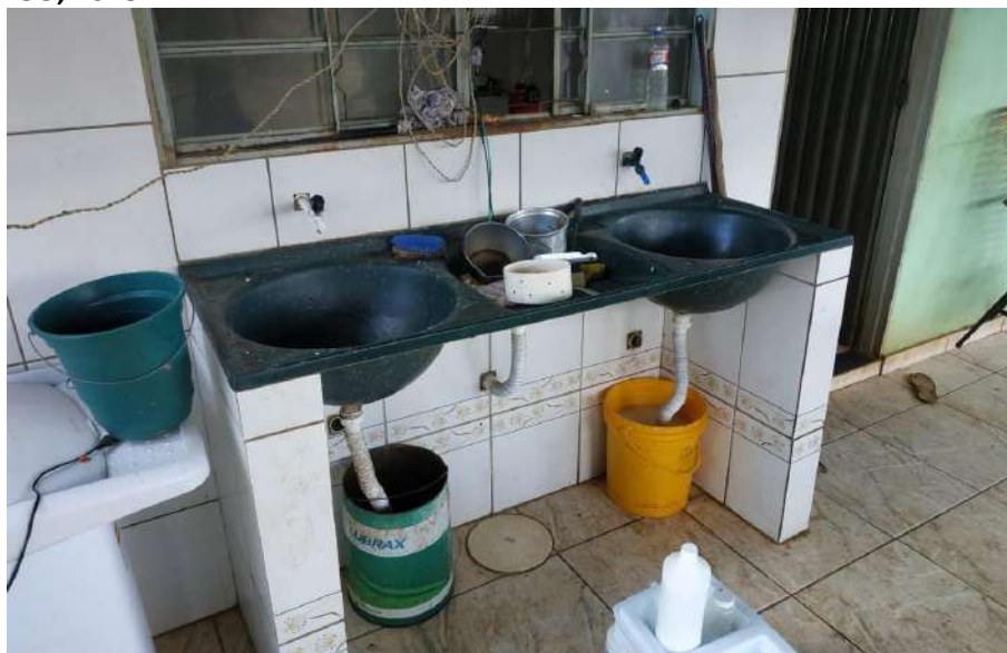
Foto 4.2 – Piso de residência constituído cerâmica, identificado na Comunidade Julião Ribeiro, Niquelândia-GO, 2018.
