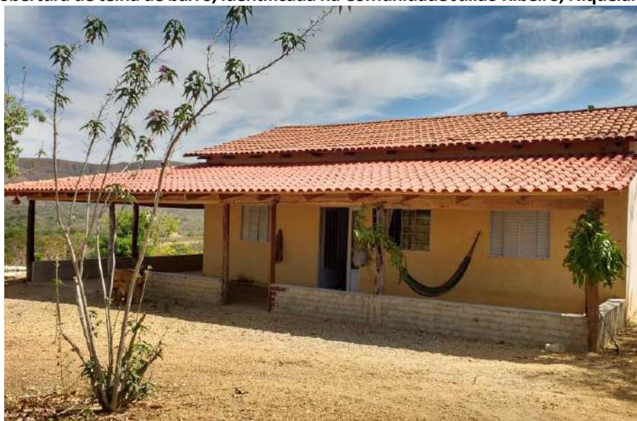
Foto 4.3 – Cobertura de telha de barro, identificada na Comunidade Julião Ribeiro, Niquelândia-GO, 2018.
