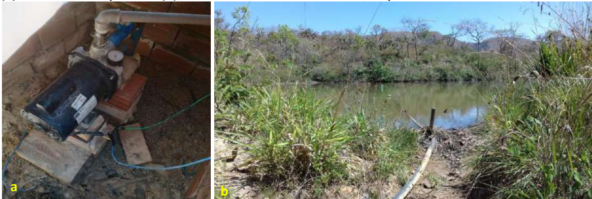
Foto 6.2 – Diferentes tipos de SAI utilizados para obtenção de água para ingestão: poço tubular raso (a) e manancial superficial (b), na Comunidade Julião Ribeiro, Niquelândia-GO, 2018.
