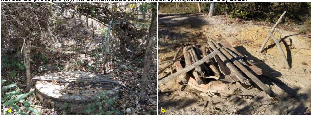
Foto 6.3 – Diferentes aspectos construtivos dos poços escavados: com tampa de concreto, mureta de proteção (a) e com tampa feita em material improvisado (madeira e folha metálica), pequena mureta de proteção (b), na Comunidade Julião Ribeiro, Niquelândia-GO, 2018.
