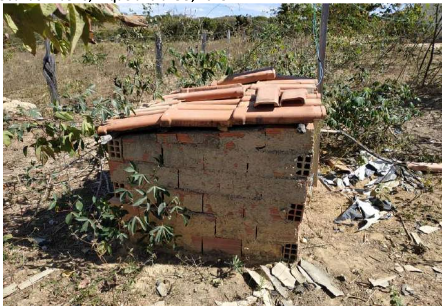
Foto 6.4 – Poço tubular raso protegido por estrutura de alvenaria e telhado cerâmico, na Comunidade Julião Ribeiro, Niquelândia-GO, 2018.
