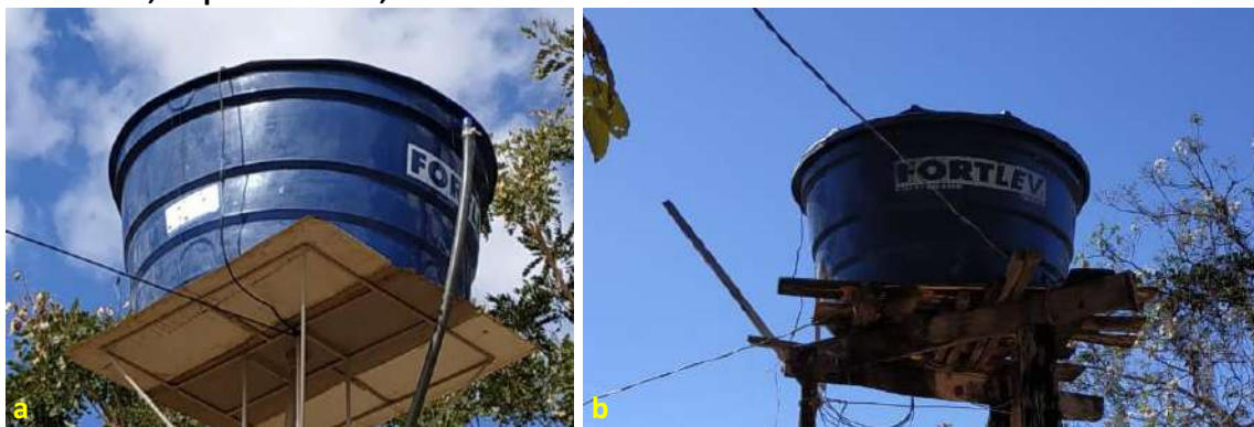
Foto 6.6 – Diferentes situações dos reservatórios domiciliares: reservatório de polietileno com tampa amarrada com arame (a), e outro com tampa amarrada com pedaço de fio (b), na Comunidade Julião Ribeiro, Niquelândia-GO, 2018.
