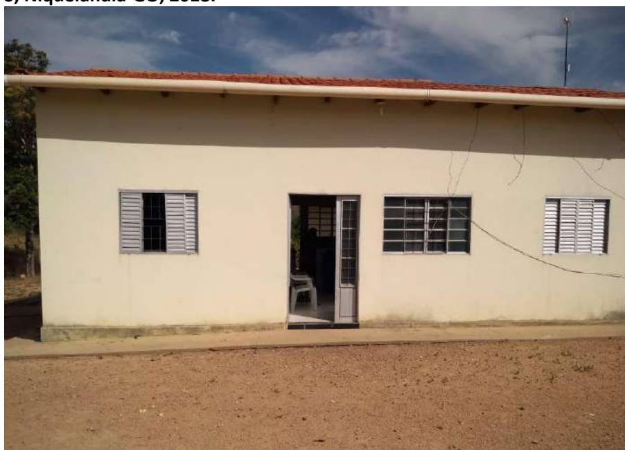
Foto 4.1 – Habitação construída de alvenaria com reboco e pintura, identificada na Comunidade Julião Ribeiro, Niquelândia-GO, 2018.
