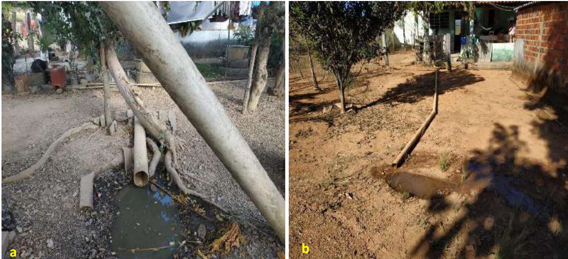
Foto 6.11 – Lançamento e acúmulo de água cinza proveniente da pia da cozinha diretamente no solo do quintal próximo aos domicílios (a) e (b), na Comunidade Julião Ribeiro, Niquelândia-GO, 2018.
