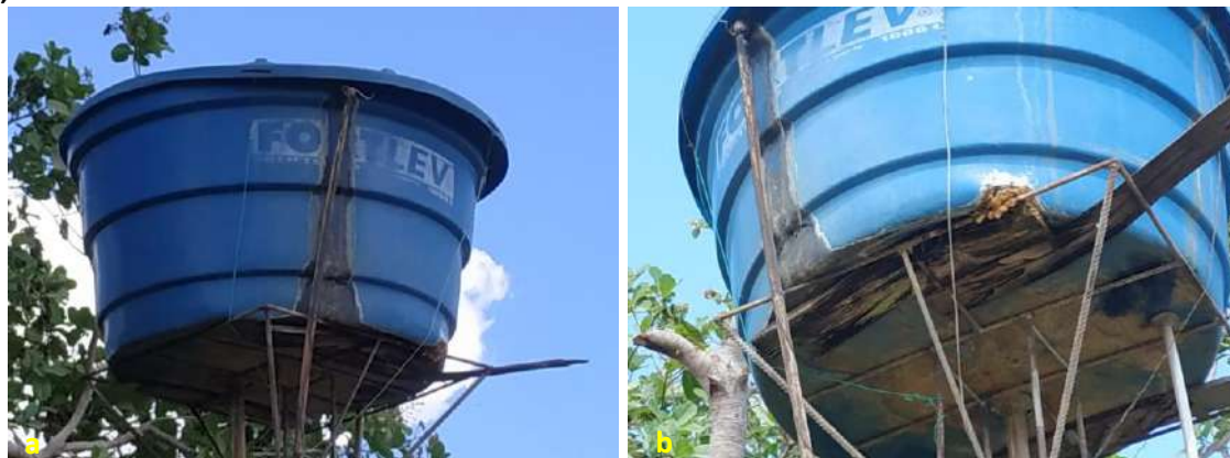
Foto 6.7 – Diferentes condições dos reservatórios domiciliares: reservatório de polietileno com sinal de transbordamento (a) e com trinca em sua base (b), na Comunidade Julião Ribeiro, Niquelândia-GO, 2018.
