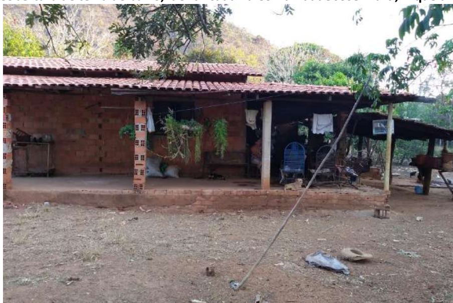
Foto 4.11 – Cobertura de telha de barro, identificada na Comunidade José Martí, Niquelândia-GO, 2018.
