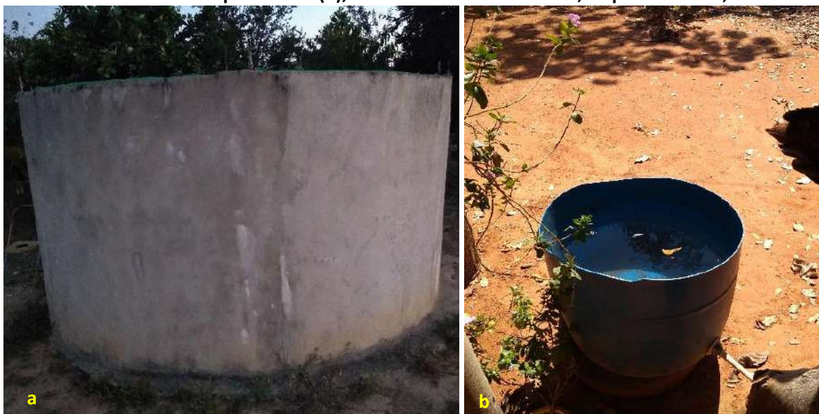
Foto 6.6 – Cisterna em concreto utilizada para armazenar água proveniente da chuva (a) e outra em parte de uma bombona de polietileno (b), na Comunidade José Martí, Niquelândia-GO, 2018.
