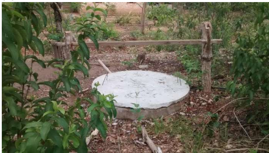
Foto 6.1 – Poço raso escavado utilizado por um domicílio da Comunidade de José do Coletto, Colinas do Sul-GO, 2019.
