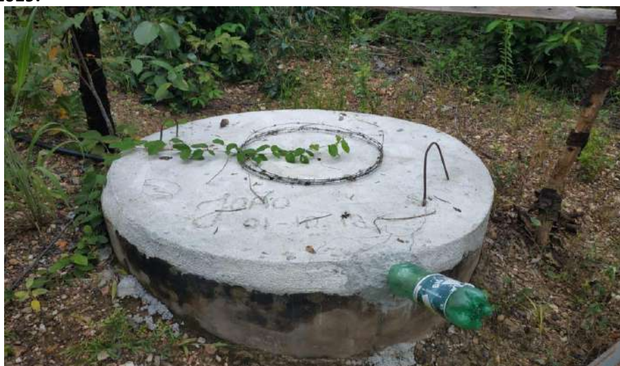
Foto 6.4 – Poço raso escavado utilizado em um domicílio da Comunidade de José do Coletto, Colinas do Sul-GO, 2019.
