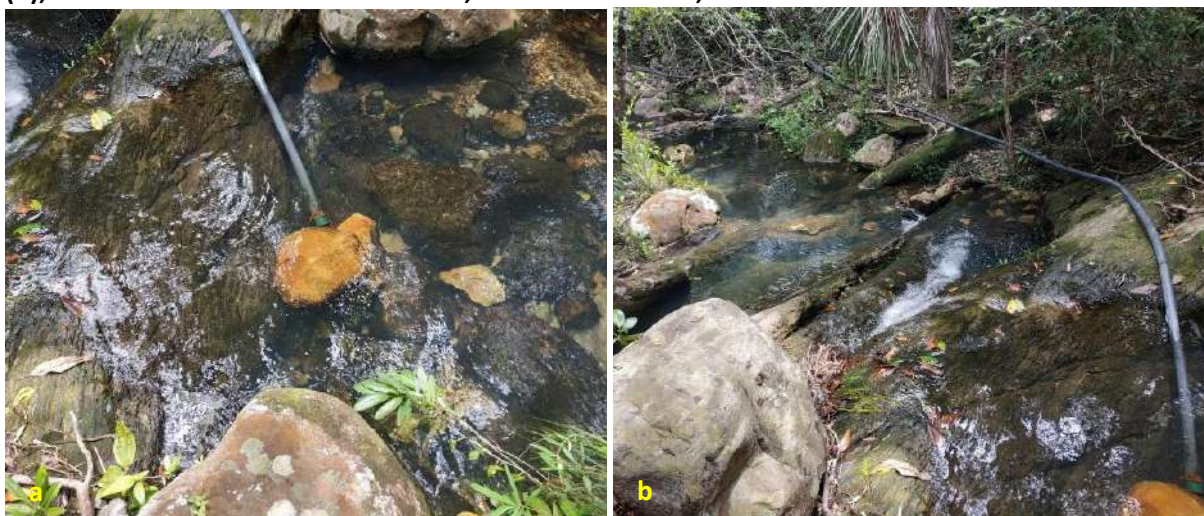
Foto 6.2 – Captação de água do SAA (F1) realizada na nascente (a) por meio de uma tubulação flexível (b), na Comunidade de José do Coletto, Colinas do Sul-GO, 2019.
