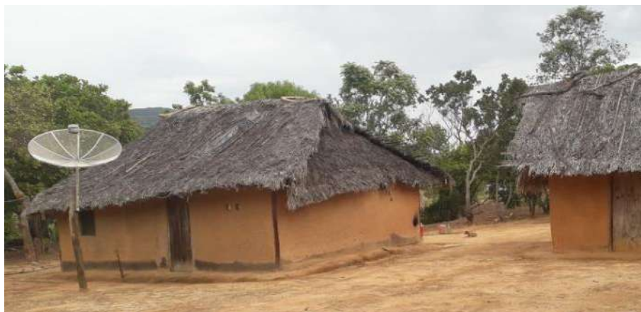
Foto 4.6 – Cobertura de palha, identificada na Comunidade de José de Coletto, Colinas do Sul-GO, 2019.
