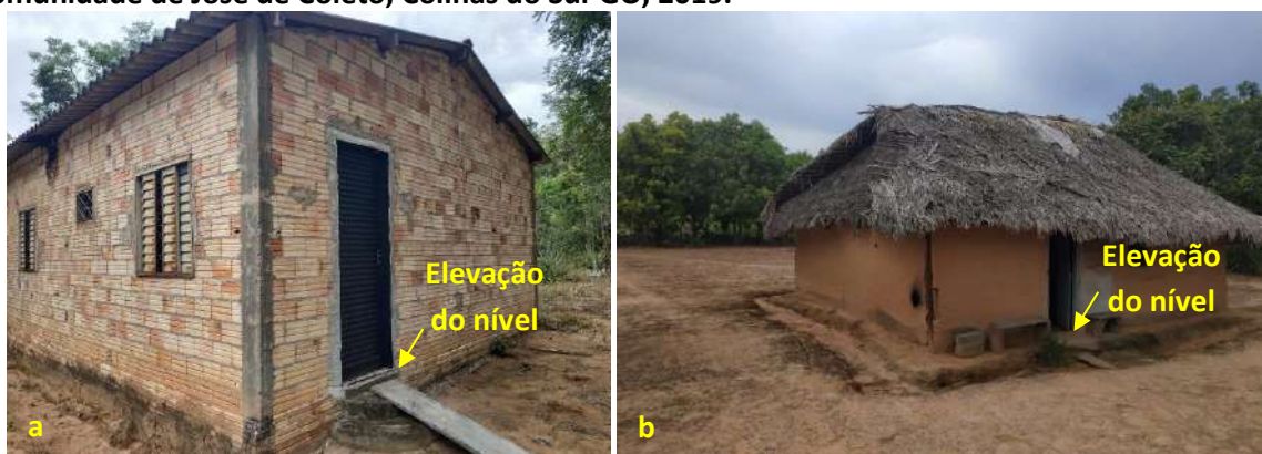
Foto 6.19 – Dispositivos de prevenção dos danos provocados pelas águas em residências da Comunidade de José de Coletto, Colinas do Sul-GO, 2019.
