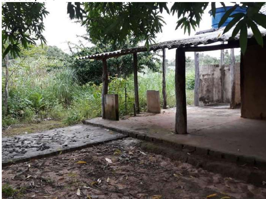
Foto 4.4 – Piso de residência constituído de concreto bruto, identificado na Comunidade de José de Coletto, Colinas do Sul, 2019.
