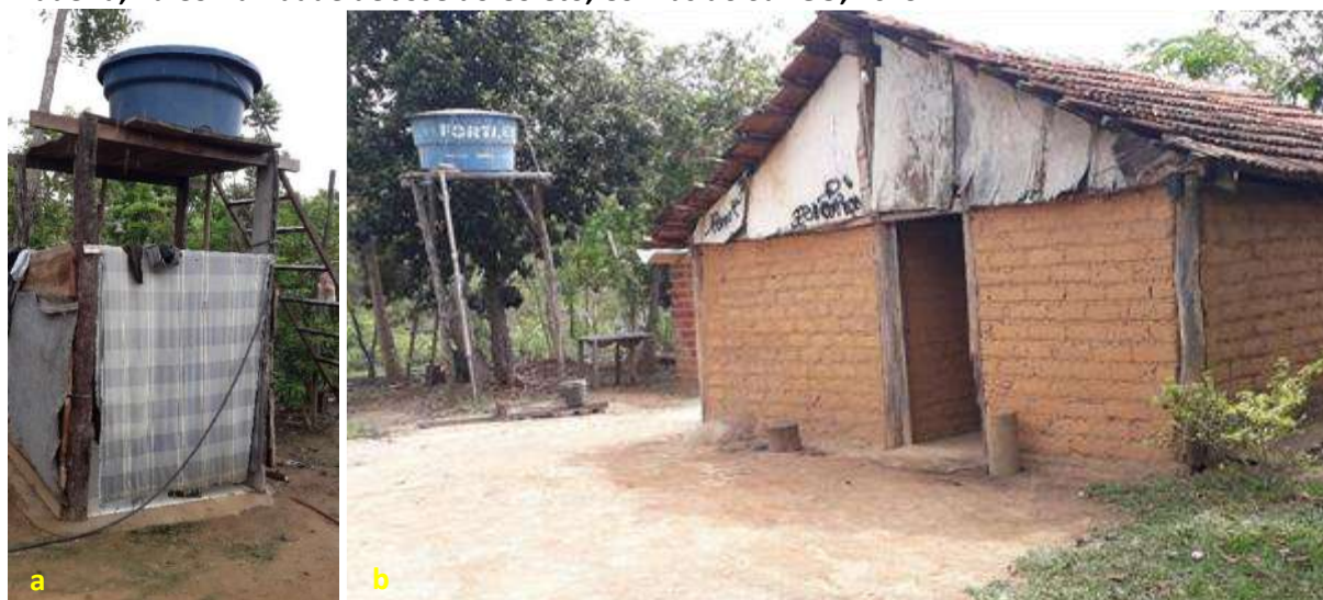
Foto 6.6 – Reservatórios em polietileno (a) e em fibra de vidro (b), instalados sobre estruturas de madeira, na Comunidade de José do Coletto, Colinas do Sul-GO, 2019.
