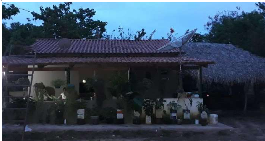
Foto 4.7 – Cobertura de telha de barro, identificada na Comunidade de José de Coletto, Colinas do Sul-GO, 2019.
