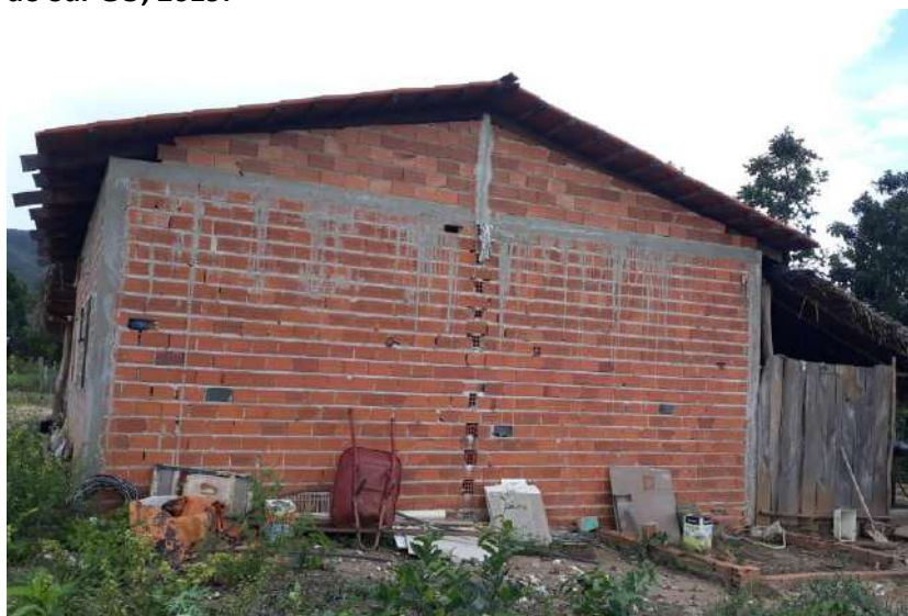
Foto 4.3 – Habitação construída de alvenaria sem reboco, identificada na Comunidade de José de Coletto, Colinas do Sul-GO, 2019.
