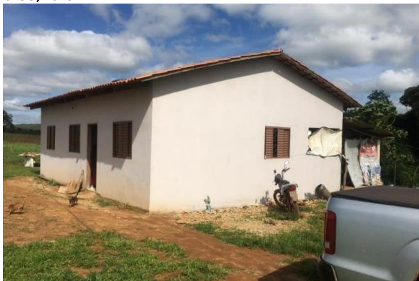
Foto 4.2 – Habitação construída de alvenaria com reboco e pintura, identificada na Comunidade João de Deus, Silvânia-GO, 2018.
