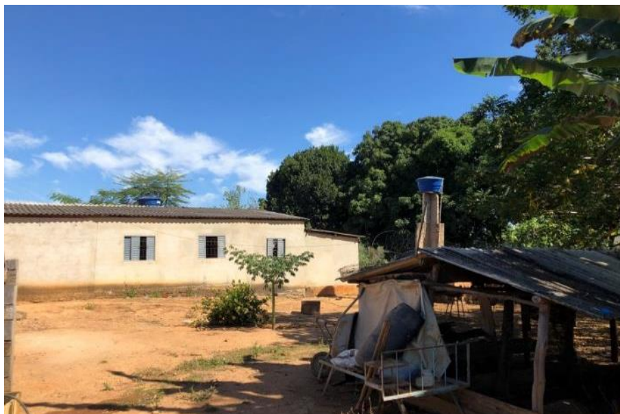
Foto 4.6 – Cobertura do tipo fibrocimento, identificada na Comunidade João de Deus, Silvânia-GO, 2018.
