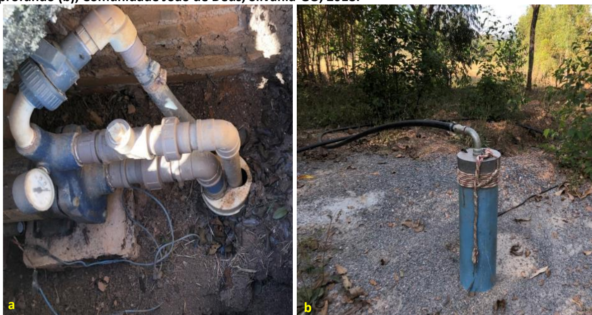
Foto 6.1 – Diferentes fontes de abastecimento de água: poço tubular raso (a) e poço tubular profundo (b), Comunidade João de Deus, Silvânia-GO, 2018.
