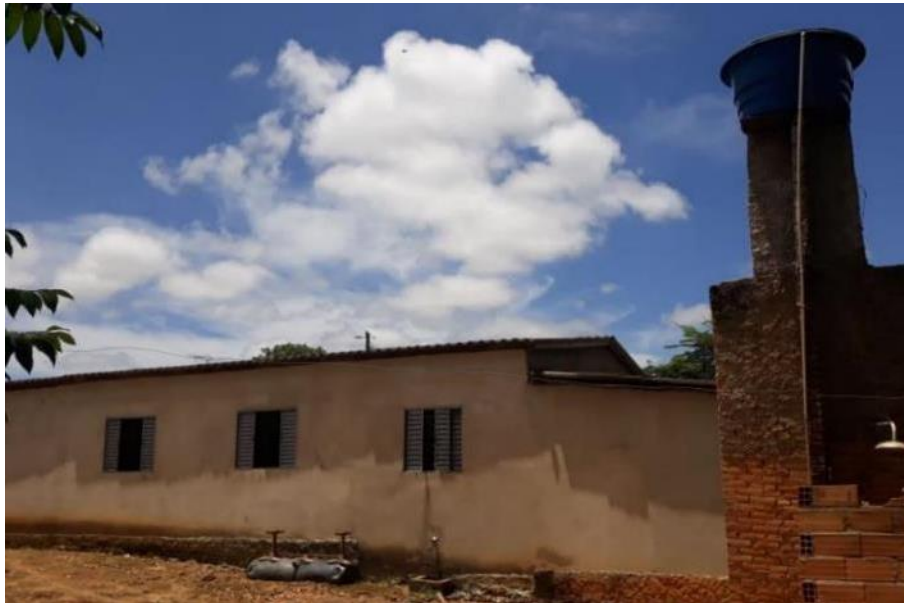
Foto 4.1 – Habitação construída de alvenaria com reboco, identificada na Comunidade João de Deus, Silvânia-GO, 2018.
