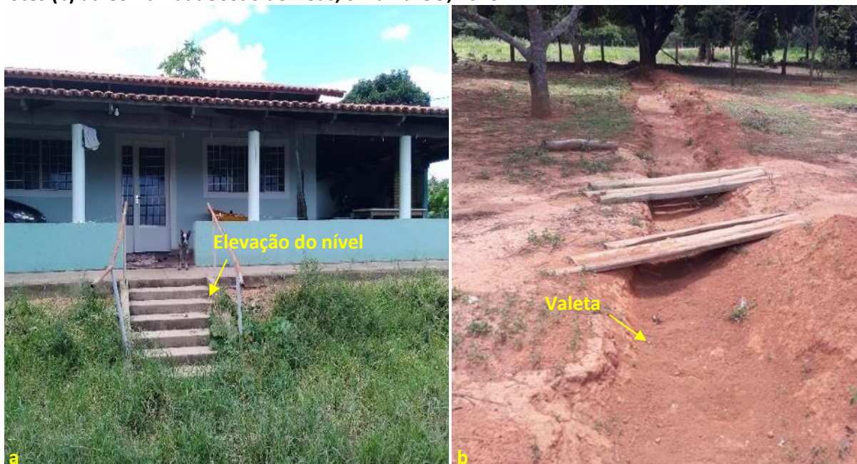
Foto 6.21 – Dispositivos de prevenção dos danos provocados pelas águas nas residências (a) e nos lotes (b) da Comunidade João de Deus, Silvânia-GO, 2018.
