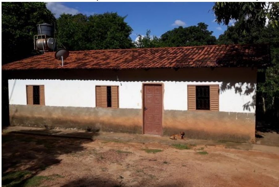
Foto 4.5 – Cobertura de telha de barro, identificada na Comunidade João de Deus, Silvânia-GO, 2018.
