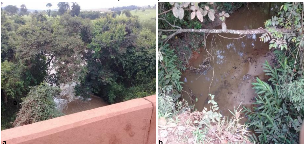
Foto 6.18 – Córrego Cangalha (a) e córrego do Açude (b), ambos intermitentes, atravessando a via de acesso à Comunidade João de Deus, Silvânia-GO, 2018.
