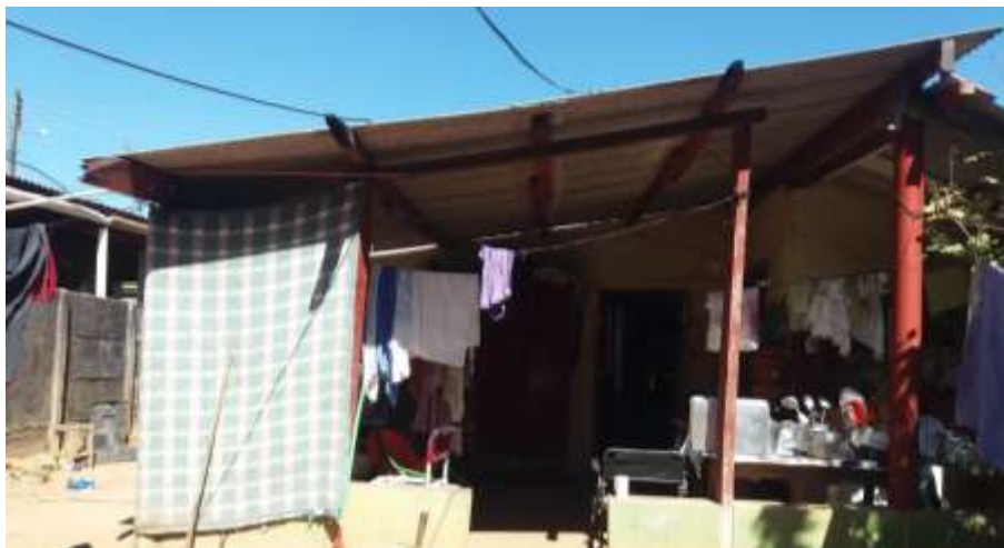
Foto 4.7 – Cobertura de fibrocimento, identificada na Comunidade Urbana João Borges Vieira, Uruaçu-GO, 2019.
