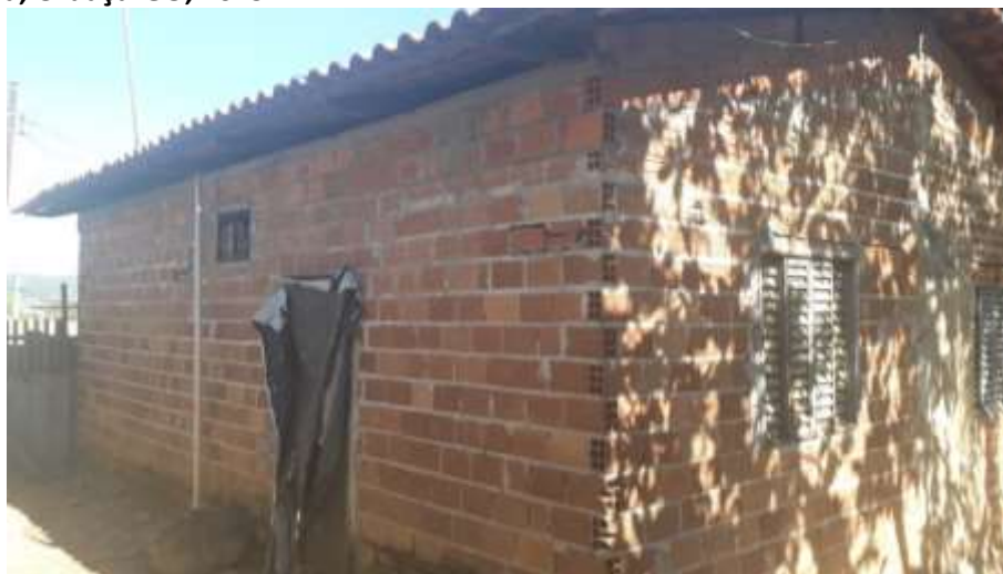
Foto 4.3 – Habitação construída de alvenaria sem reboco, identificada na Comunidade Urbana João Borges Vieira, Uruaçu-GO, 2019.
