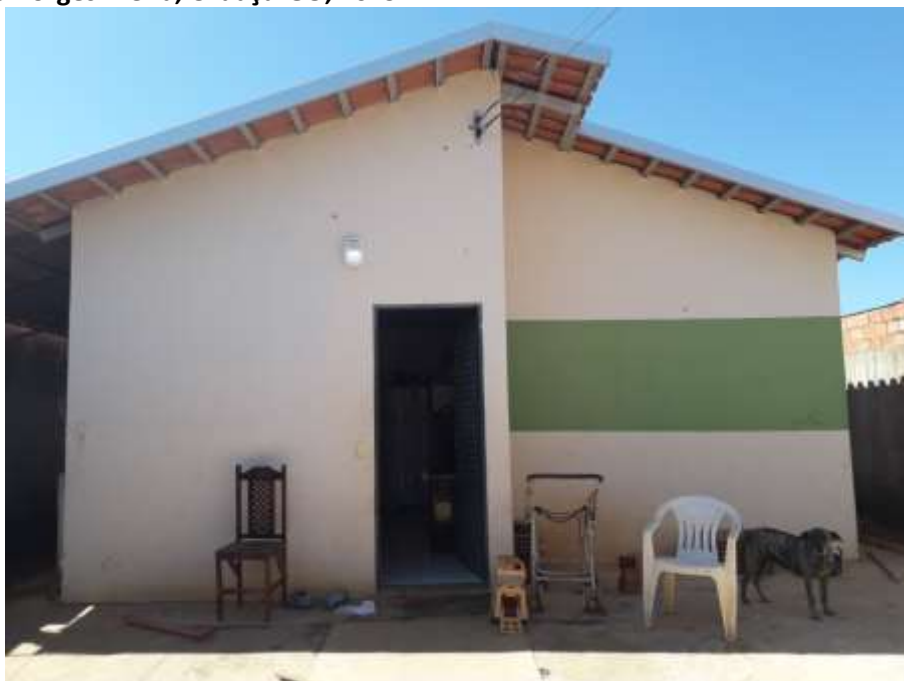
Foto 4.1 – Habitação construída de alvenaria com reboco e pintura, identificada na Comunidade Urbana João Borges Vieira, Uruaçu-GO, 2019.
