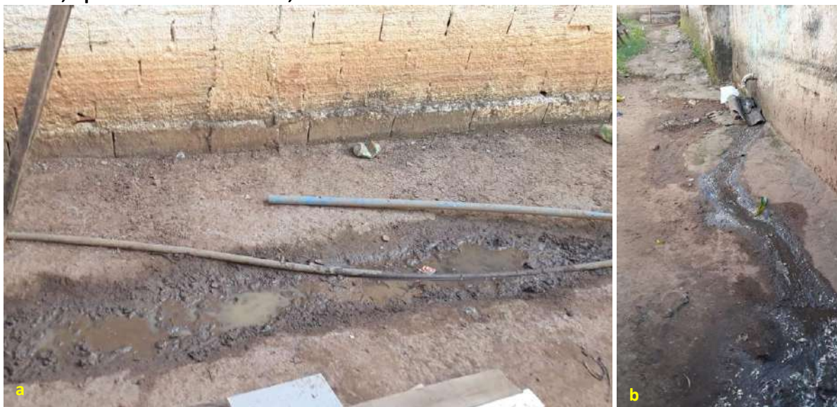
Foto 6.6 – Lançamento e acúmulo de água cinza proveniente da pia da cozinha e/ou lavagem de roupas diretamente no solo do quintal próximo aos domicílios (a) e (b), na Comunidade de Jardim Cascata, Aparecida de Goiânia-GO, 2019.
