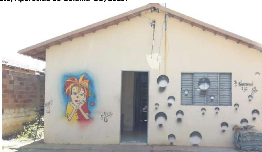
Foto 4.3 – Habitação construída de alvenaria com reboco e pintura, identificada na Comunidade de Jardim Cascata, Aparecida de Goiânia-GO, 2019.
