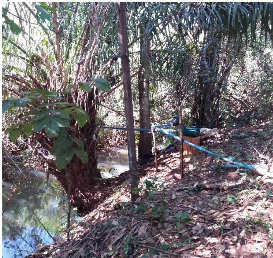
Foto 6.5 – Captação de água sendo realizada em uma manancial superficial, na Comunidade Itajá II, Goianésia-GO, 2018.
