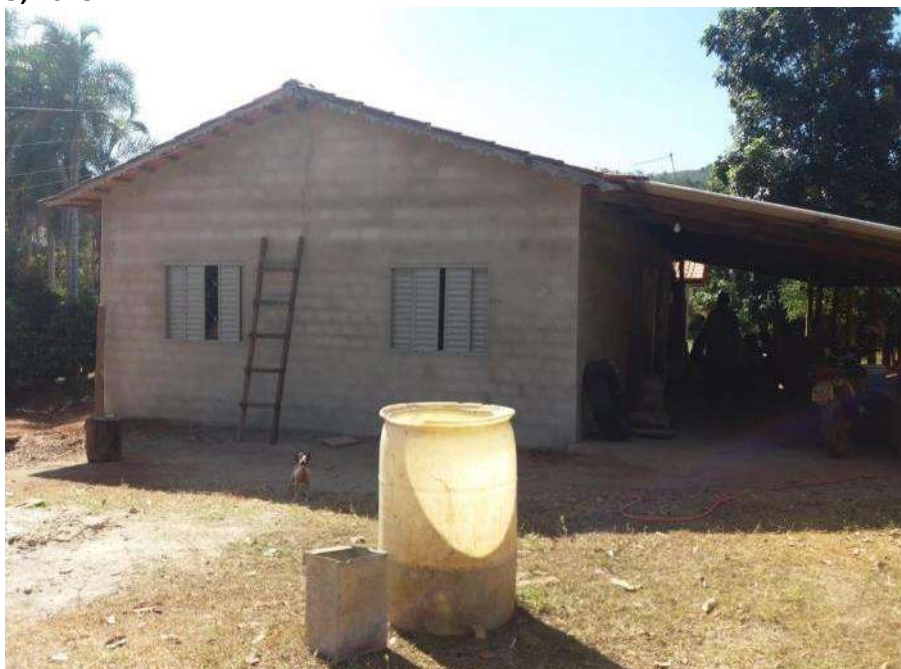
Foto 4.2 – Habitação construída de alvenaria com reboco, identificada na Comunidade Itajá II, Goianésia-GO, 2018.
