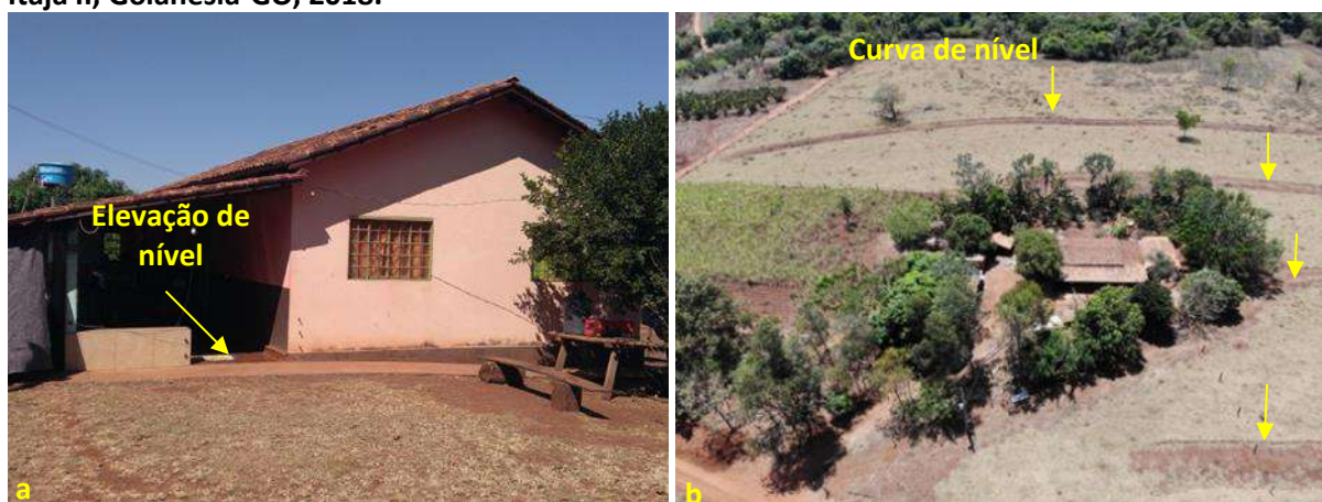
Foto 6.20 – Dispositivos de prevenção dos danos provocados pelas águas (a) e (b), na Comunidade Itajá II, Goianésia-GO, 2018.
