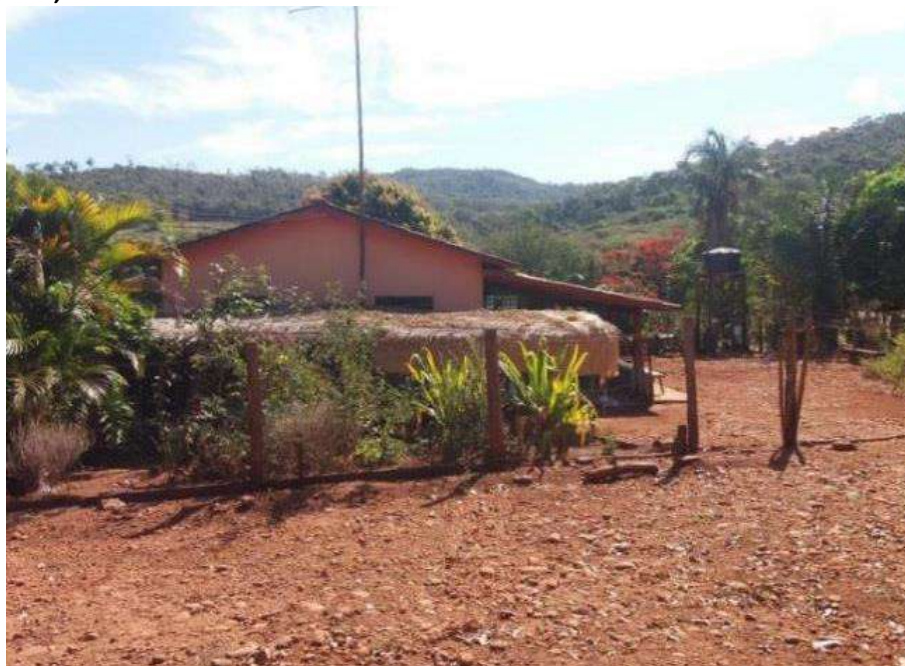
Foto 4.4 – Habitação construída de alvenaria com reboco e pintura, identificada na Comunidade Itajá II, Goianésia-GO, 2018.
