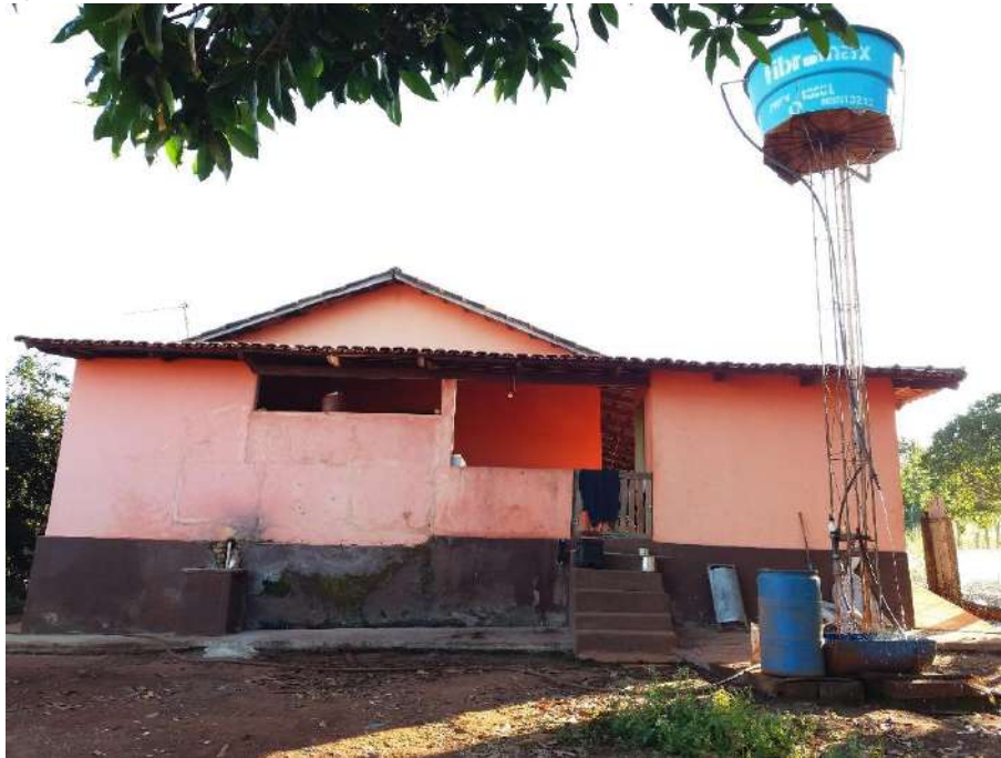
Foto 6.6 – Reservatório domiciliar de fibra de vidro com extravasor, na Comunidade Itajá II, Goianésia-GO, 2018.
