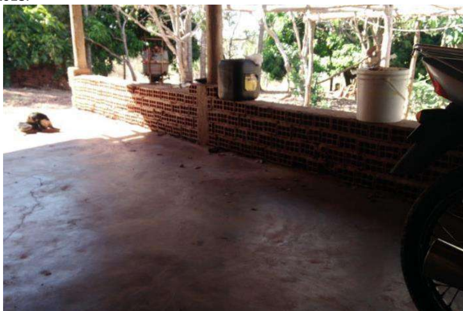
Foto 4.5 – Piso de residência constituído de cimento queimado, identificado na Comunidade Itajá II, Goianésia, 2018.
