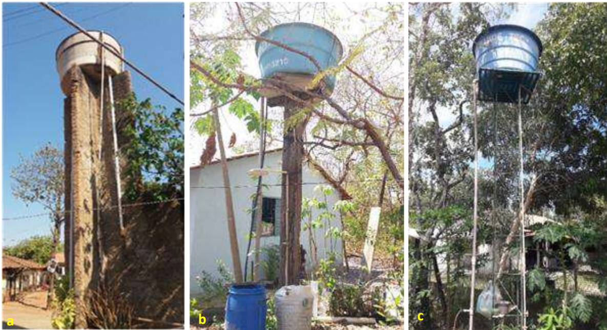
Foto 6.4 – Reservatório de fibrocimento instalado sobre uma estrutura de alvenaria (a), reservatório de fibra de vidro sobre uma estrutura em madeira (b), e outro sobre uma estrutura metálica (c), na Comunidade Itacaiú, Britânia-GO, 2018.
