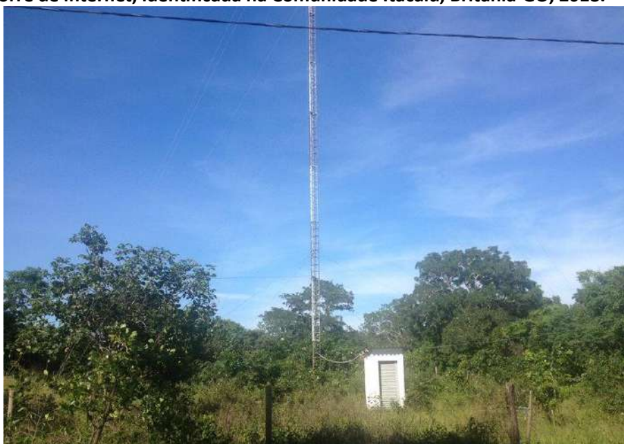
Foto 4.8 – Torre de internet, identificada na Comunidade Itacaiú, Britânia-GO, 2018.
