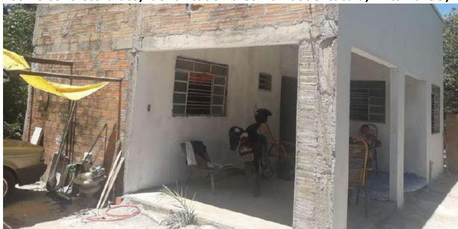
Foto 4.12 – Piso no concreto bruto, identificado na Comunidade Itacaiú, Britânia-GO, 2018.
