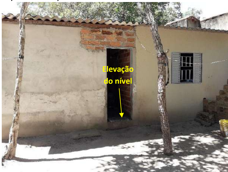
Foto 6.18 – Dispositivo de prevenção dos danos provocados pelas águas em residência da Comunidade Itacaiú, Britânia-GO, 2018.
