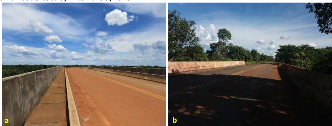
Foto 6.13 – Ponte sobre o rio Araguaia (a) e ponte sobre o rio São João (b), na via de acesso à Comunidade Itacaiú, Britânia-GO, 2018.
