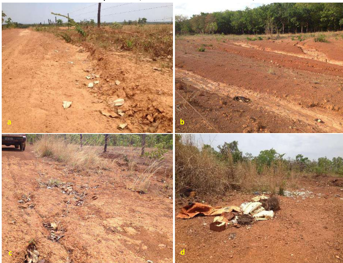
Foto 6.19 – Valeta de infiltração (a), processos erosivos na margem da via pavimentada (b), processos erosivos na via sem pavimentação (c) e ponto de descarte de resíduos sólidos (d) na via de acesso à Comunidade Independência, Santa Rita do Novo Destino-GO, 2018.
