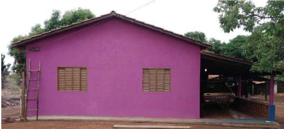
Foto 4.4 – Habitação construída de alvenaria com reboco e pintura, identificada na Comunidade Independência, Santa Rita do Novo Destino-GO, 2018.
