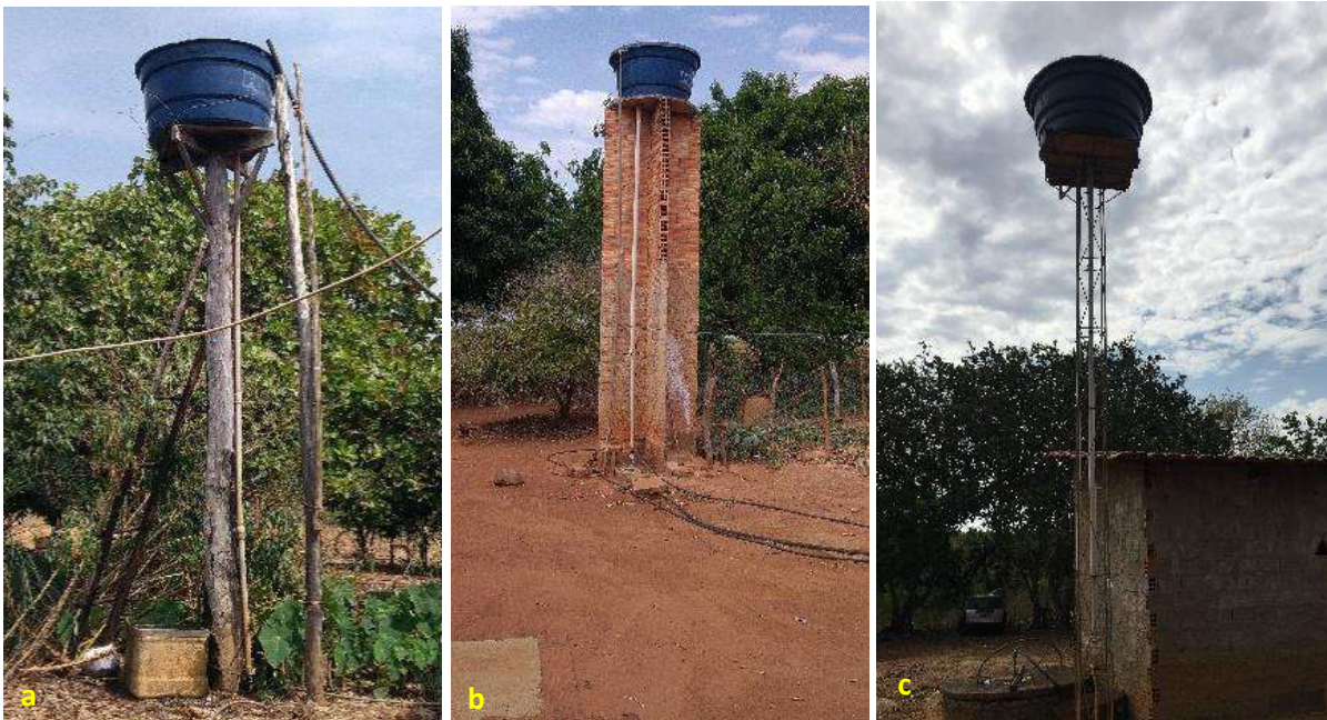
Foto 6.7 – Reservatórios domiciliares instalados sobre estrutura: em madeira (a), em alvenaria (b) e em estrutura metálica (c), na Comunidade Independência, Santa Rita do Novo Destino-GO, 2018.
