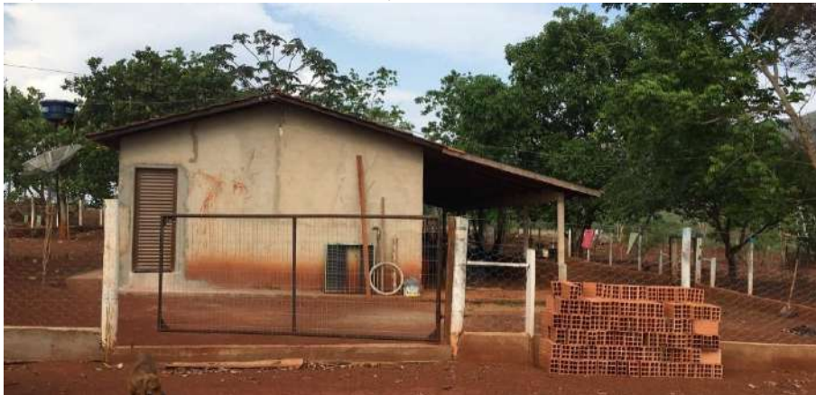
Foto 4.5 – Habitação construída de alvenaria com reboco sem pintura, identificada na Comunidade Independência, Santa Rita do Novo Destino-GO, 2018.
