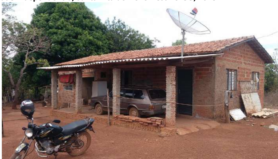
Foto 4.11 – Habitação com cobertura de fibrocimento em associação com telha de barro, identificada na Comunidade Independência, Santa Rita do Novo Destino-GO, 2018.
