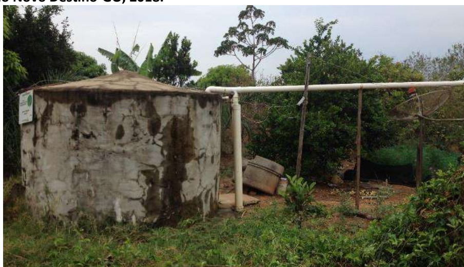
Foto 6.6 – Cisterna desativada utilizada como reservatório de água, na Comunidade Independência, Santa Rita do Novo Destino-GO, 2018.
