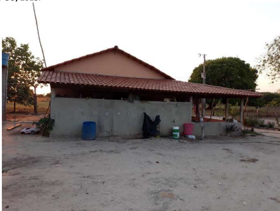
Foto 4.10 – Cobertura de telha de barro, identificada na Comunidade Gustavo Martins, São Miguel do Araguaia-GO, 2018.
