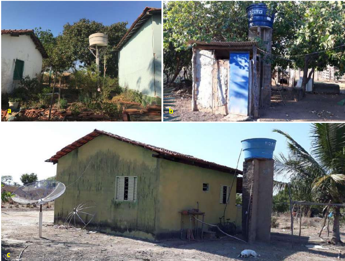
Foto 6.6 – Reservatório em fibrocimento sobre estrutura de madeira (a), reservatório em polietileno instalado sobre estrutura de alvenaria (b) e reservatório em vibra de vidro instalado sobre estrutura de alvenaria (c), Comunidade Gustavo Martins, São Miguel do Araguaia-GO, 2018.
