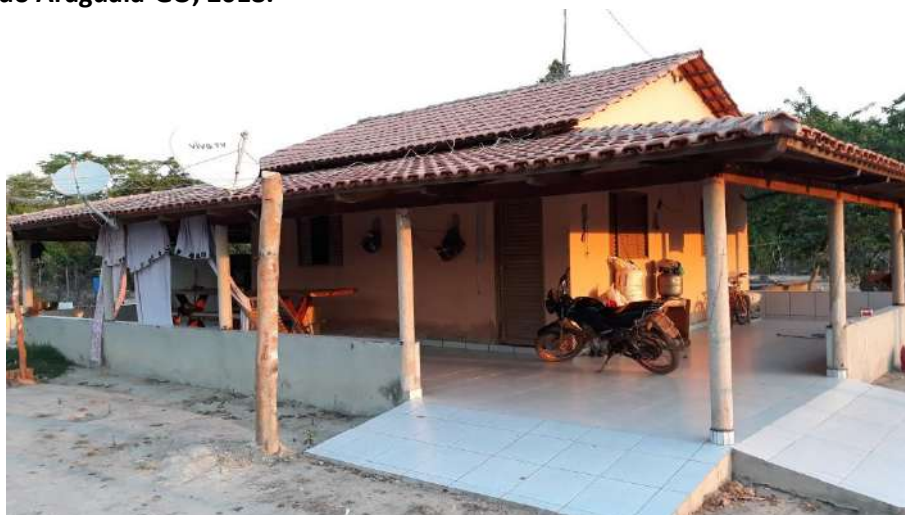
Foto 4.9 – Piso de residência constituído de cerâmica, identificado na Comunidade Gustavo Martins, São Miguel do Araguaia-GO, 2018.
