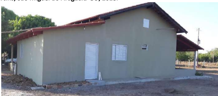
Foto 4.5 – Habitação construída de alvenaria com reboco e pintura, identificada na Comunidade Gustavo Martins, São Miguel do Araguaia-GO, 2018.
