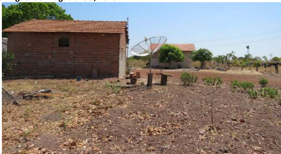
Foto 4.7 – Habitação construída de alvenaria sem reboco, identificada na Comunidade Gustavo Martins, São Miguel do Araguaia-GO, 2018.
