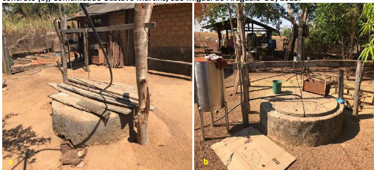
Foto 6.2 – Poço raso escavado tampado com madeira (a) e poço raso escavado com tampa de concreto (b), Comunidade Gustavo Martins, São Miguel do Araguaia-GO, 2018.
