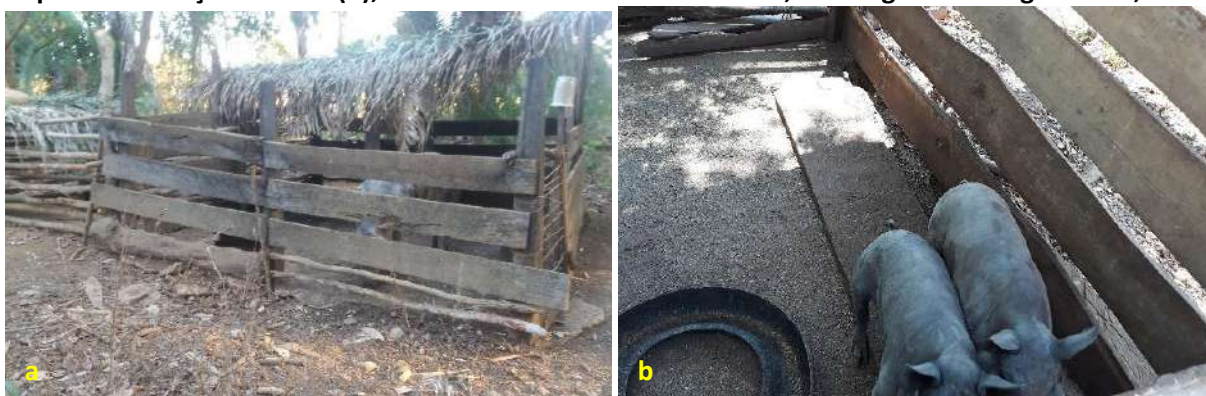
Foto 6.10 – Exemplo da presença de chiqueiro sem impermeabilização do solo (a) e com impermeabilização do solo (b), na Comunidade Gustavo Martins, São Miguel do Araguaia-GO, 2018.
