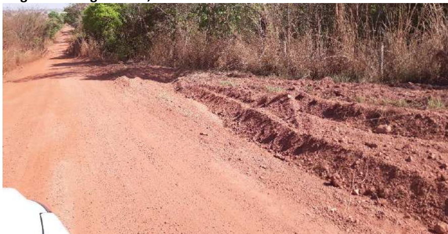
Foto 6.17 – Situação da drenagem pluvial: valeta na margem da via de acesso à Comunidade Gustavo Martins, São Miguel do Araguaia-GO, 2018.
