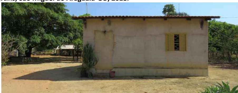
Foto 4.6 – Habitação construída de alvenaria com reboco sem pintura, identificada na Comunidade Gustavo Martins, São Miguel do Araguaia-GO, 2018.
