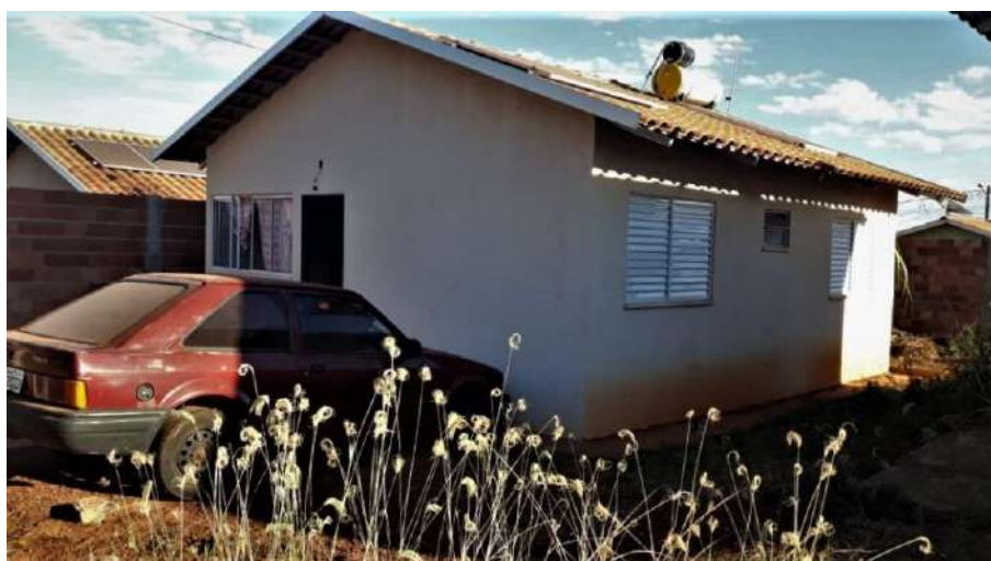
Foto 6.2 – Residência com aquecedor de água solar, na Comunidade Goianinha, Palmeiras de Goiás-GO, 2019.
