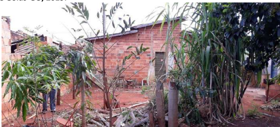
Foto 4.3 – Habitação construída de alvenaria sem reboco, identificada na Comunidade Goianinha, Palmeiras de Goiás-GO, 2019.
