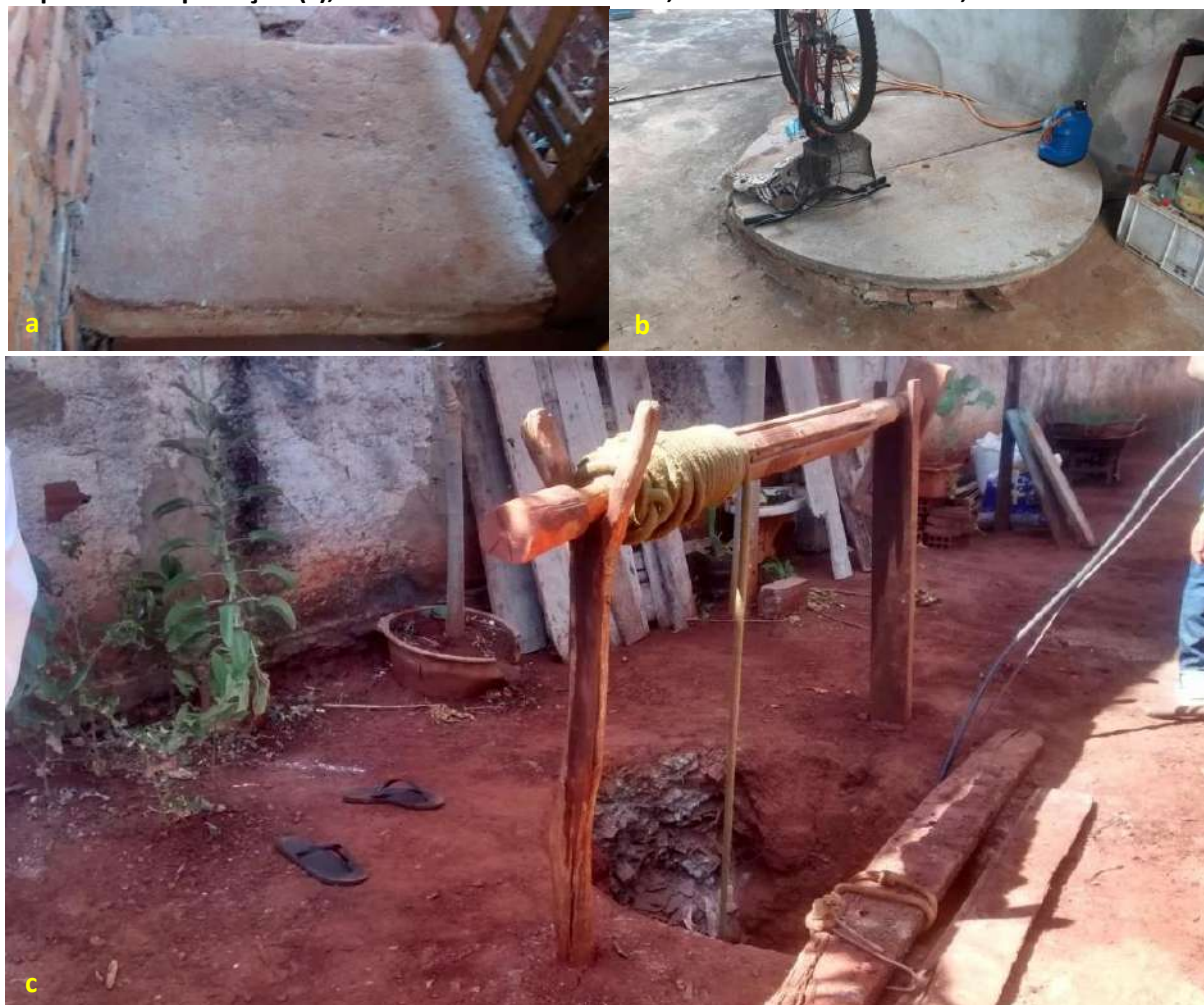
Foto 6.4 – Poço raso escavado com tampa em concreto (a), mureta de proteção (b) e outro sem dispositivo de proteção (c), na Comunidade Goianinha, Palmeiras de Goiás-GO, 2019.
