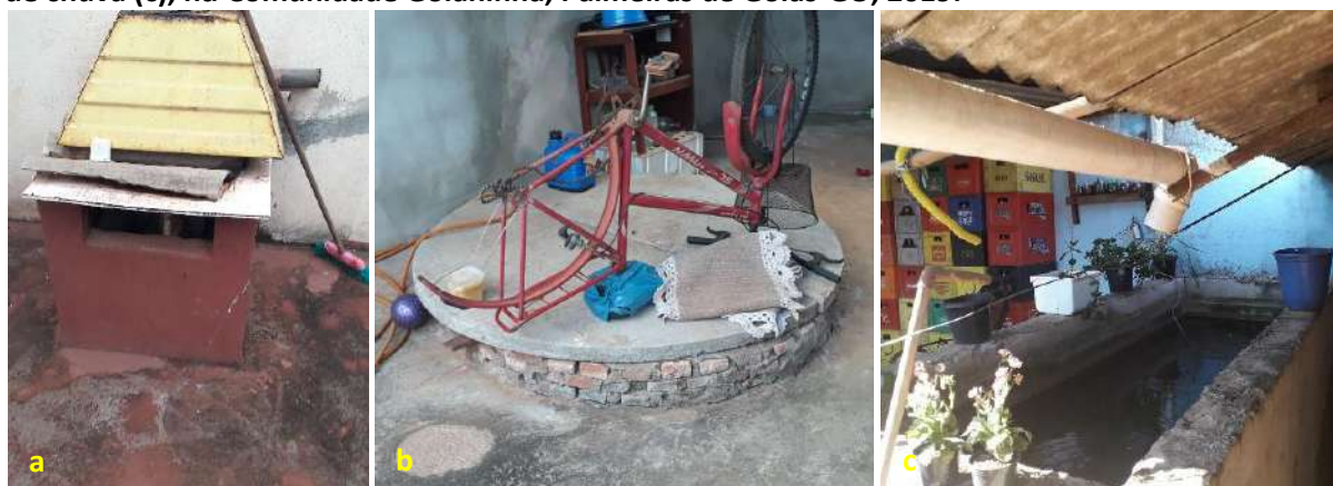
Foto 6.1 – Poço tubular raso (a), poço raso escavado (b) e reservatório para armazenamento da água de chuva (c), na Comunidade Goianinha, Palmeiras de Goiás-GO, 2019.
