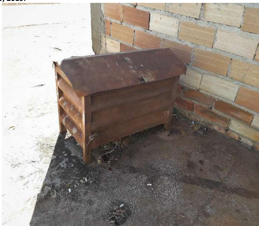
Foto 6.3 – Poço tubular raso protegido por estrutura metálica, na Comunidade Goianinha, Palmeiras de Goiás-GO, 2019.
