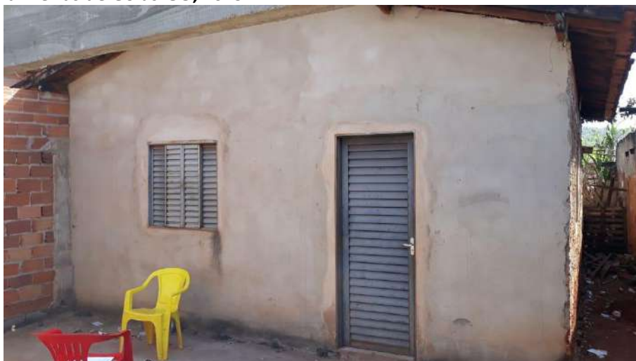
Foto 4.2 – Habitação construída de alvenaria com reboco sem pintura, identificada na Comunidade Goianinha, Palmeiras de Goiás-GO, 2019.
