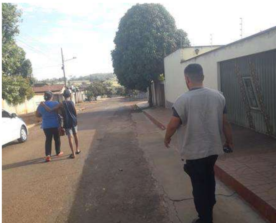
Foto 6.11 – Rua pavimentada com meio fio e sarjeta na Comunidade Goianinha, Palmeiras de Goiás-GO, 2019.
