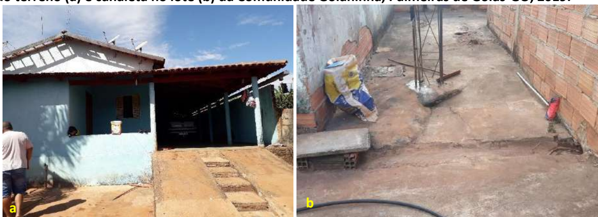
Foto 6.12 – Dispositivos de prevenção dos danos provocados pelas águas: residência acima do nível do terreno (a) e canaleta no lote (b) da Comunidade Goianinha, Palmeiras de Goiás-GO, 2019.
