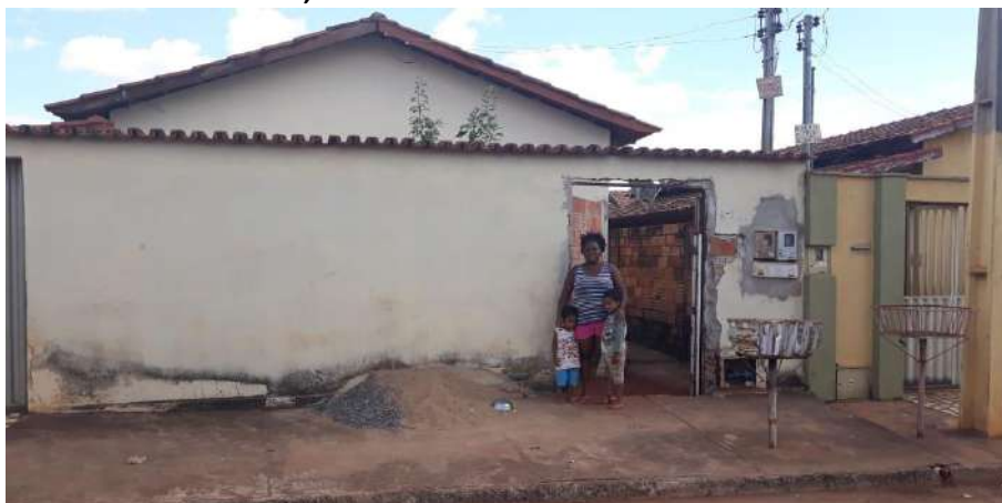
Foto 4.4 – Habitação construída de alvenaria com reboco e pintura, identificada na Comunidade Goianinha, Palmeiras de Goiás-GO, 2019.
