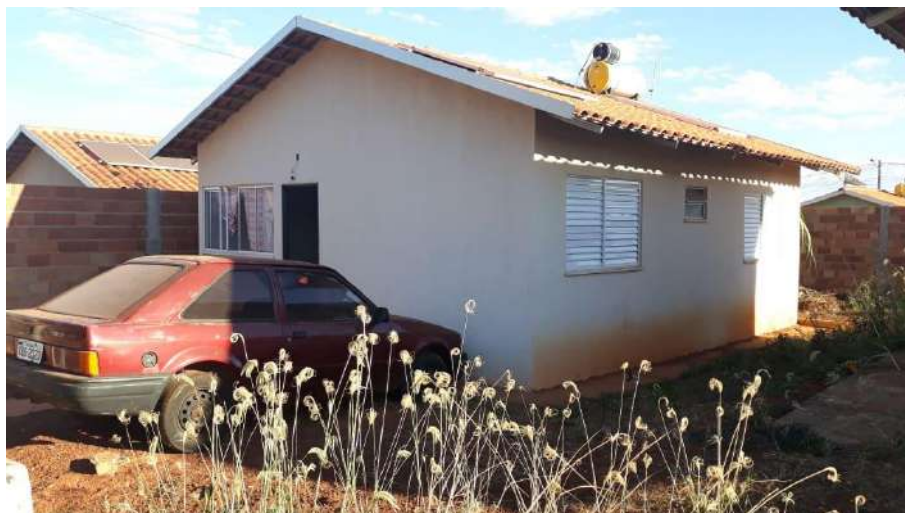
Foto 4.7 – Cobertura de telha de barro, identificada na Comunidade Goianinha, Palmeiras de Goiás- GO, 2019.
