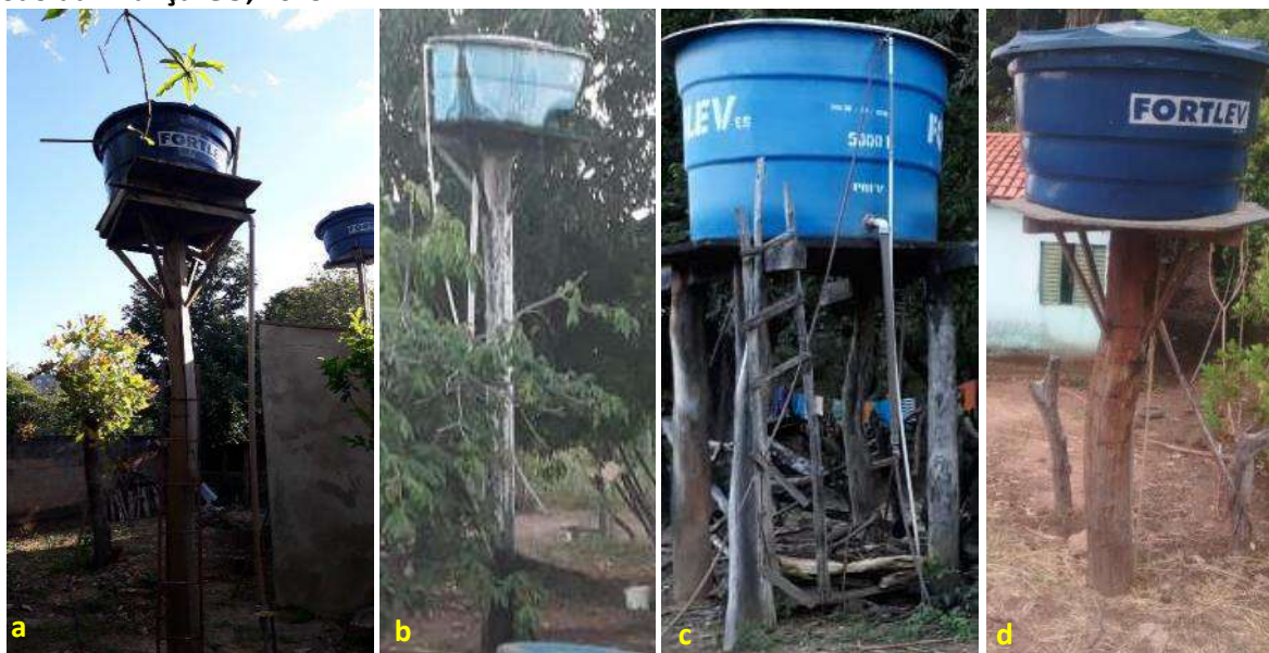
Foto 6.6 – Reservatórios domiciliares em diferentes situações e materiais, sendo um em polietileno com extravasor (a), em fibra de vidro, com e sem sinal de transbordamento (b) (c) e outro em polietileno instalado sobre estrutura de madeira com pilar central (d), na Comunidade do Forte, São João da Aliança-GO, 2019.
