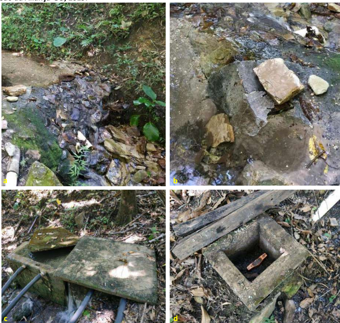
Foto 6.2 – Captação de água do SAA, composta por barragem de regularização de nível (a), gradeamento improvisado (b), caixa de passagem (c) e registro (d), na Comunidade do Forte, São João da Aliança-GO, 2019.
