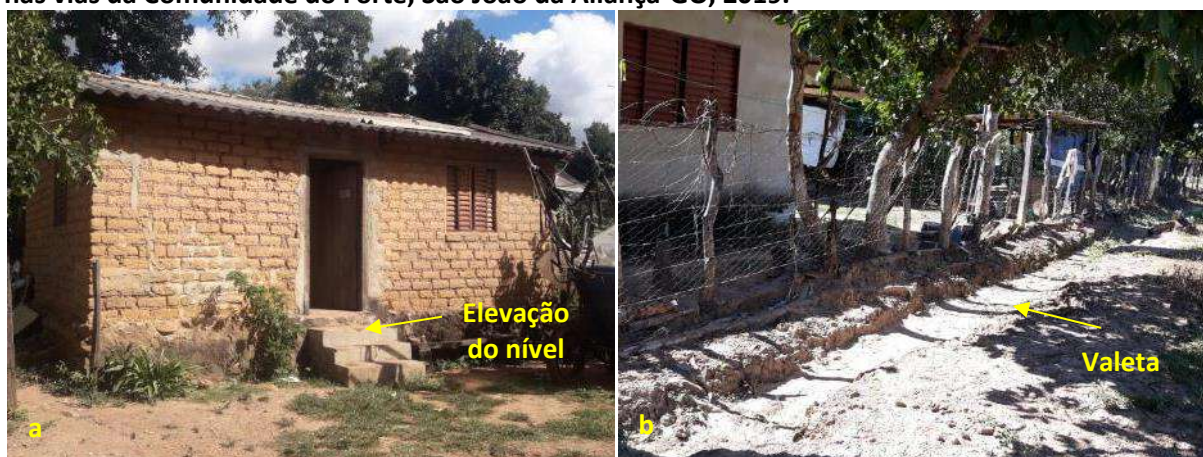
Foto 6.20 – Dispositivos de prevenção dos danos provocados pelas águas (a) nas residências e (b) nas vias da Comunidade do Forte, São João da Aliança-GO, 2019.
