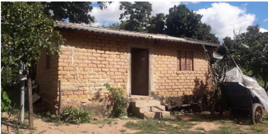
Foto 4.11 – Habitação construída de adobe, identificada na Comunidade do Forte, São João da Aliança-GO, 2019.
