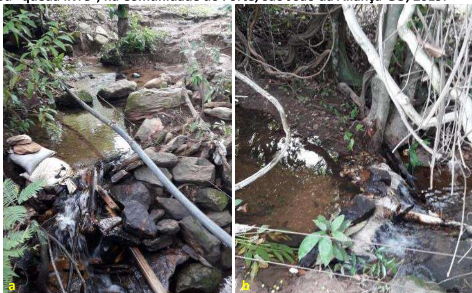
Foto 6.4 – Barragens construídas para captação da água vinda da nascente, chamada manancial “pé de serra” ou “queda livre”, na Comunidade do Forte, São João da Aliança-GO, 2019.
