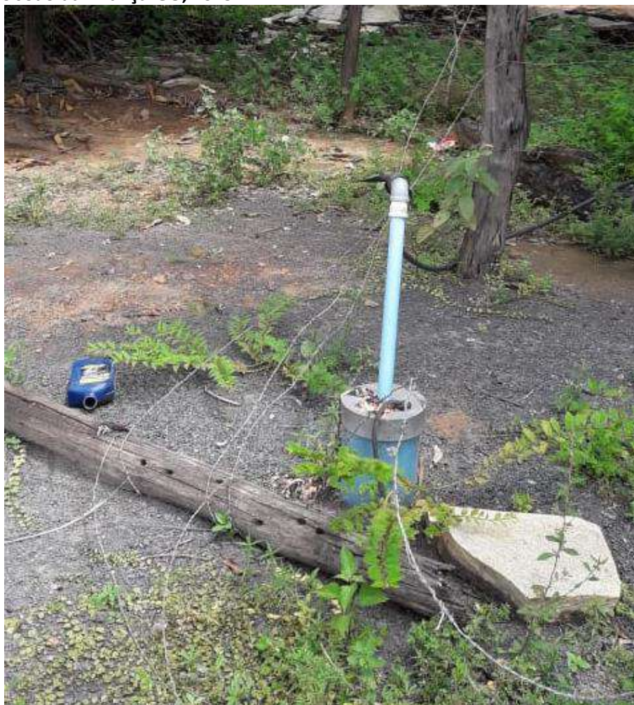
Foto 6.1 – Poço tubular profundo desativado, construído com recurso da FUNASA, na Comunidade do Forte, São João da Aliança-GO, 2019.
