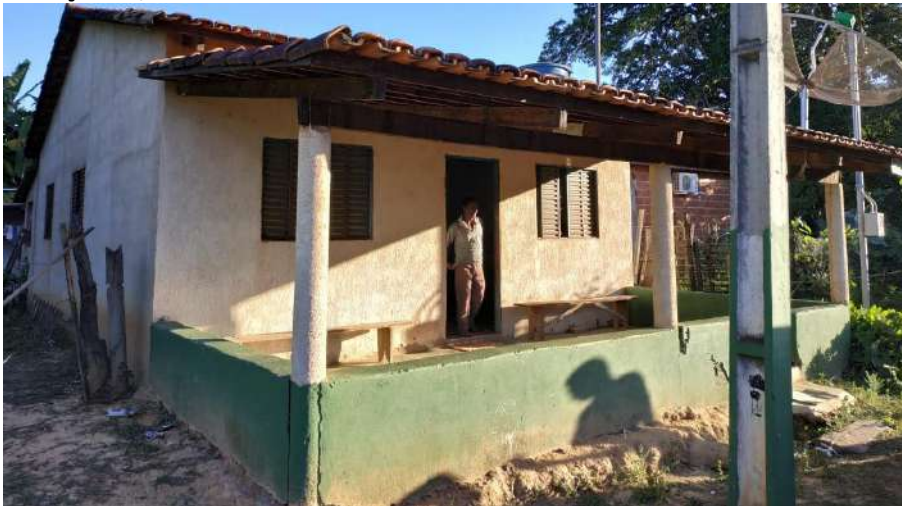
Foto 4.10 – Habitação construída de alvenaria com reboco, identificada na Comunidade do Forte, São João da Aliança-GO, 2019.
