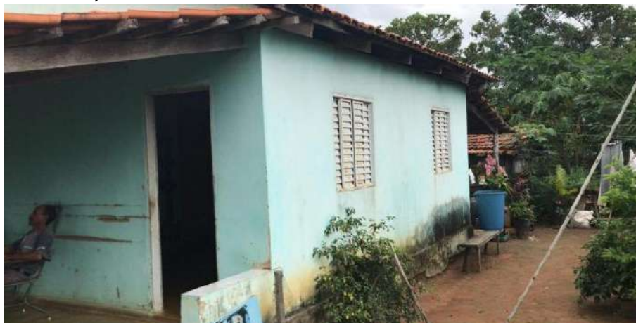
Foto 4.1 – Habitação construída de alvenaria com reboco e pintura, identificada na Comunidade Fortaleza, Piranhas-GO, 2018.
