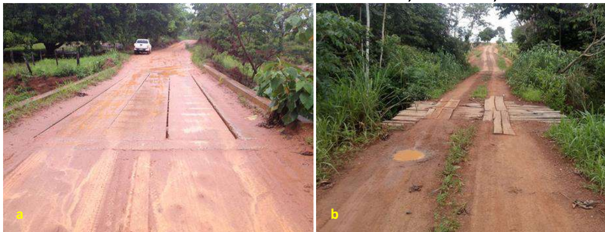
Foto 6.18 – Pontes sobre fundos de vale na Comunidade Fortaleza, Piranhas-GO, 2018.
