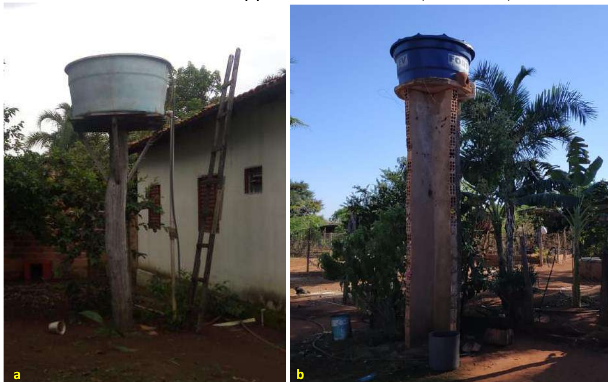
Foto 6.5 – Reservatórios domiciliares instalados sobre diferentes estruturas, sendo um reservatório de fibrocimento instalado sobre estrutura de madeira (a) e o outro reservatório de polietileno instalado sobre estrutura de alvenaria (b) na Comunidade Fortaleza, Piranhas-GO, 2018.
