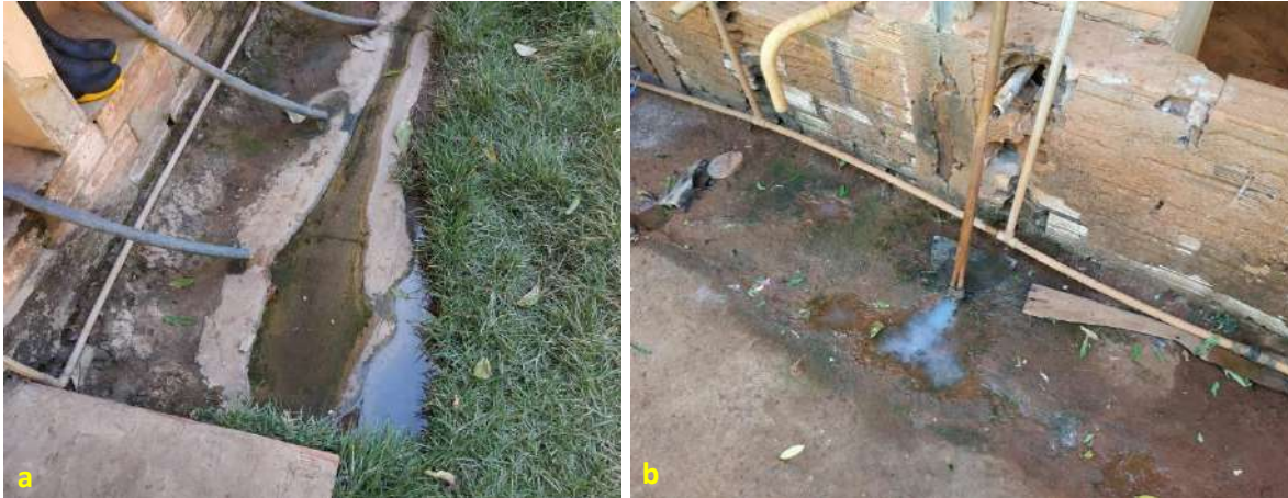
Foto 6.8 – Lançamento e acúmulo de água cinza proveniente da pia da cozinha diretamente no solo do quintal próximo aos domicílios (a) e (b) na Comunidade Fortaleza, Piranhas-GO, 2018.
