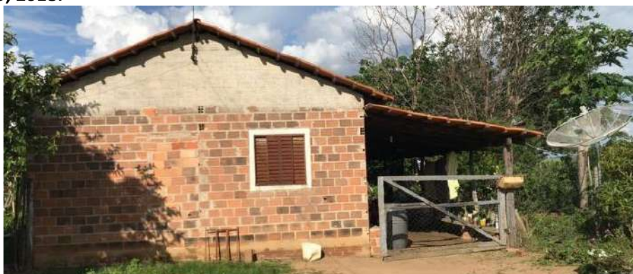
Foto 4.3 – Habitação construída de alvenaria sem reboco, identificada na Comunidade Fortaleza, Piranhas-GO, 2018.
