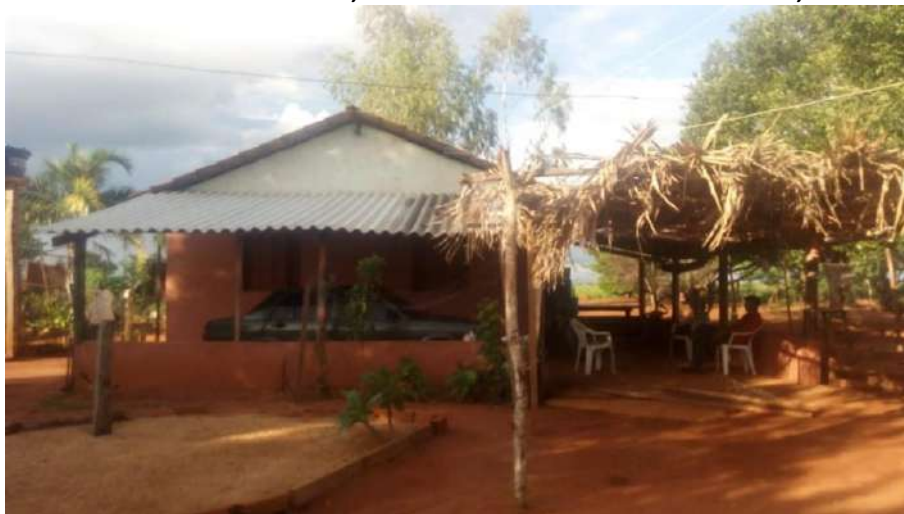
Foto 4.6 – Cobertura de telha fibrocimento, identificada na Comunidade Fortaleza, Piranhas-GO, 2018.
