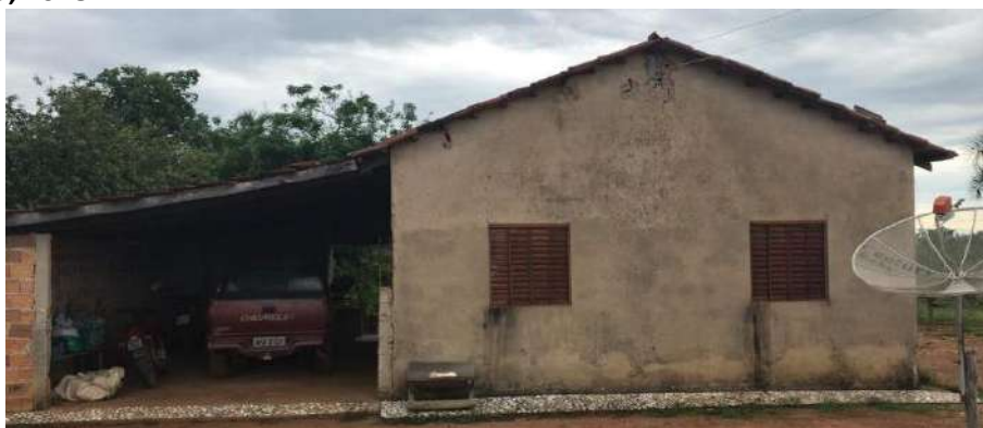
Foto 4.2 – Habitação construída de alvenaria com reboco, identificada na Comunidade Fortaleza, Piranhas-GO, 2018.
