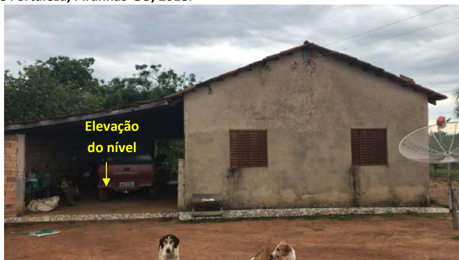
Foto 6.24 – Dispositivo de prevenção dos danos provocados pelas águas em residência da Comunidade Fortaleza, Piranhas-GO, 2018.
