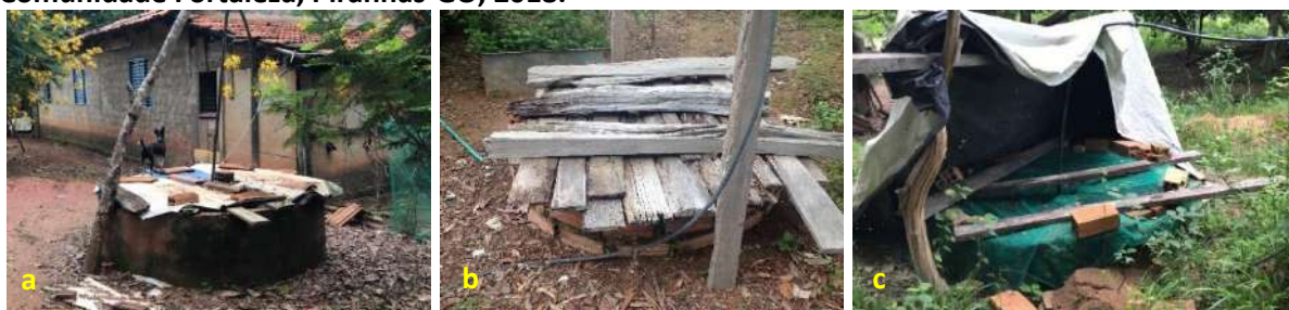
Foto 6.3 – Poços rasos escavados em diferentes condições, sendo com existência de mureta de proteção (a) e coberto com pedaços de madeira e outros materiais de forma improvisada (b; c) na Comunidade Fortaleza, Piranhas-GO, 2018.
