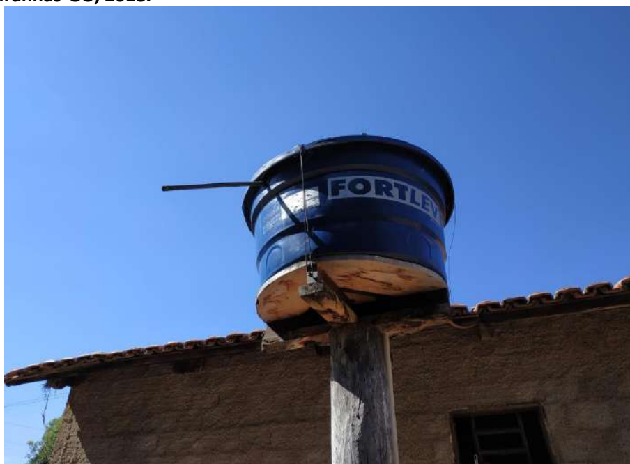
Foto 6.4 – Reservatório domiciliar de polietileno com extravasor e tampa amarrada na Comunidade Fortaleza, Piranhas-GO, 2018.
