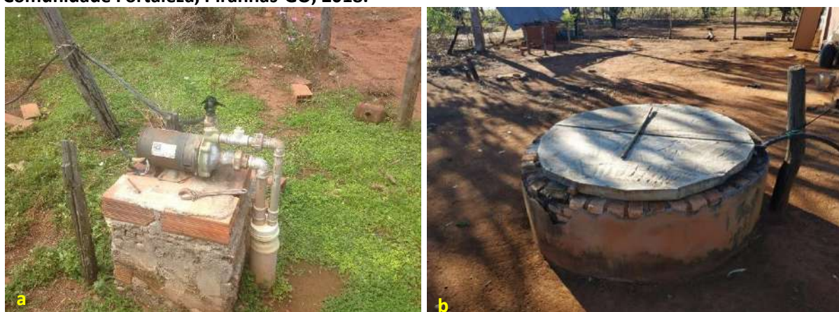
Foto 6.1 – Fontes de abastecimento de água: poço tubular raso (a) e poço raso escavado (b) na Comunidade Fortaleza, Piranhas-GO, 2018.
