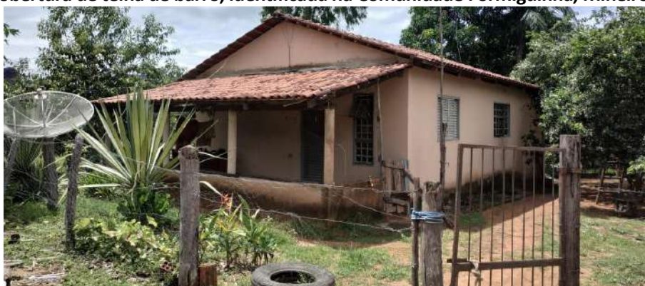
Foto 4.9 – Cobertura de telha de barro, identificada na Comunidade Formiguinha, Mineiros-GO, 2019.
