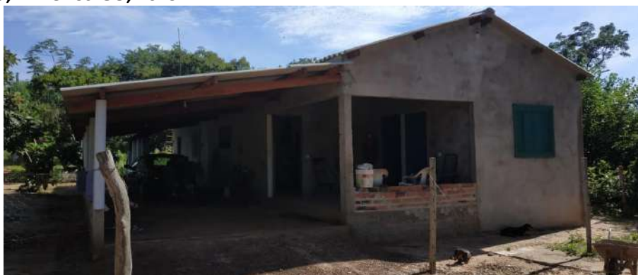
Foto 4.5 – Habitação construída de alvenaria com reboco sem pintura, identificada na Comunidade Formiguinha, Mineiros-GO, 2019.
