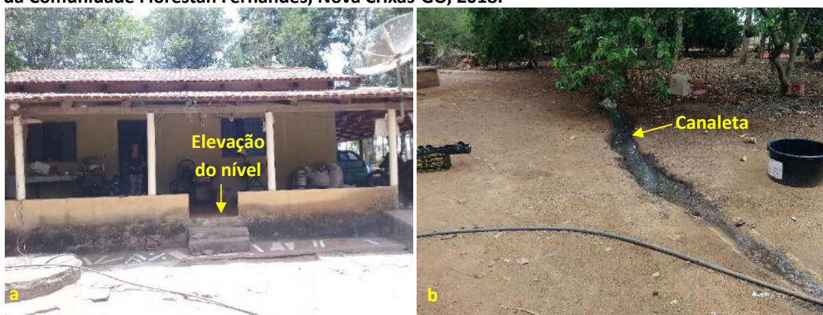
Foto 6.21 – Dispositivos de prevenção dos danos provocados pelas águas em residência (a) e lote (b) da Comunidade Florestan Fernandes, Nova Crixás-GO, 2018.
