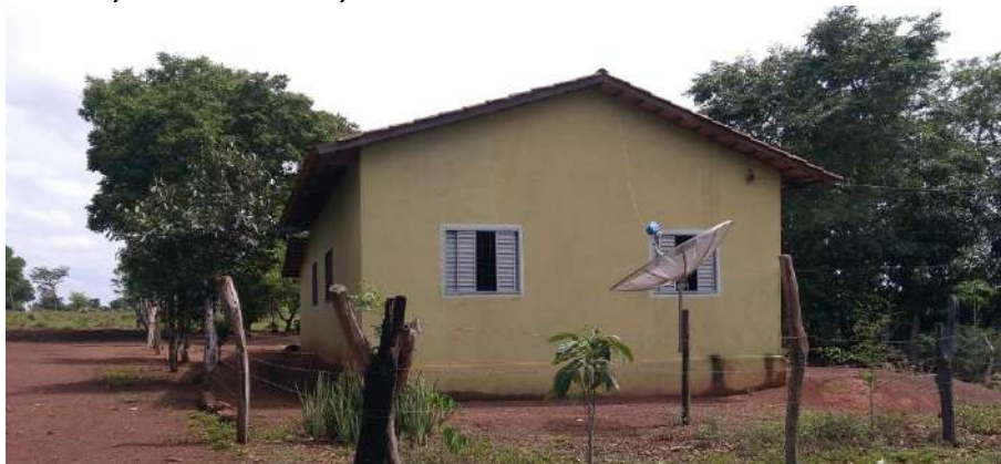
Foto 4.7 – Habitação construída de alvenaria com reboco e pintura, identificada na Comunidade Florestan Fernandes, Nova Crixás-GO, 2018.
