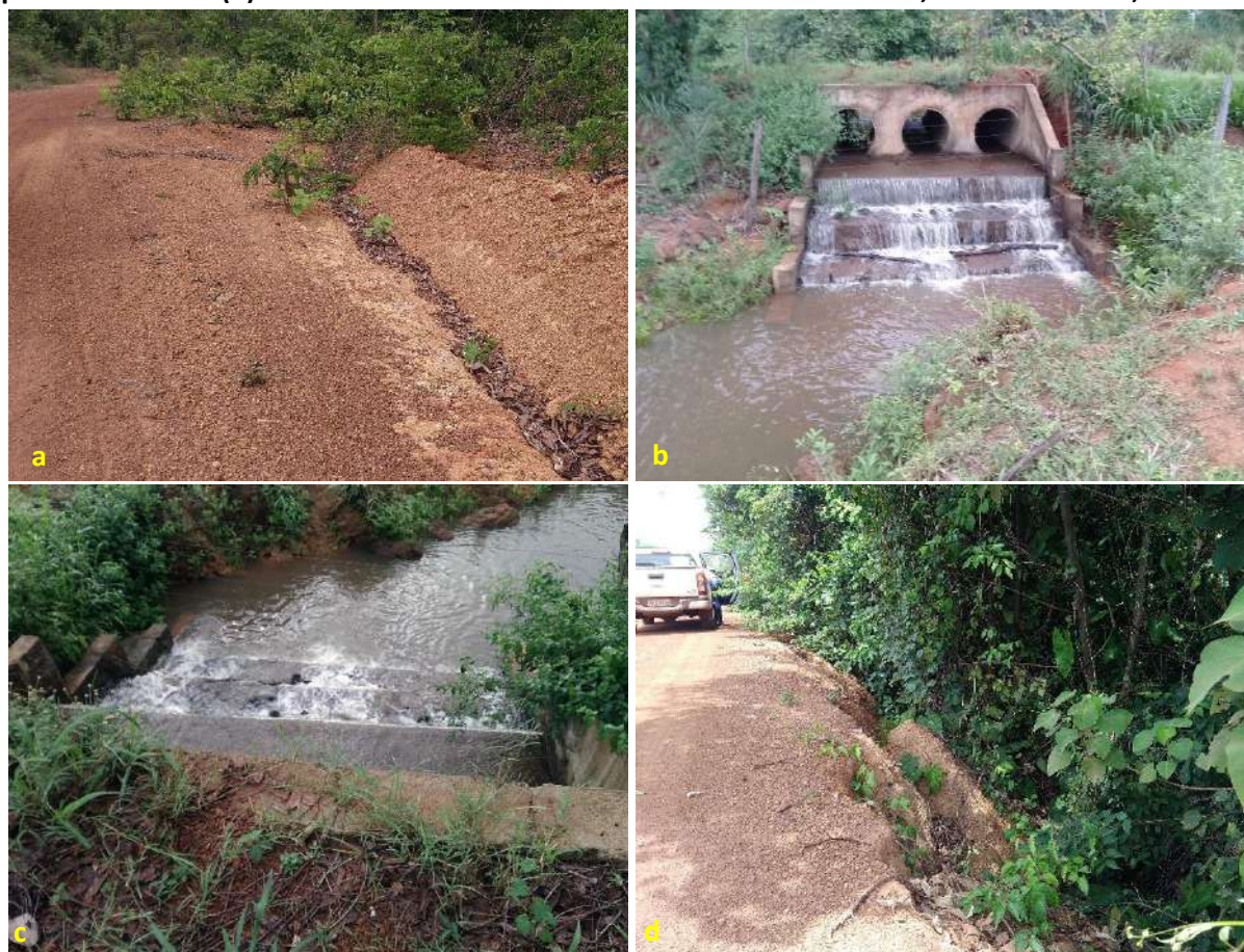
Foto 6.19 – Valeta (a), condutos de drenagem (b), dissipador de energia em fundo de vale (c) e processo erosivo (d) na via de acesso à Comunidade Florestan Fernandes, Nova Crixás-GO, 2018.
