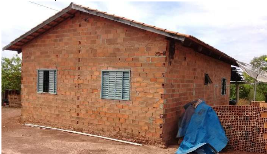
Foto 4.9 – Habitação construída de alvenaria sem reboco, identificada na Comunidade Florestan Fernandes, Nova Crixás-GO, 2018.
