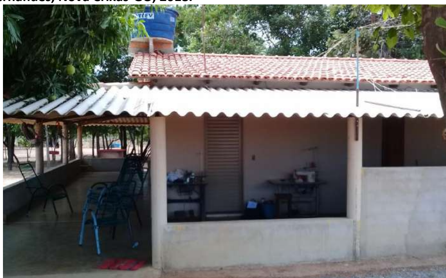
Foto 4.12 – Piso de residência constituído de cimento queimado, identificado na Comunidade Florestan Fernandes, Nova Crixás-GO, 2018.
