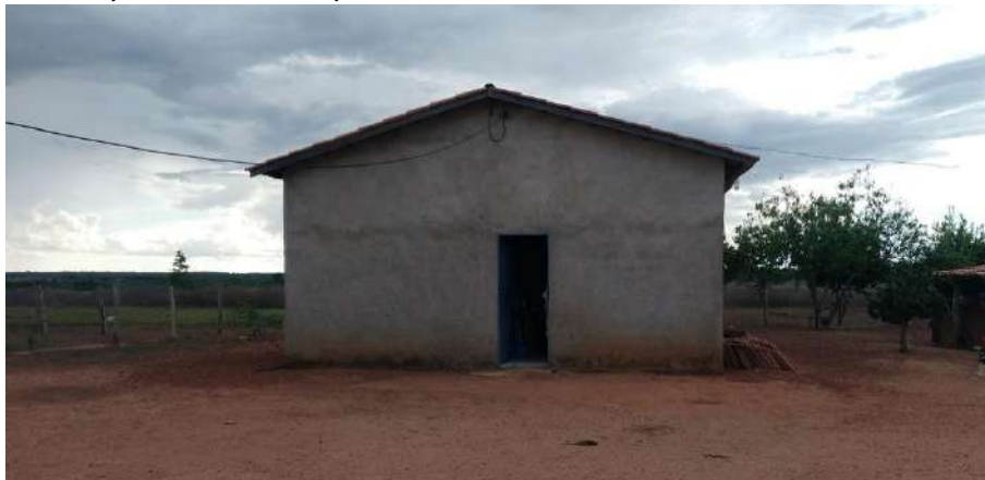
Foto 4.8 – Habitação construída de alvenaria com reboco sem pintura, identificada na Comunidade Florestan Fernandes, Nova Crixás-GO, 2018.
