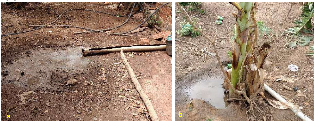
Foto 6.9 – Lançamento e acúmulo de água cinza proveniente da pia da cozinha diretamente no solo do quintal próximo aos domicílios (a) e (b), na Comunidade Florestan Fernandes, Nova Crixás-GO, 2018.
