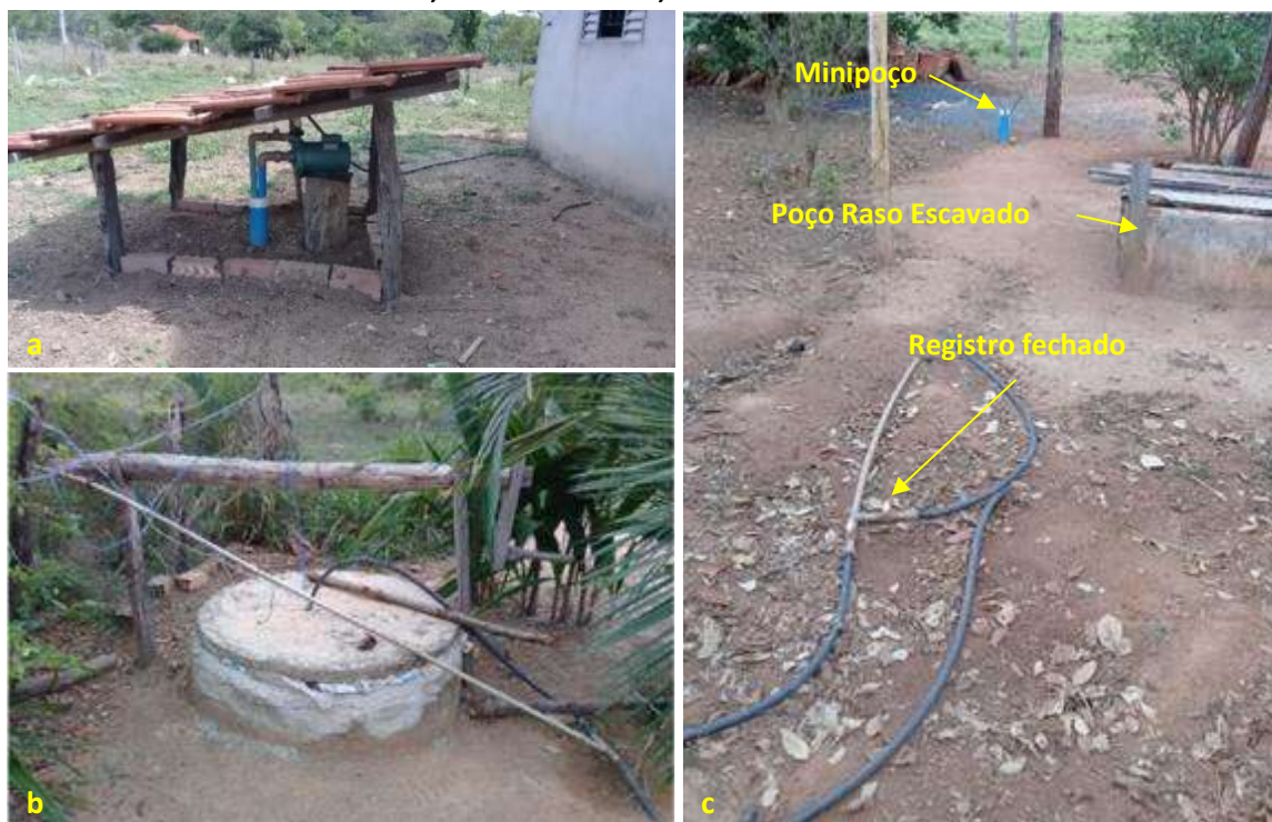
Foto 6.1 – Poço tubular raso (a), poço raso escavado (b) e ambas as fontes (c) presentes na Comunidade Florestan Fernandes, Nova Crixás-GO, 2018.
