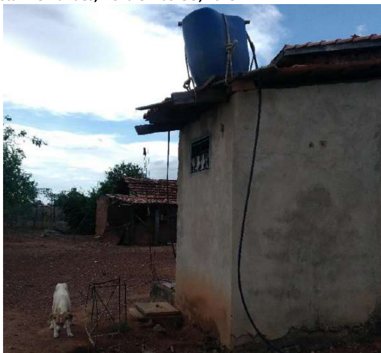
Foto 6.6 – Reservatório domiciliar construído de forma improvisada em um domicílio da Comunidade Florestan Fernandes, Nova Crixás-GO, 2018.
