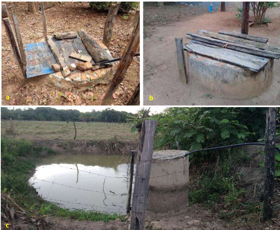
Foto 6.3 – Poço raso escavado com tampas feitas com materiais improvisados, tais como placa metálica (a), tábuas (b) e outro próximo a um represamento (c), na Comunidade Florestan Fernandes, Nova Crixás-GO, 2018.
