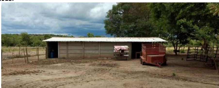
Foto 4.14 – Cobertura de fibrocimento, identificada na Comunidade Florestan Fernandes, Nova Crixás-GO, 2018.
