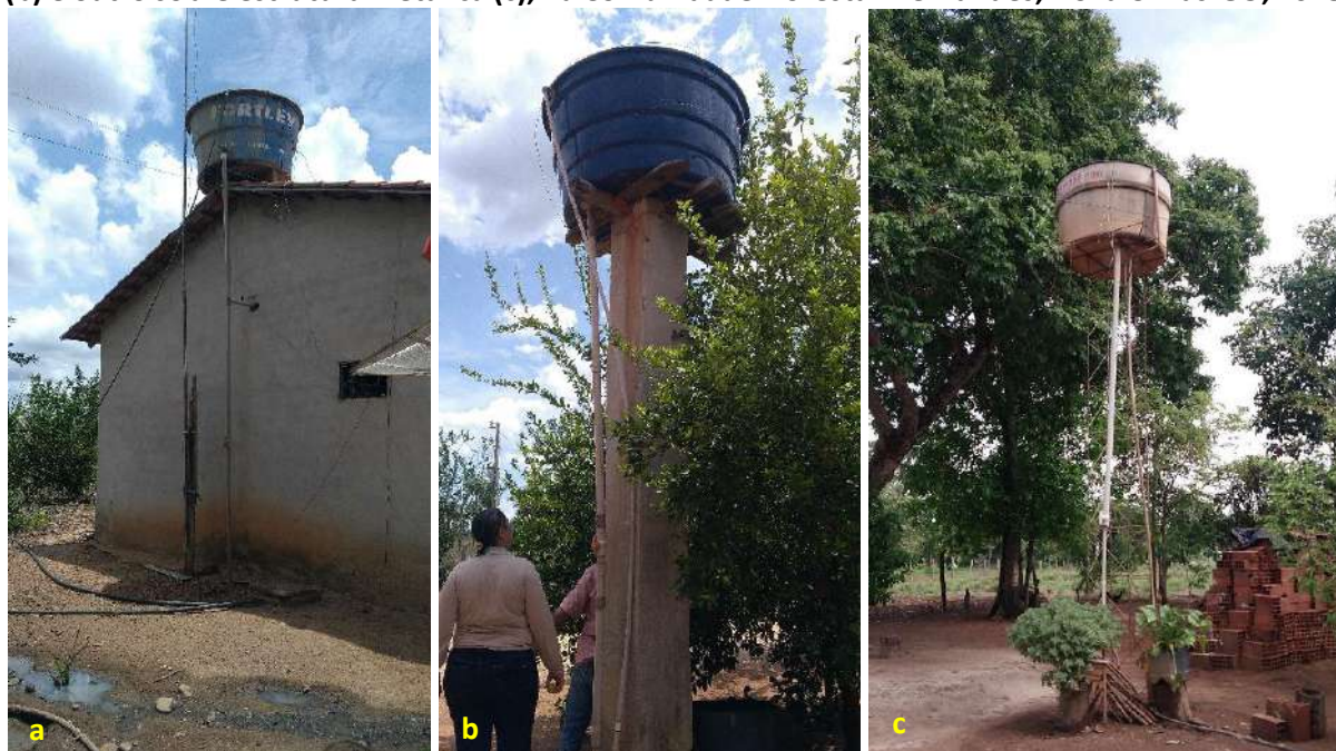
Foto 6.7 – Reservatório domiciliar instalado sobre o telhado da casa (a), sobre estrutura em concreto (b) e outro sobre estrutura metálica (c), na Comunidade Florestan Fernandes, Nova Crixás-GO, 2018.
