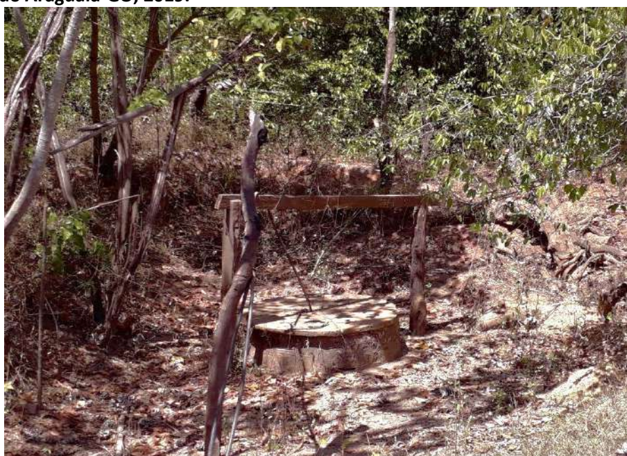
Foto 6.4 – Poço raso escavado com alguns dos dispositivos de proteção, Comunidade Fio Velasco, São Miguel do Araguaia-GO, 2019.
