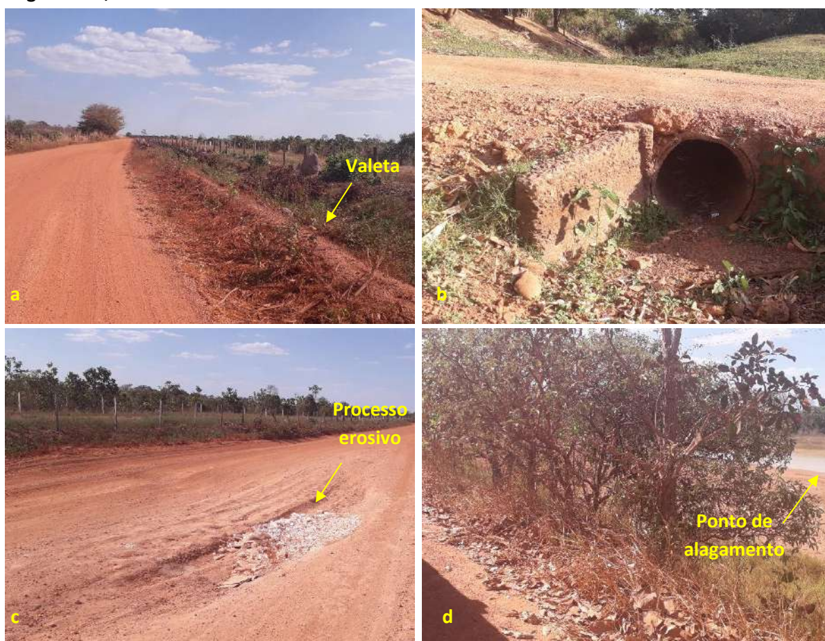
Foto 6.16 – Situação da drenagem pluvial: valeta de infiltração (a), bueiro (b), processo erosivo (c) e ponto de alagamento (d) nas vias de acesso e internas da Comunidade Fio Velasco, São Miguel do Araguaia-GO, 2019.
