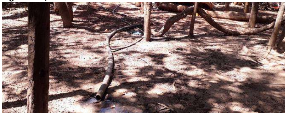
Foto 6.8 – Lançamento e acúmulo de água cinza proveniente do lavatório de louças e lavagem de roupas diretamente no solo do quintal próximo aos domicílios, na Comunidade Fio Velasco, São Miguel do Araguaia-GO, 2019.
