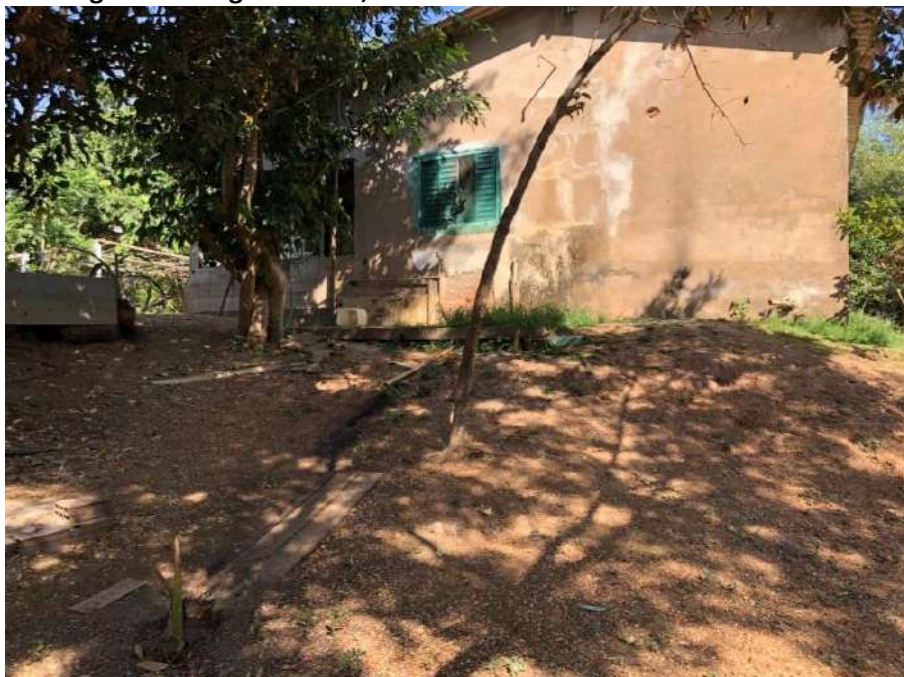
Foto 4.6 – Habitação construída de alvenaria com reboco sem pintura identificada na Comunidade Fio Velasco, São Miguel do Araguaia – GO, 2019.
