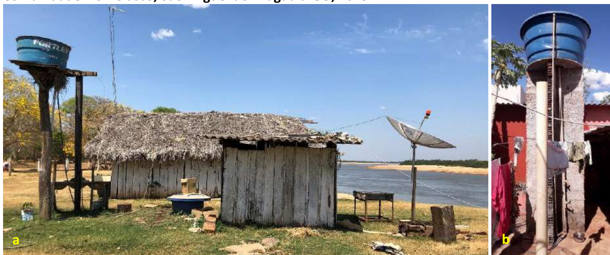
Foto 6.6 – Reservatório intalado sobre estrutura de madeira (a) e sobre estrutura em alvenaria (b), Comunidade Fio Velasco, São Miguel do Araguaia-GO, 2019.
