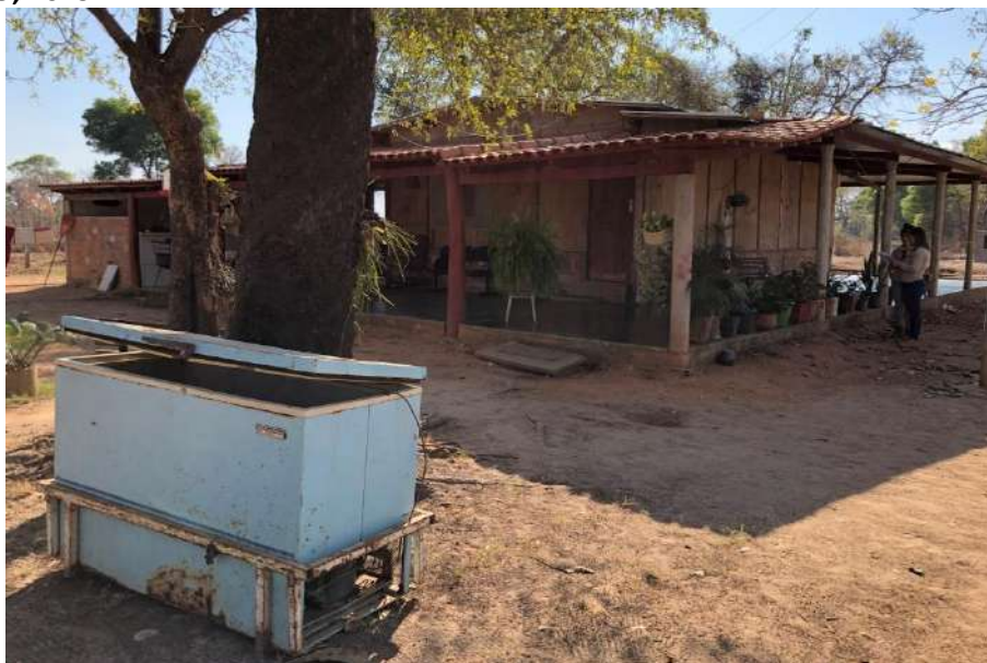
Foto 4.11 – Cobertura de telha de barro identificada na Comunidade Fio Velasco, São Miguel do Araguaia-GO, 2019.
