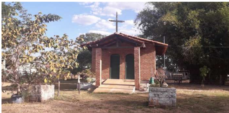
Foto 4.1 – Capela, visão externa, identificada na Comunidade Fio Velasco, São Miguel do Araguaia-GO, 2019.
