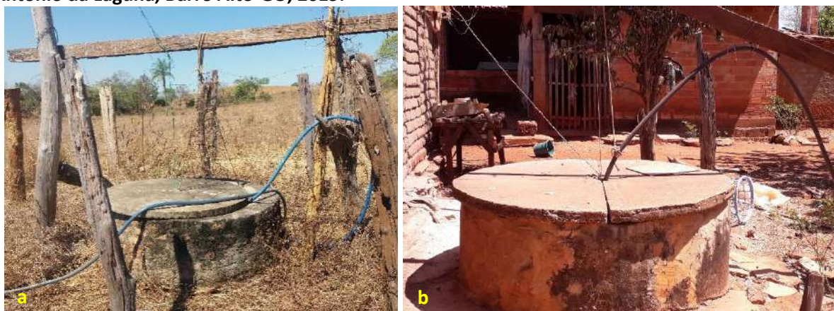
Foto 6.6 – Poço raso escavado tampado com mureta (a) e (b), na Comunidade da Fazenda Santo Antônio da Laguna, Barro Alto-GO, 2019.
