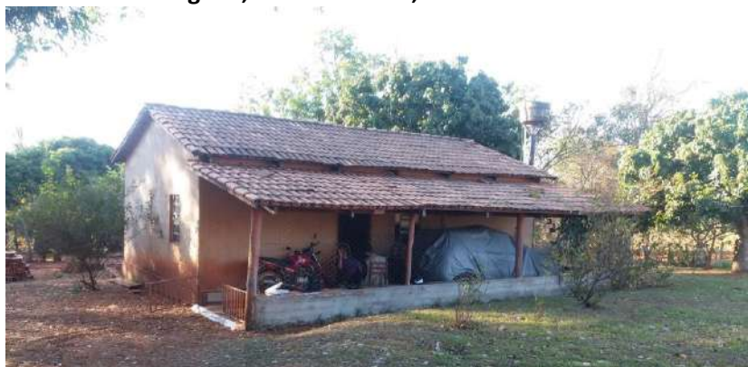
Foto 4.12 – Habitação construída de alvenaria com reboco sem pintura, identificada na Comunidade da Fazenda Santo Antônio da Laguna, Barro Alto-GO, 2019.
