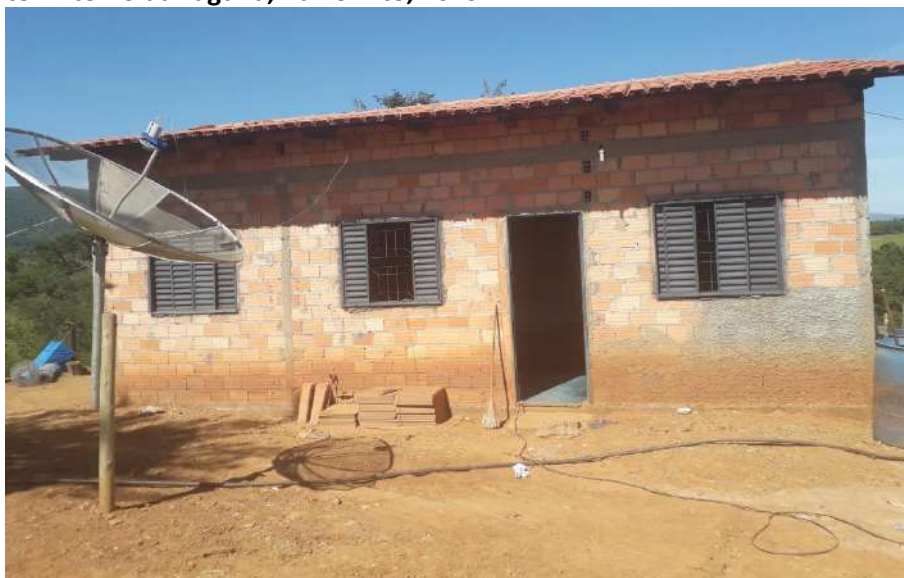
Foto 4.14 – Piso de residência constituído de cimento queimado, identificado na Comunidade da Fazenda Santo Antônio da Laguna, Barro Alto, 2019.
