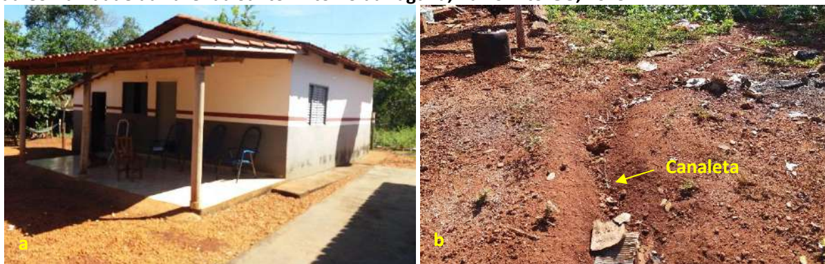
Foto 6.25 – Dispositivos de prevenção dos danos provocados pelas águas em residência (a) e lote (b) da Comunidade da Fazenda Santo Antônio da Laguna, Barro Alto-GO, 2019.
