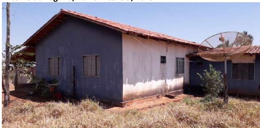
Foto 4.13 – Habitação construída de alvenaria com reboco e pintura, identificada na Comunidade da Fazenda Santo Antônio da Laguna, Barro Alto-GO, 2019.
