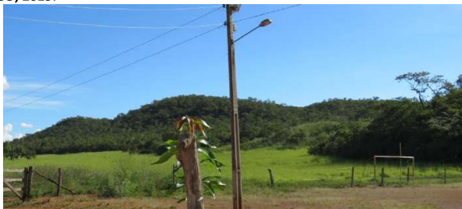
Foto 4.10 – Iluminação pública identificada na Comunidade da Fazenda Santo Antônio da Laguna, Barro Alto-GO, 2019.
