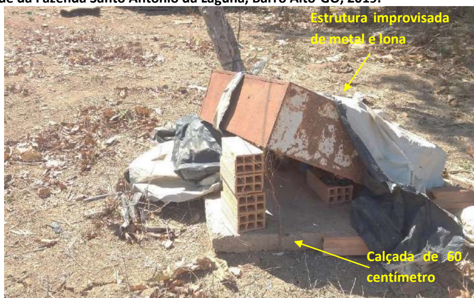
Foto 6.3 – Poço raso com calçamento e proteção por estrutura improvisada de metal e lona, na Comunidade da Fazenda Santo Antônio da Laguna, Barro Alto-GO, 2019.
