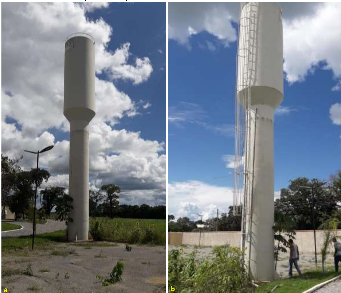
Foto 6.3 – Reservatório para o armazenamento de água, construído em matéria metálico, com capacidade de armazenamento de aproximadamente 15 m 3 (a), protegido por muro e portão (b), na Comunidade de Extrema, Iaciara-GO, 2019.
