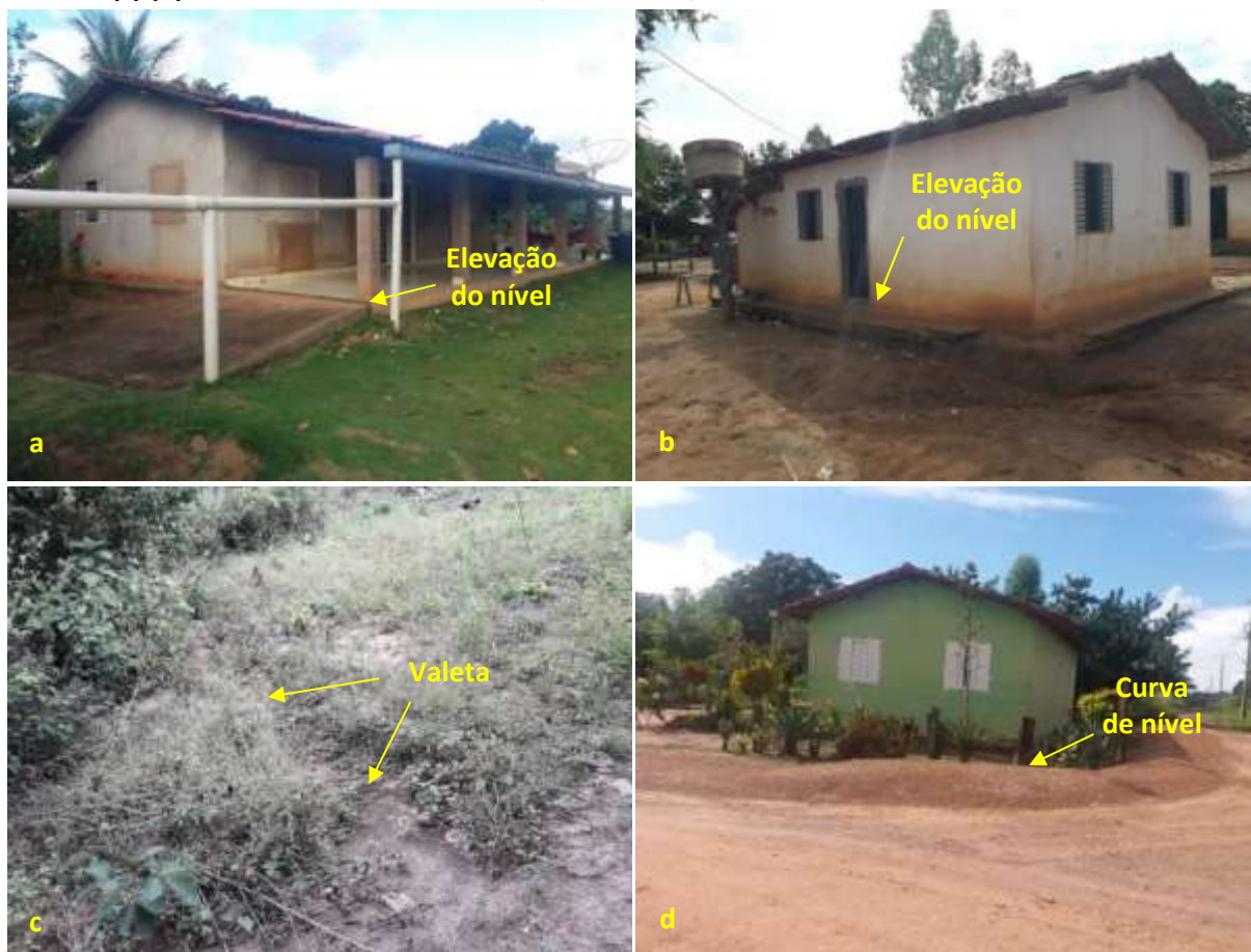
Foto 6.16 – Dispositivos de prevenção dos danos provocados pelas águas nas residências (a) (b) e nas vias (c) (d) da Comunidade de Extrema, Iaciara-GO, 2019.
