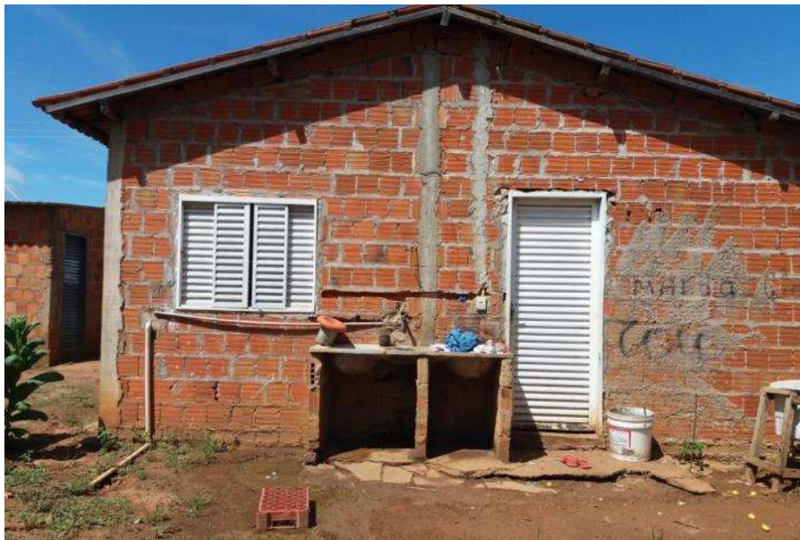
Foto 4.15 – Cobertura de telha de barro, identificada na Comunidade de Extrema, Iaciara-GO, 2019.
