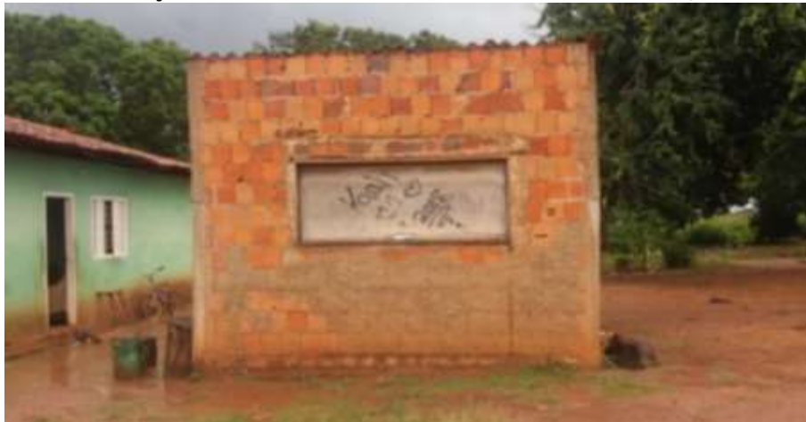
Foto 4.6 – Sede da associação local identificada na Comunidade de Extrema, Iaciara-GO, 2019.
