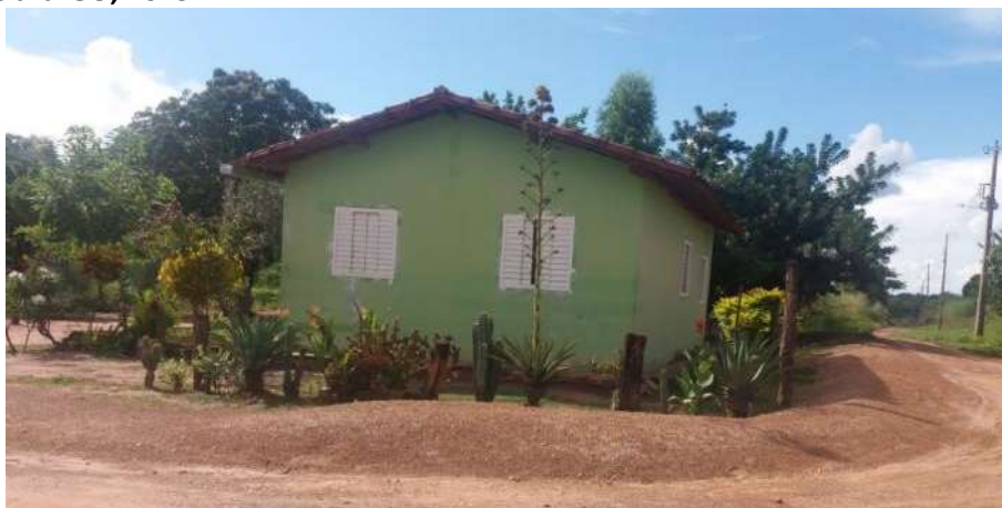
Foto 4.11 – Habitação construída de alvenaria com reboco e pintura, identificada na Comunidade de Extrema, Iaciara-GO, 2019.
