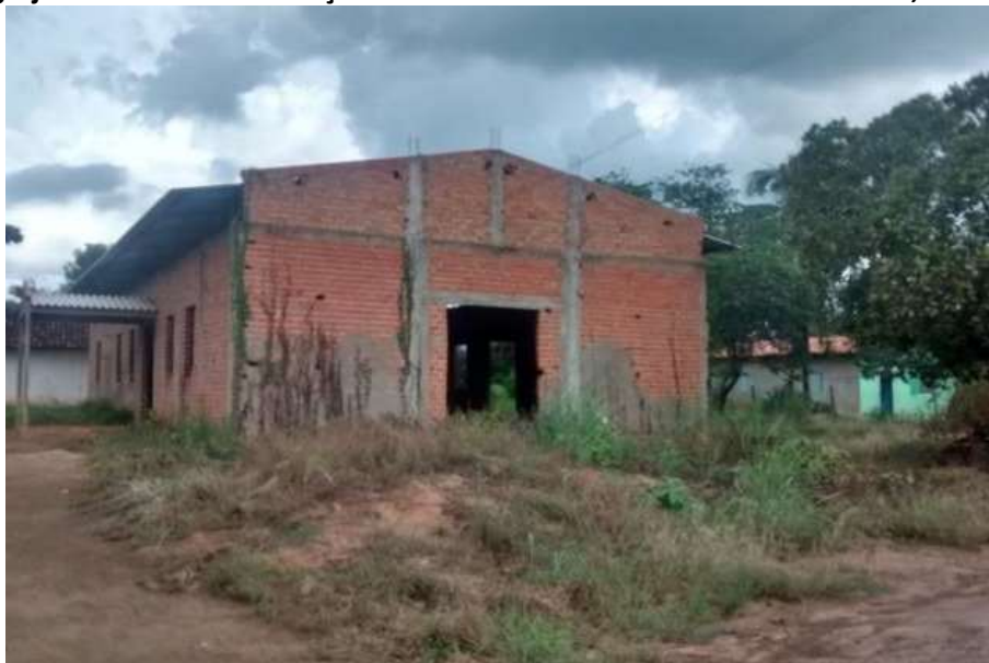
Foto 4.3 – Igreja católica em construção identificada na Comunidade de Extrema, Iaciara-GO, 2019.
