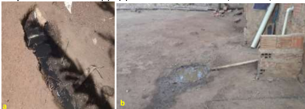
Foto 6.6 – Lançamento e acúmulo de água cinza proveniente da pia da cozinha diretamente no solo do quintal próximo aos domicílios (a) e (b) na Comunidade de Extrema, Iaciara-GO, 2019.
