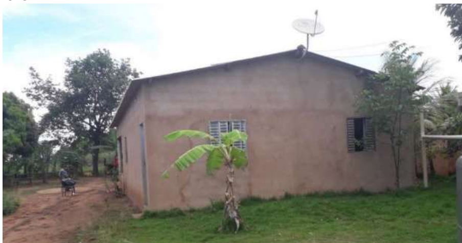
Foto 4.10 – Habitação construída de alvenaria com reboco, identificada na Comunidade de Extrema, Iaciara-GO, 2019.
